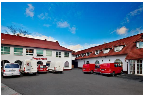
Obr.1 – Komplex budov MASO-PROFIT s.r.o., pohled ze dvora
