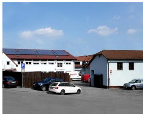
Obr.2 – Komplex budov MASO-PROFIT s.r.o., pohled z ulice
