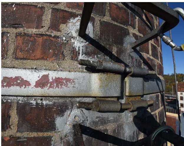
Obrázek 28: Stažení ocelové obruče závitovými tyčemi
