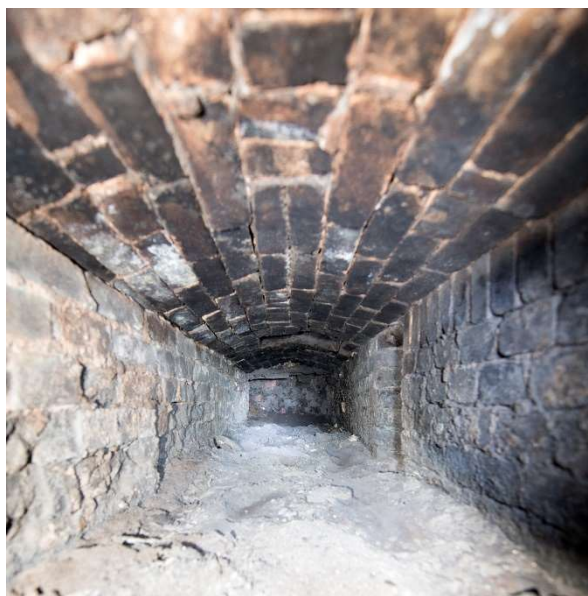
Obrázek 21: Vnitřek kouřového kanálu
