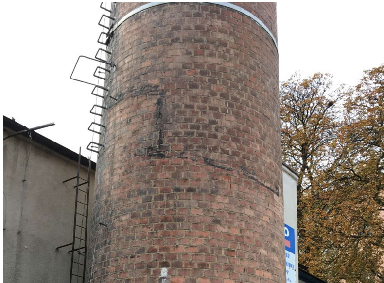
Obrázek 18: Pozůstatky hydroizolace střechy bývalé sušárny
