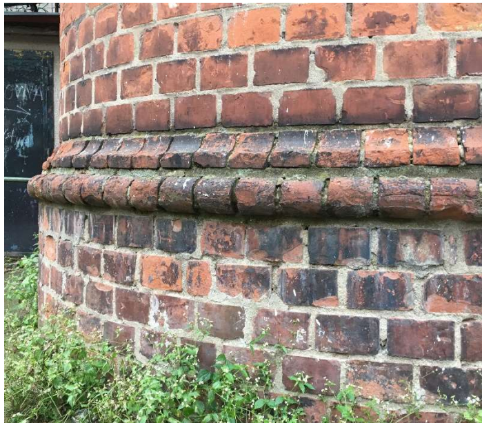
Obrázek 24: Římsa u podstavce komína
