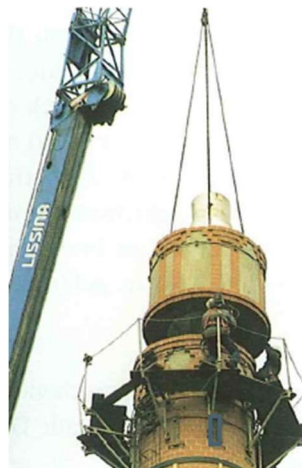
Obrázek 59: Umístění hlavice pomocí jeřábu [27]
