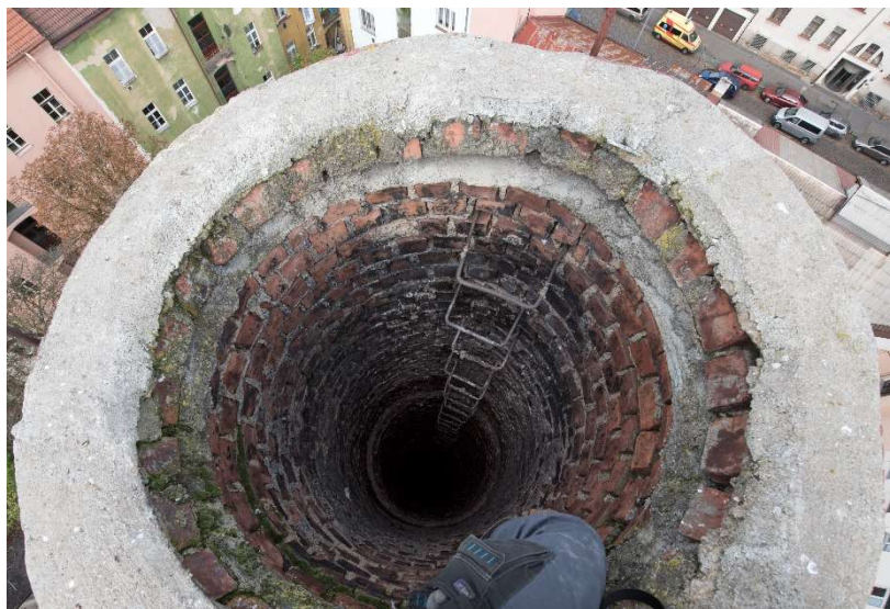
Obrázek 27: Betonová mazanina na hlavě komína
