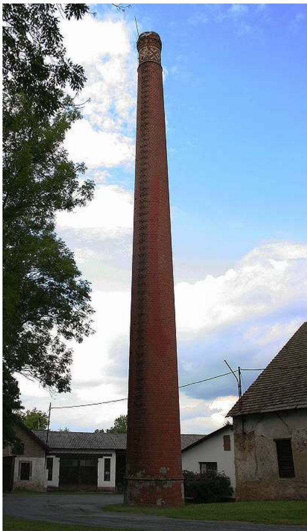
Obrázek 19: Komín bývalé sklárny v Nových Mitrovicích [6]
