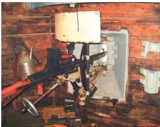
Obr. 35 Osazení lehkého kulometu do střílny
