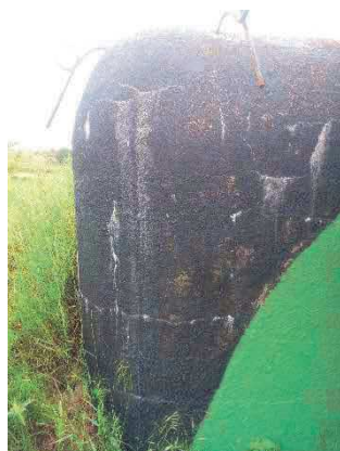
Obr. 105, 106, 107 Projevy poruch vzniklé po rekonstrukci – vápenné výkvěty, trhliny v omítce
