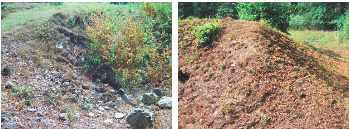
Obr. 24 a 25 Rozvalený objekt LO vz. 37 (A-220Z) s pozůstatky zemního valu – Dolní Bezděkov
