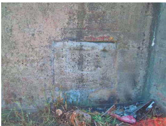
Obr. 40 Zabetonovaná střílna (A-200Z) – Slaný
