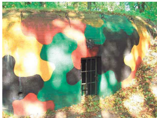
Obr. 52 Vstup do objektu B2-80Z
