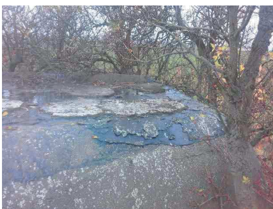
Obr. 45 Dodatečná asfaltová střešní hydroizolace
