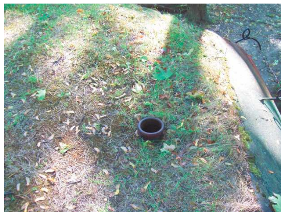
Obr. 54 Střešní otvor pro periskop
