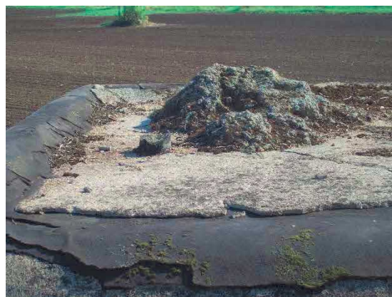
Obr. 41 Dodatečná střešní hydroizolace (A-200Z) – Slaný
