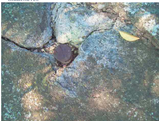
Obr. 49 Pozůstatek výztuže pro uchycení maskovací sítě
