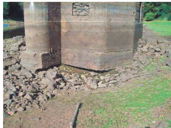
Obr. 57 Odhalená základová spára LO
