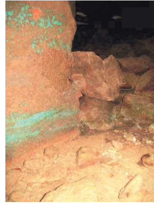
Obr. 60 Neúplně zabetonování int.
