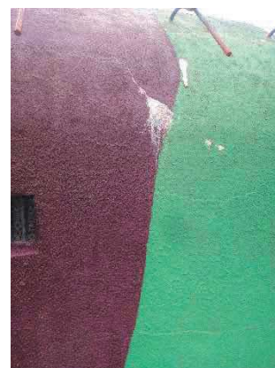
Obr. 105, 106, 107 Projevy poruch vzniklé po rekonstrukci – vápenné výkvěty, trhliny v omítce
