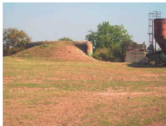
Obr. 50 Nepřístupný objekt (A-200Z) s obnoveným maskováním
