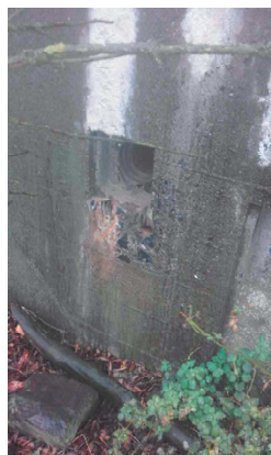
Obr. 43 a 44 Vápenné výkvěty na vnějším povrchu
