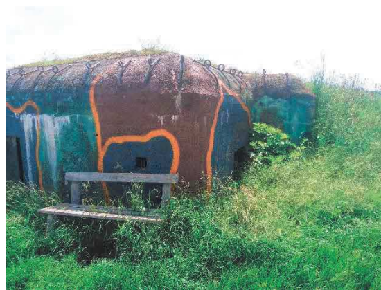
Obr. 116 a Obr. 117 Ztráta adheze omítky u objektu v původním stavu (vlevo) a po rekonstrukci (vpravo)
