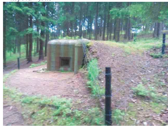
Obr. 83 Nevhodné řešení střešní hydroizolace – nepová fólie
