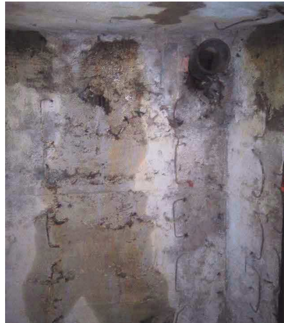
Obr. 112 a Obr. 113 Projevy působící vlhkosti na povrchu konstrukcí – zatékání
