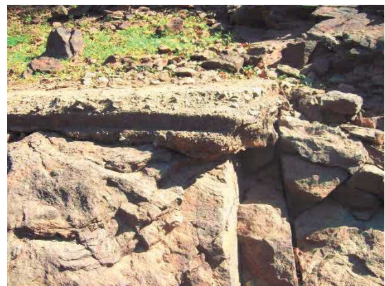
Obr. 69 a Obr. 70 Nedokončený objekt LO 139/26/A-160 – základová deska na skalnatém podloží
