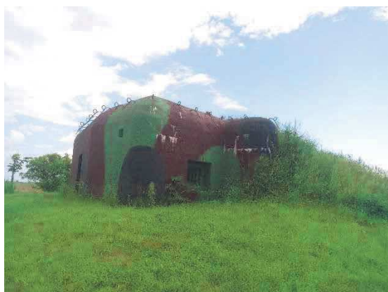
Obr. 103 Objekt LO vz. 37 (10/3111/A-160Z) - po rekonstrukci
