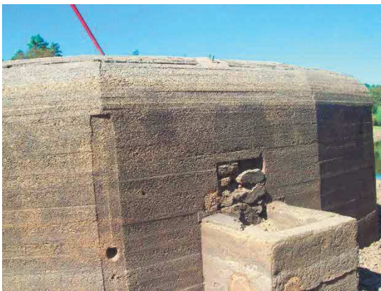
Obr. 61 a Obr 62 Deaktivovaný objekt LO vz. 37 (139/28/A-180Z) s inundační šachtou
