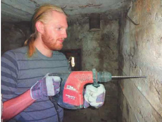
Obr. 140 Vrtání otvorů pro kartáčové sondy
