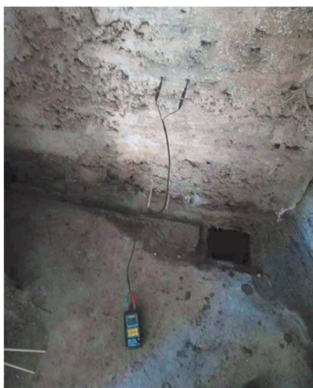
Obr. 143 Měření vlhkosti in-situ
