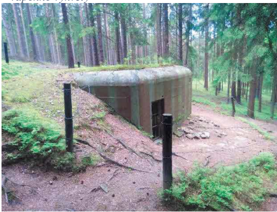
Obr. 84 a 85 Objekt LO vz.37 (9/1317/D1)
