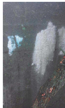
Obr. 43 a 44 Vápenné výkvěty na vnějším povrchu
