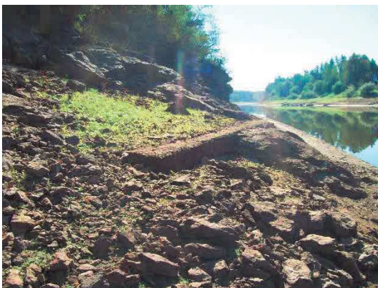
Obr. 69 a Obr. 70 Nedokončený objekt LO 139/26/A-160 – základová deska na skalnatém podloží
