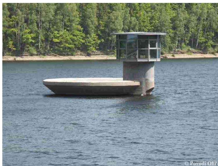
Obr. 5.2 - Šachtový přeliv se strojovnou na VD Horka (9)
