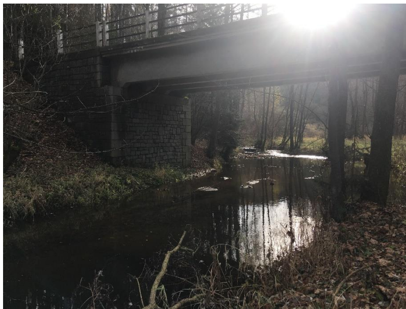
Obr. 7.5 - Silniční most na konci zátopy [foto: autor]
