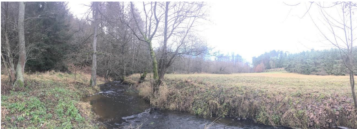
Obr. 3.3 - Profil hráze – pohled proti proudu [foto: autor]
