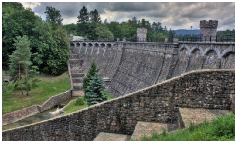
Obr. 2.1.1 Pohled na hráz od bočního přelivu [1]
