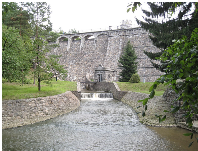
Obr. 7.2.1 Pohled na vzdušný líc hráze [2]
