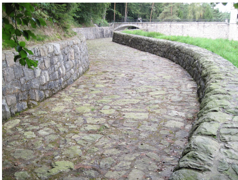
Obr. 2.5.2 Pohled na hráz ze začátku spadiště směrem k hrázi [2]
