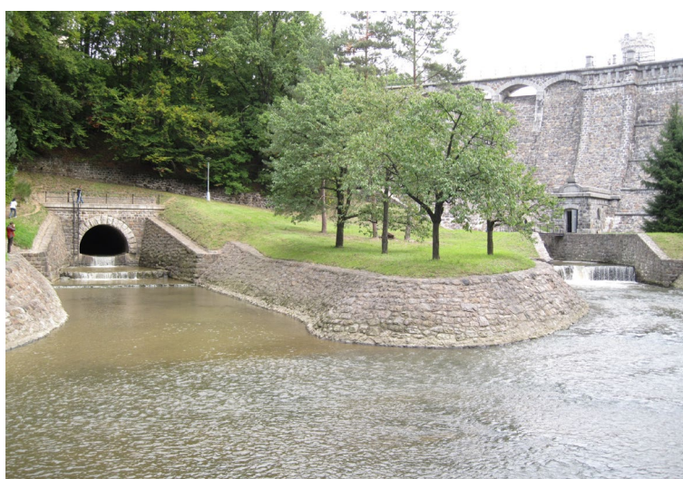
Obr. 2.5.4 Výtok z obtokové štoly [2]
