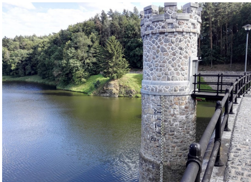
Obr. 2.5.3 Pohled na šoupátkovou věž spodní výpusti [2]
