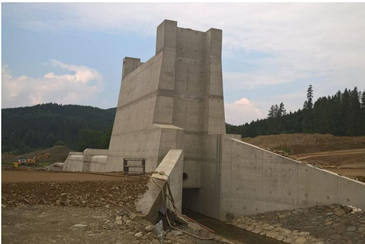
Obr. 1 Sdružený objekt budované suché nádrže Jelení [9]
