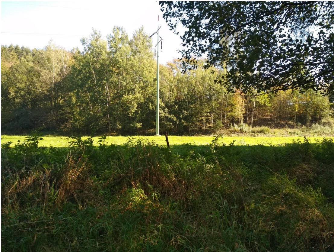
Obr. 38 Velmi vysoké napětí v blízkosti hráze
