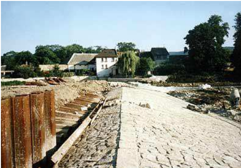
obr. 2.1 – Dobřichovický jez v době rekonstrukce [17]
