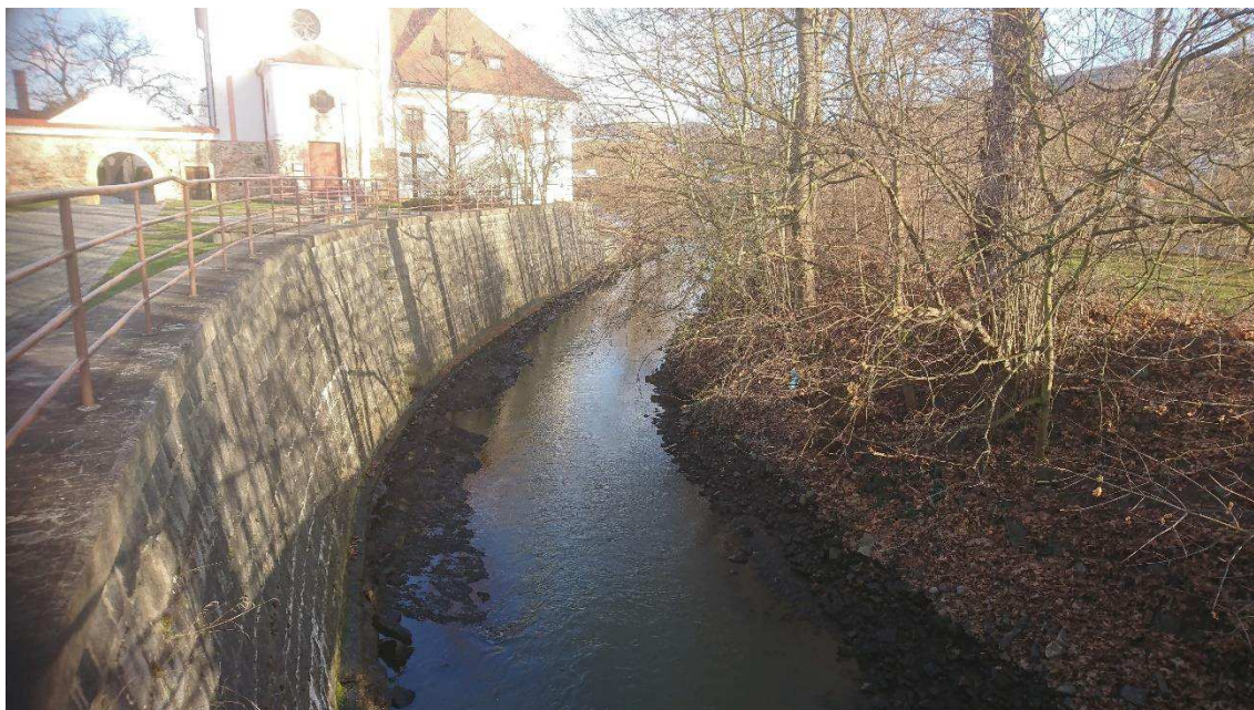
obr. 2.7 – Pohled z lávky na odpadní kanál po vodě
