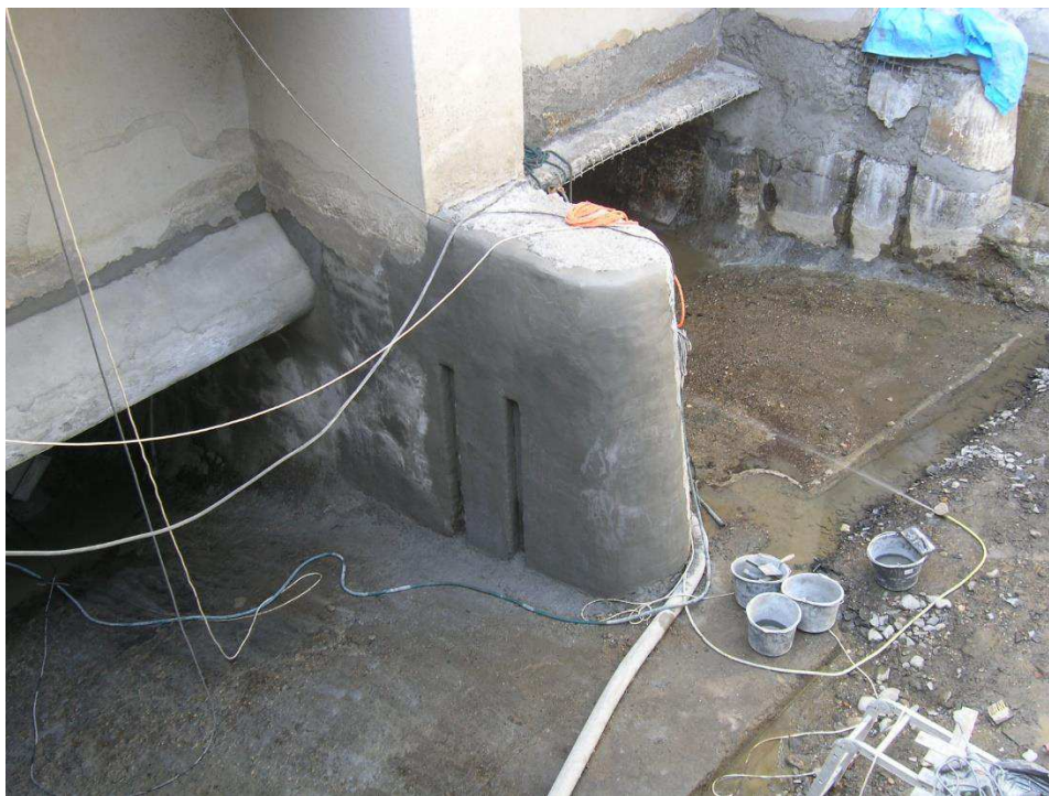
obr. 2.4 – Oprava výtoku pod elektrárnou v roce 2011
