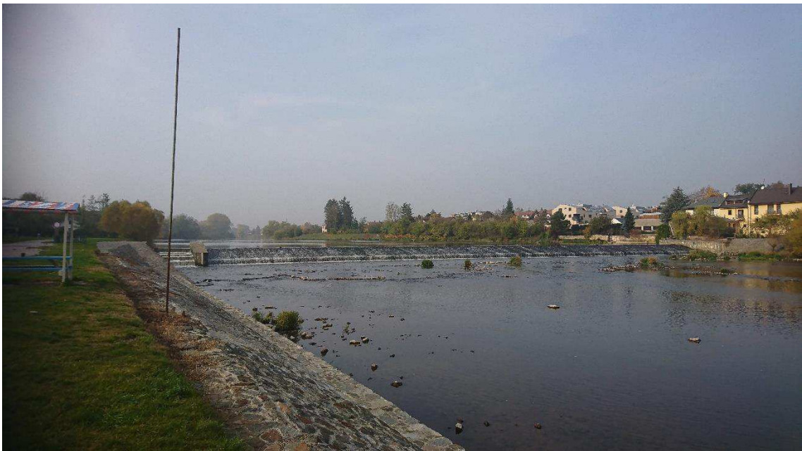
obr. 2.2 – Pohled proti vodě na jez Dobřichovice
