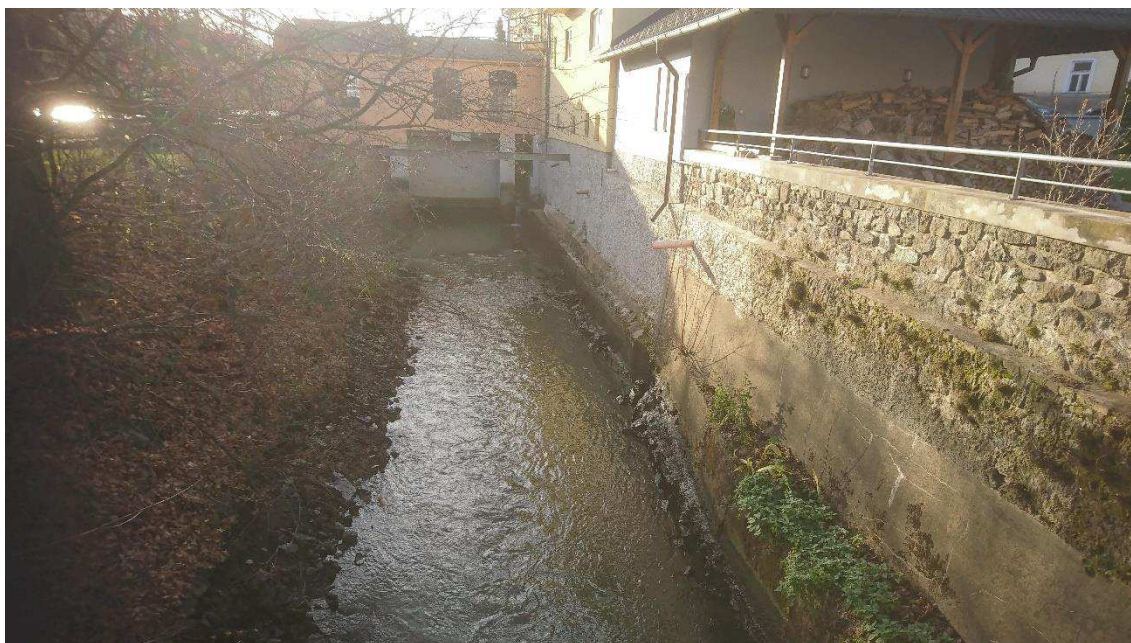
obr. 2.6 – Pohled z lávky na odpadní kanál proti vodě
