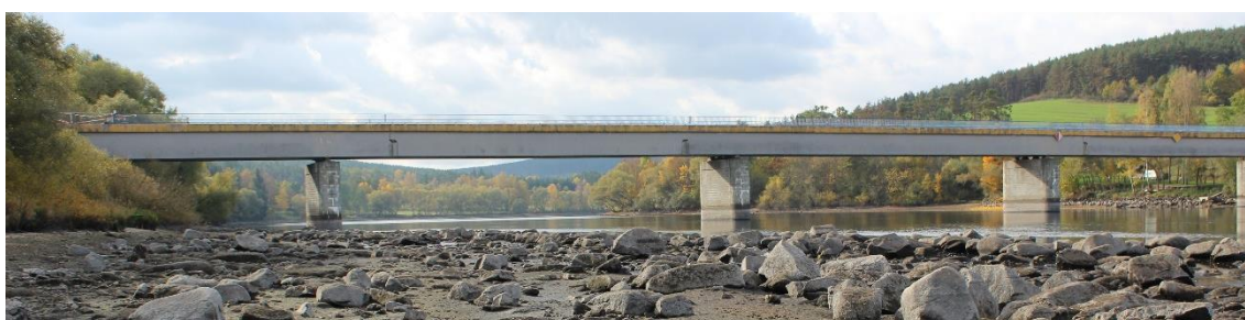
Obrázek 1: Pohled na stávající most. [8]
