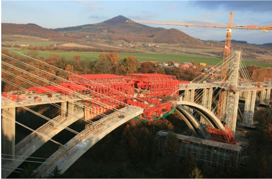
Obrázek 55: Realizace mostu přes Oparenské údolí. [12]
