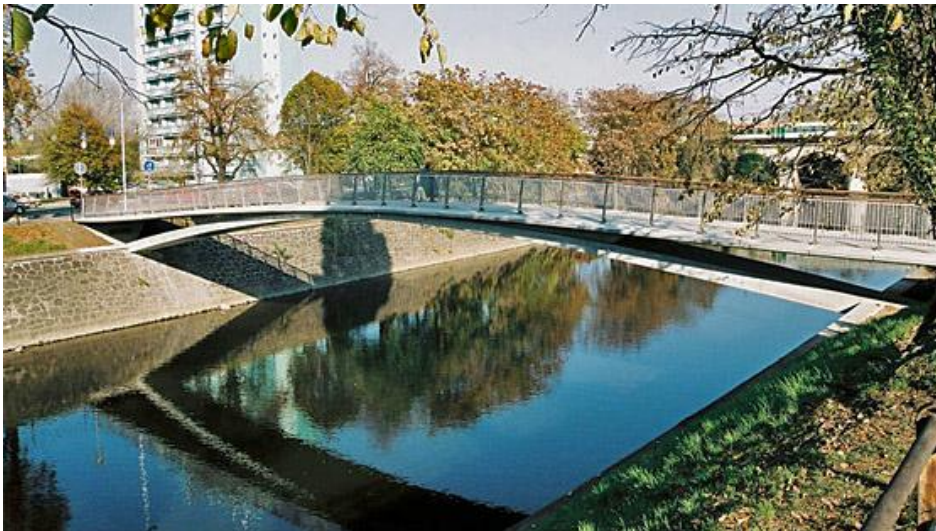
Obr. 9: Lávka přes řeku Svratku v Brně [11]
