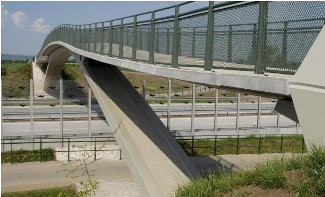
Obr. 7: Lávka přes R35 u Olomouce [10]
