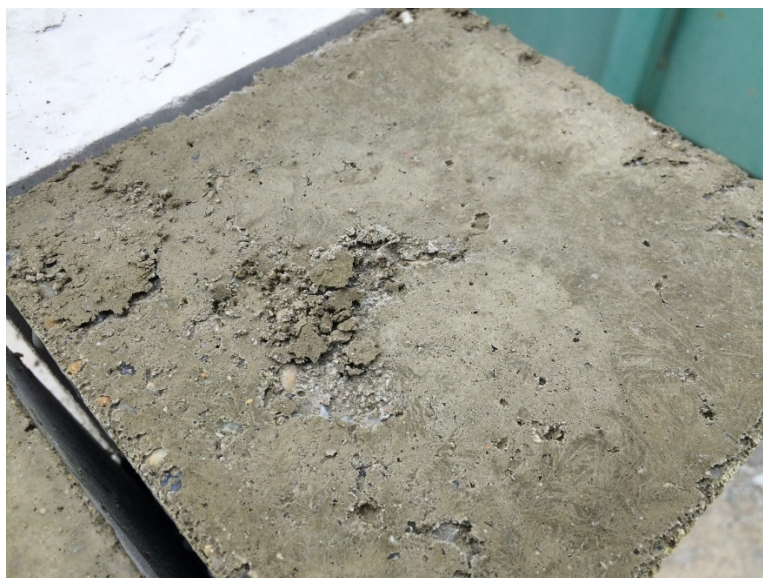
Obrázek 34 Ukázka betonu po provedení 28 cyklů
