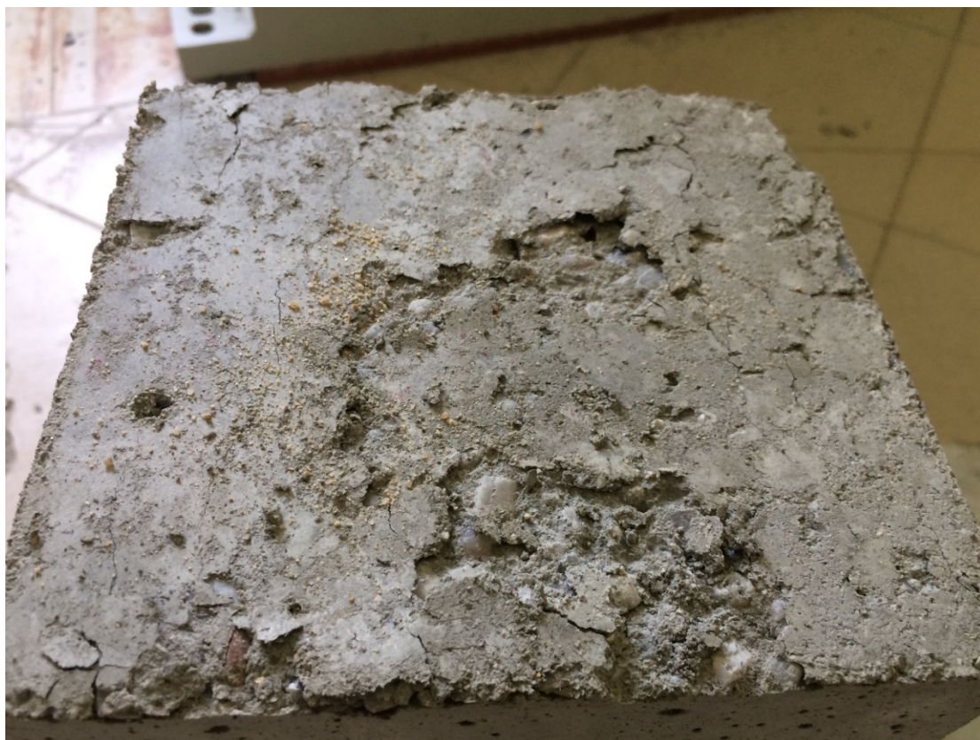
Obrázek 37 Poškození betonu po pěti dnech vystaveného v mrazu - 20 °C
