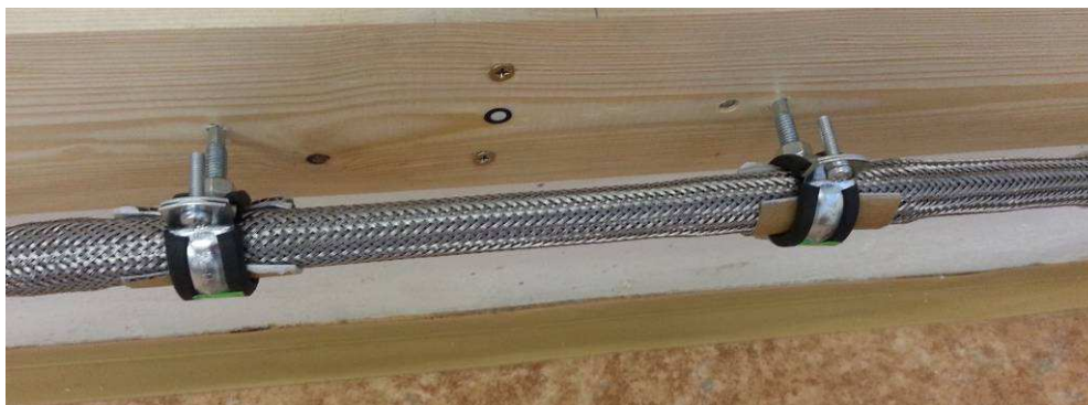
Obr. 4.7 Stabilní uchycení segmentu pomocí instalátorských objímek
