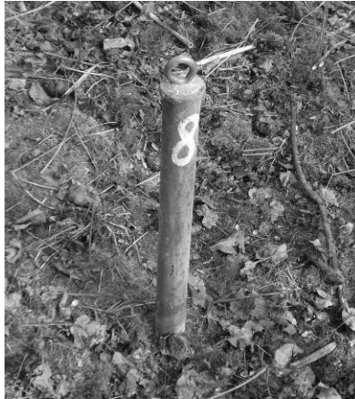
Obr. 5.5 Stabilizace bodů extenzometrického profilu
