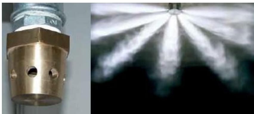
Obr. 29: Plynná hubica vľavo a výstrek hasiva NOVEC po spustení plynového SHZ vpravo. [4]
