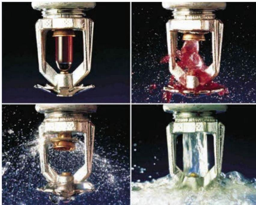
Obr. 8: Otvorenie sprinklerovej hlavice pri dosiahnutí otváraciej teploty. [civilná ochrana 1:2018]
