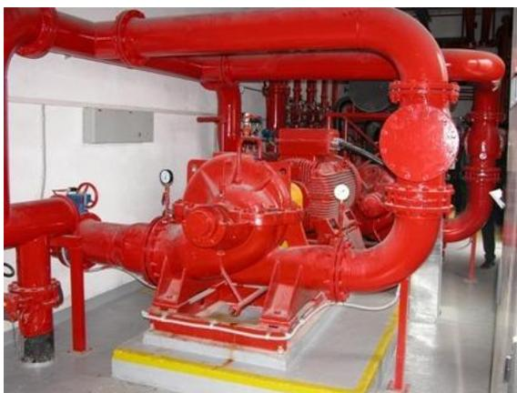
Obr. 13: Čerpadlo s elektromotorom. [5]
