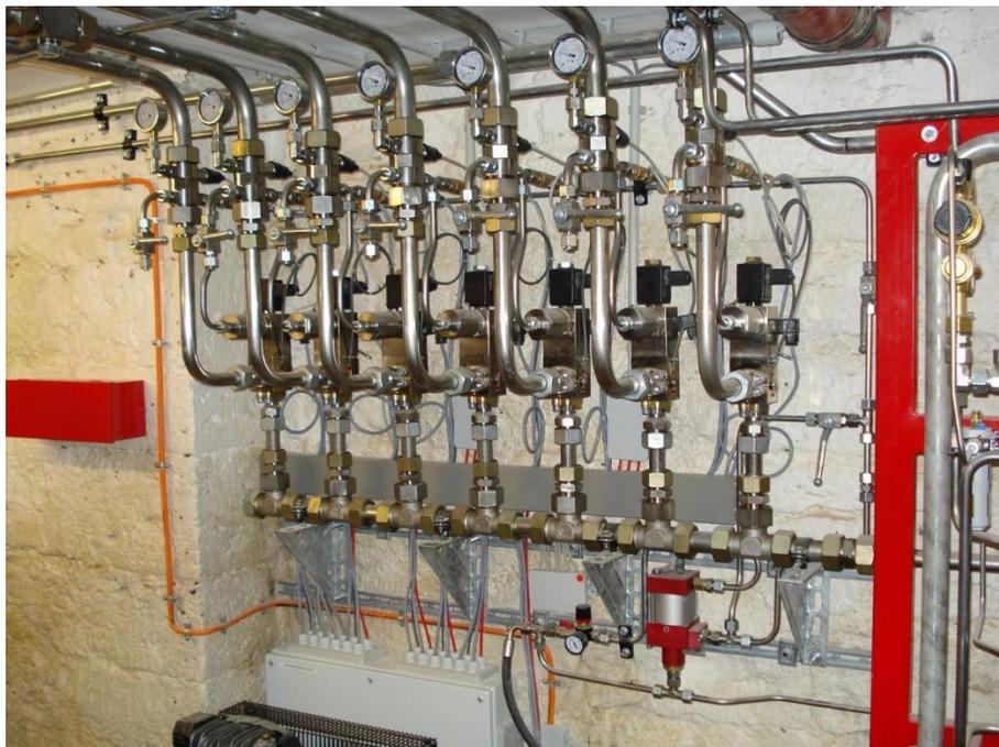
Obr. 23: Sekčné ventily vysokotlakového hmlového SHZ. [8]
