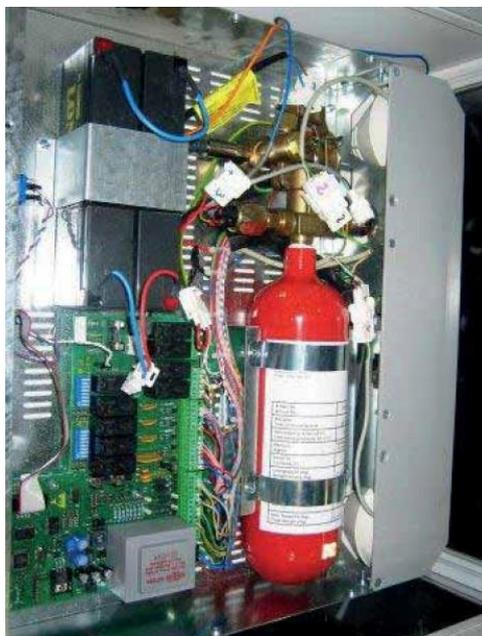
*Obr. 27: Plynové SHZ pre lokálnu ochranu. [4]*
