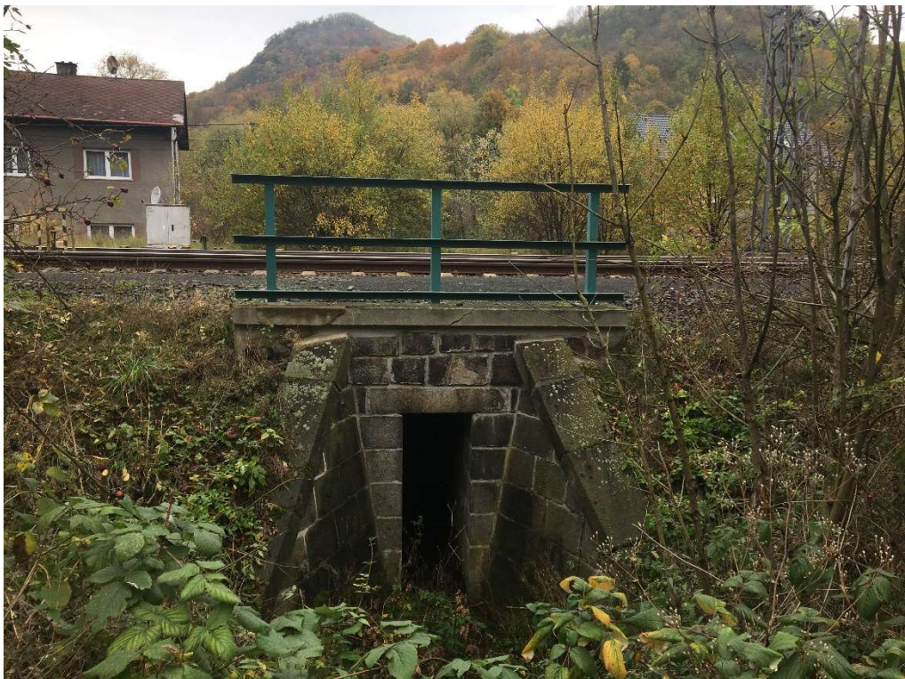
Foto č. 24 – Propustek po výjezdu ze stanice Stráž nad Ohří (staničení 158,170 km)
