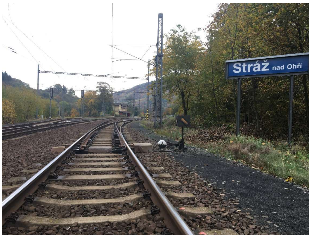
Foto č. 19 – Stanice Stráž nad Ohří (pohled proti staničení)
