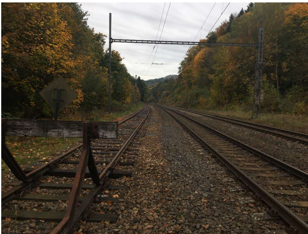
Foto č. 15 – Stanice Perštejn (pohled proti staničení)
