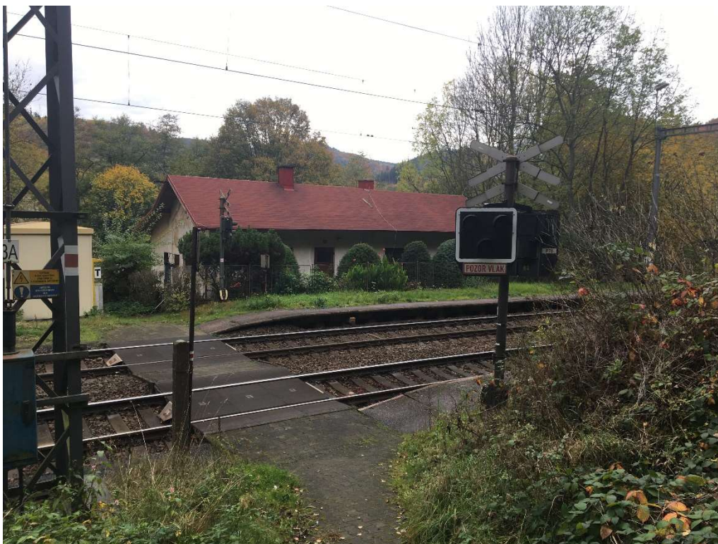
Foto č. 4 – Přejíždění pro pěší P76 v zastávce Boč (staničení km 154,831)
