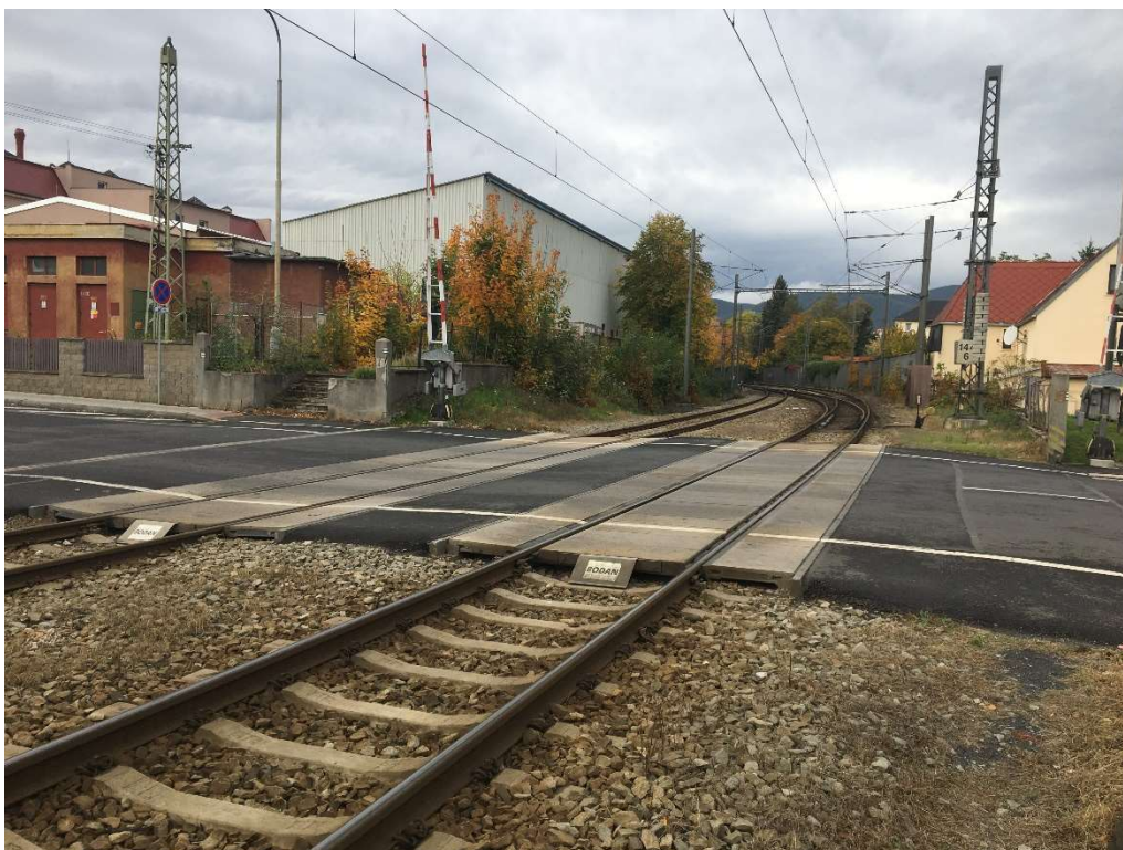
Foto č. 1 – Přejezd P74 v Klášterci nad Ohří ve staničení km 144,617
