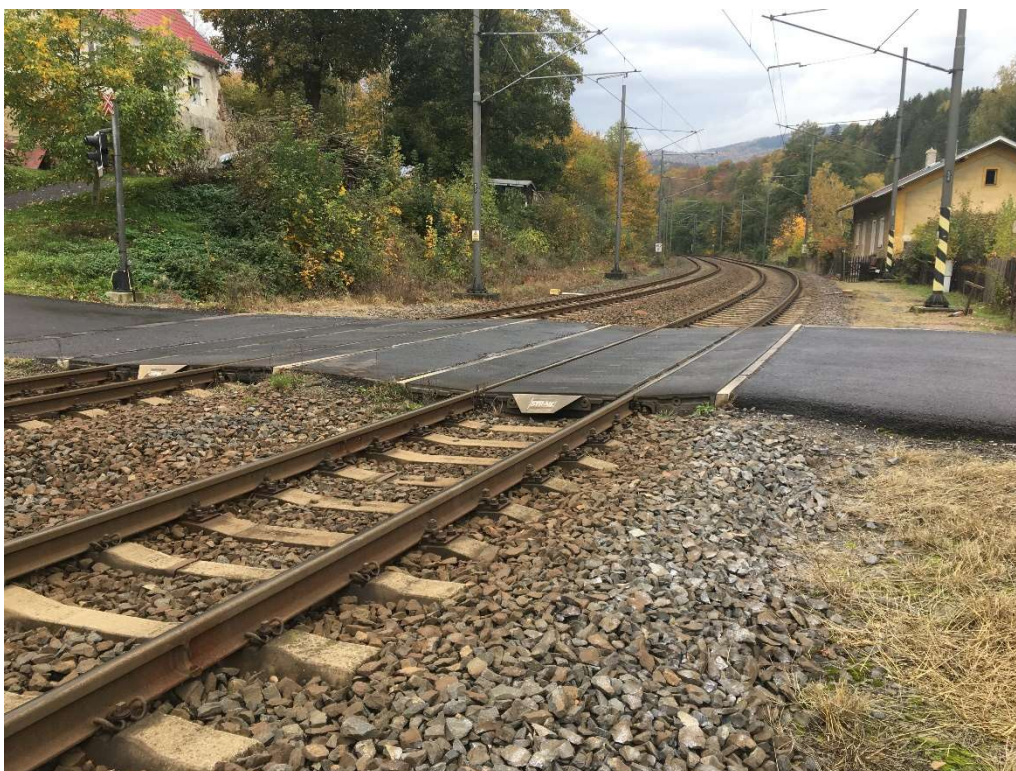
Foto č. 2 – Přejezd P75 za stanicí Perštejn ve směru staničení km 151,943
