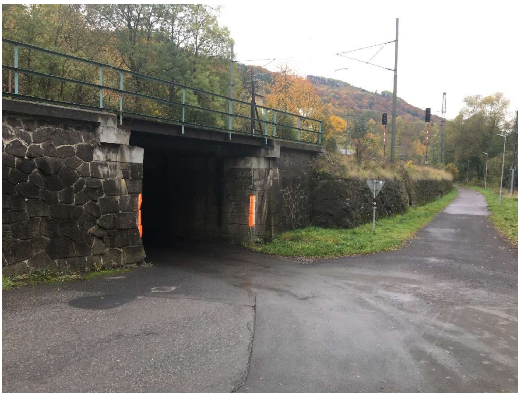
Foto č. 25 – Most za stanicí Stráž nad Ohří (staničení km 158,295)
