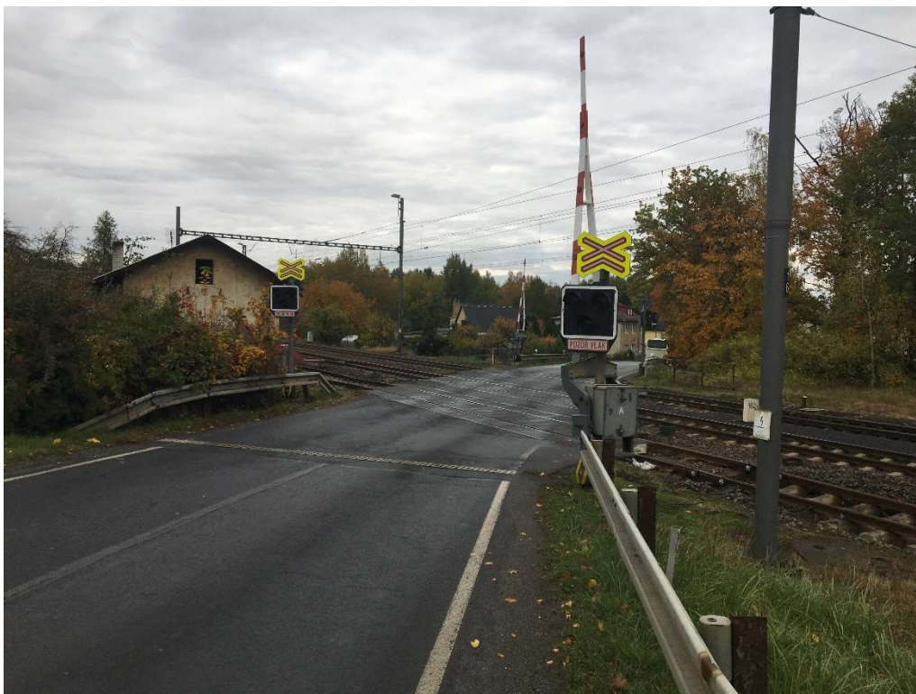
Foto č. 9 – Přejezd P82 ve staničení 182,304 km
