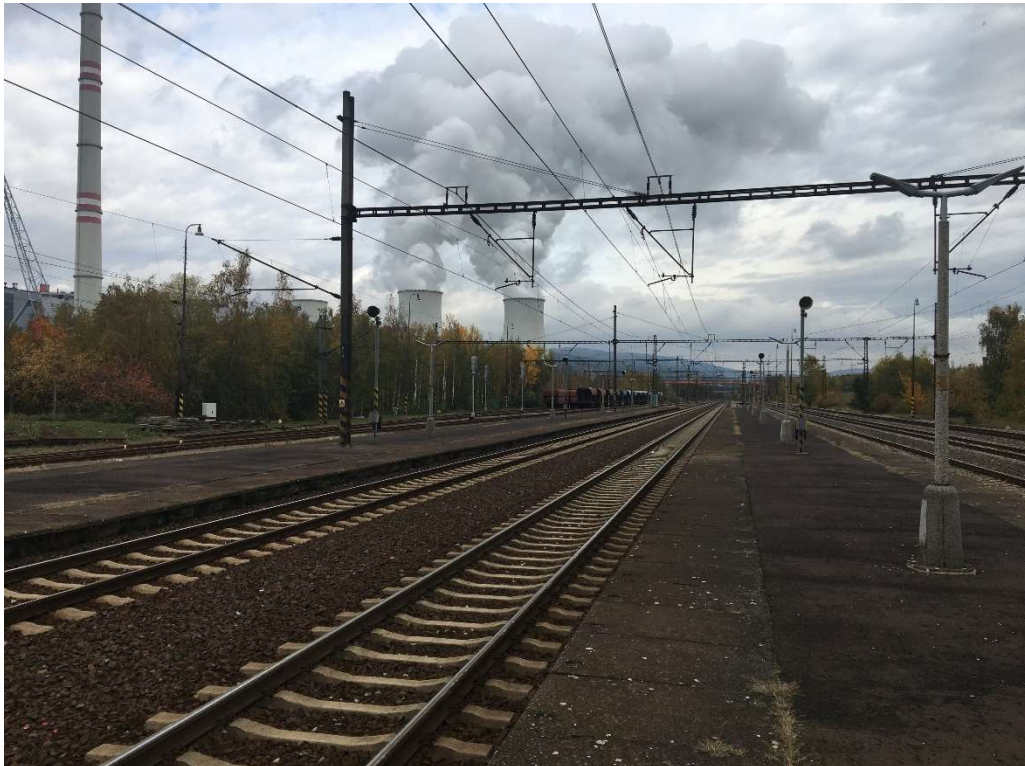
Foto č. 11 – Hlavní koleje č. 1 a 2 ve stanici Kadaň – Prunéřov (pohled proti staničení)
