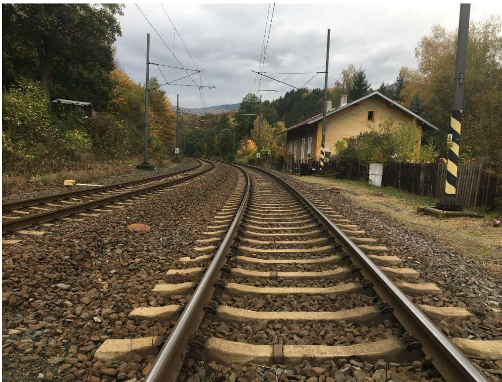
Foto č. 3 – Pražcové kotvy v levotočivém oblouku (R = 300 m) v km 152,000
