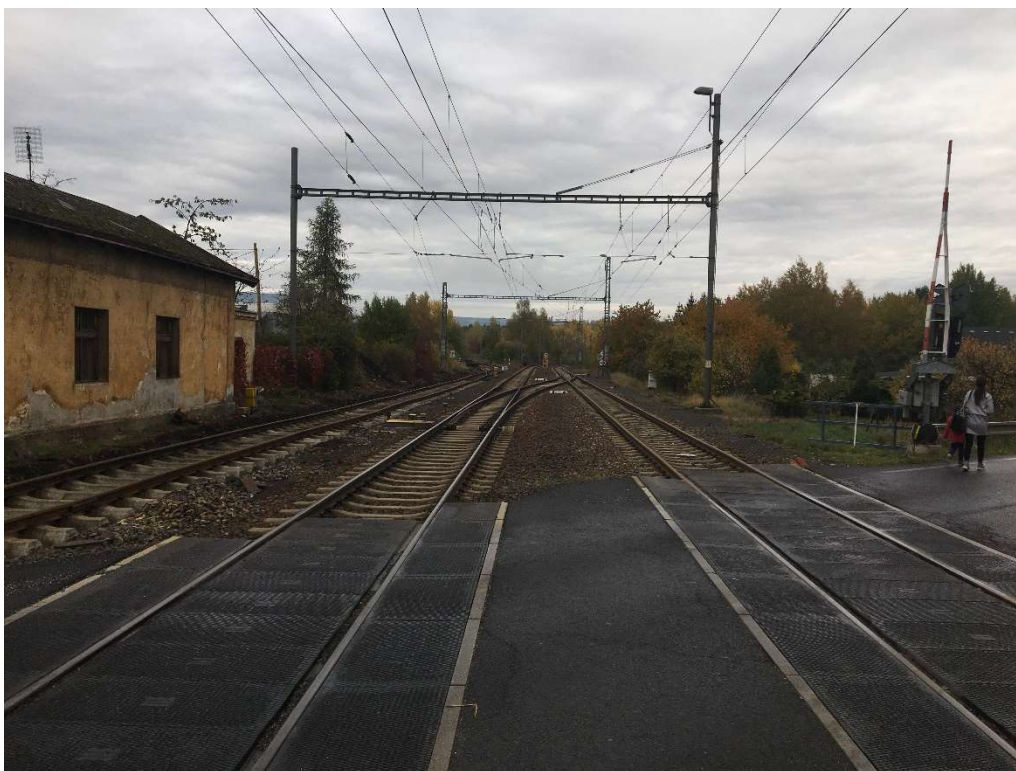
Foto č. 10 – Pohled proti směru staničení trati z přejezdu P82 (staničení 182,304 km)
