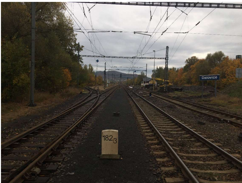
Foto č. 22 – Stanice Dalovice – zhlaví před stanicí
