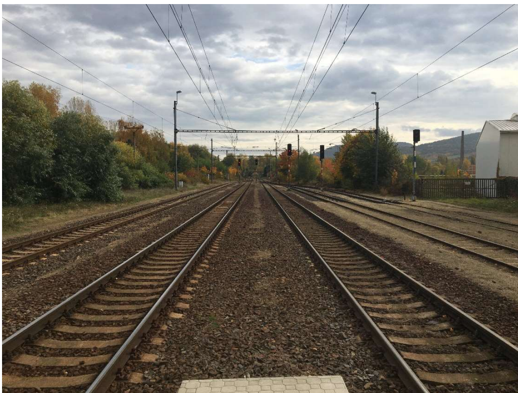
Foto č. 13 - Stanice Klášterec nad Ohří (pohled proti staničení)
