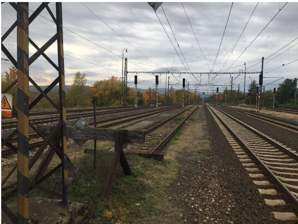
Foto č. 12 – Stanice Kadaň – Prunéřov (pohled ve směru staničení)
