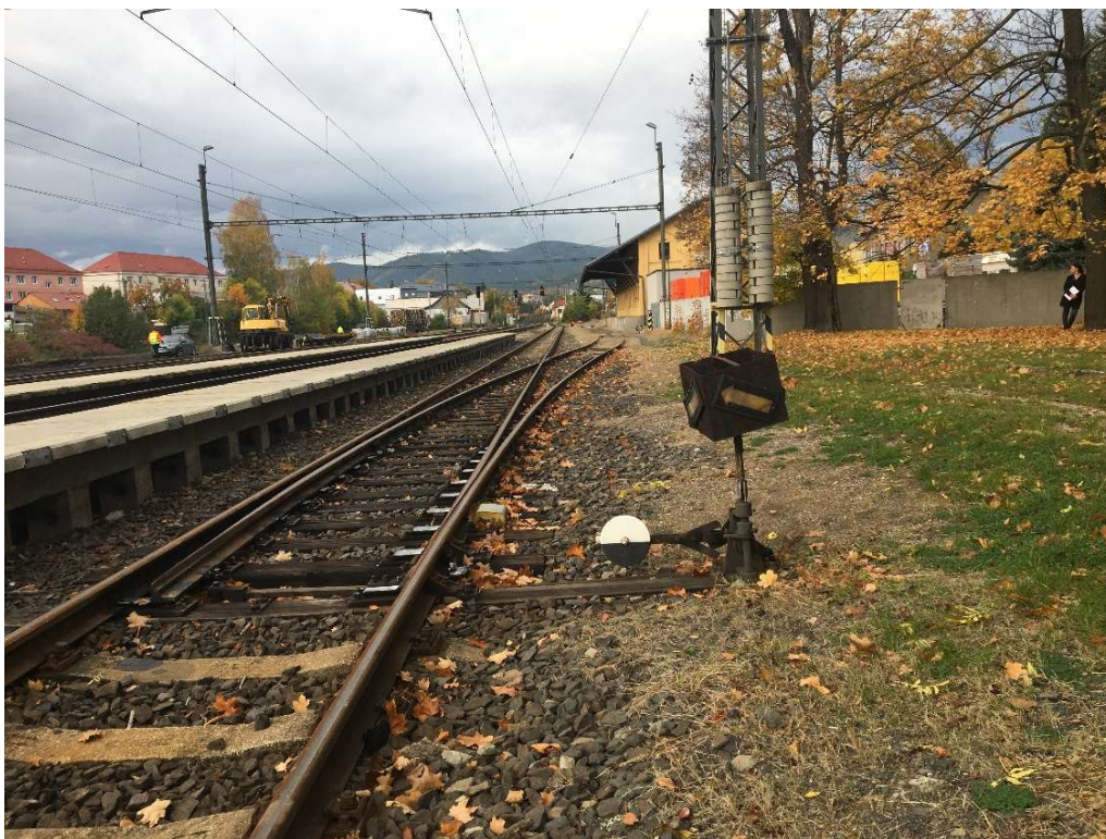
Foto č. 14 – Stanice Klášterec nad Ohří (pohled ve směru staničení)
