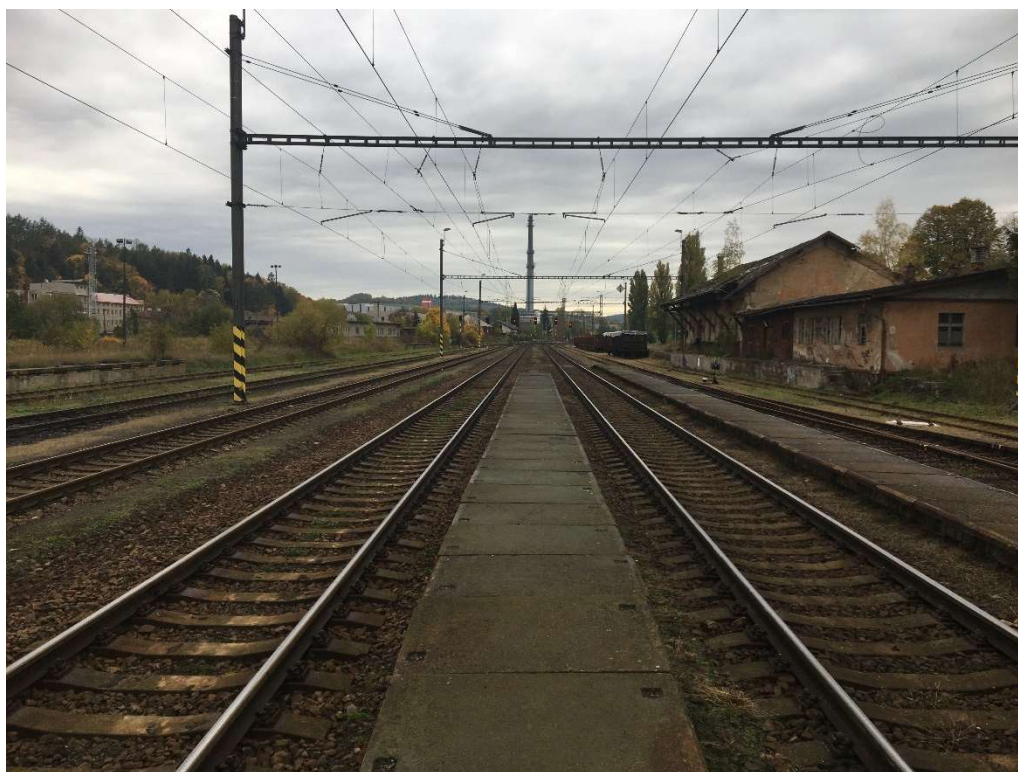
Foto č. 20 – Stanice Ostrov nad Ohří – pohled ve směru staničení
