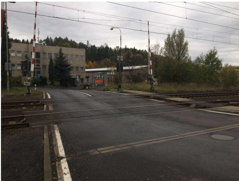
Foto č. 7 – Přejezd P78 ve staničení 170,153 km
