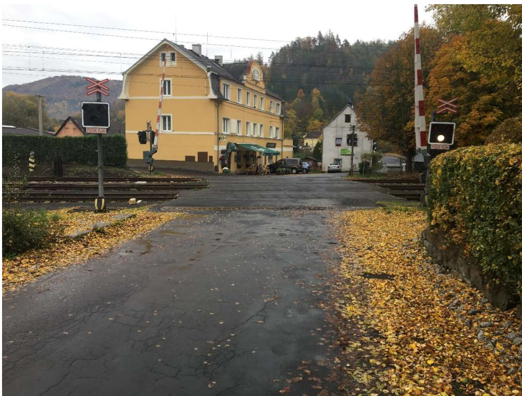
Foto č. 6 – Přejezd P77 ve staničení 163,941 km
