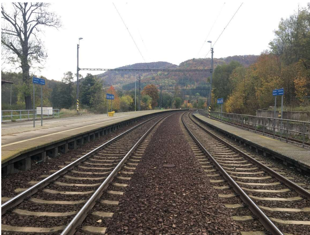
Foto č. 18 – Stanice Stráž nad Ohří (pohled proti staničení)
