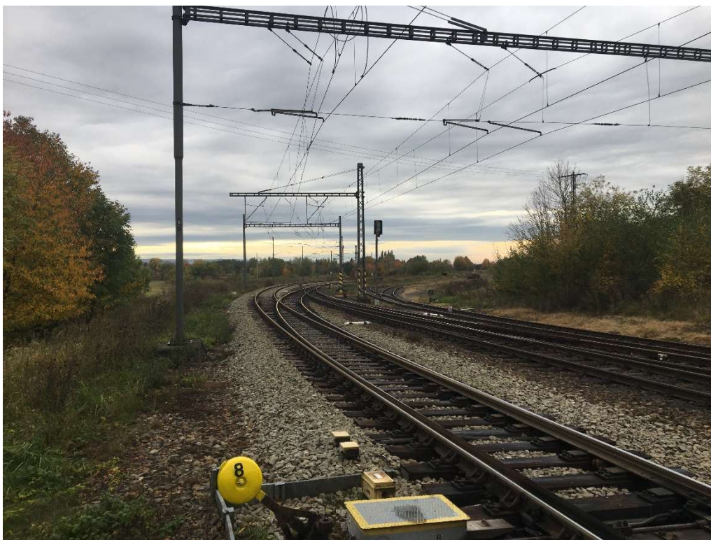
Foto č. 21 – Stanice Hájek (pohled ve směru staničení)
