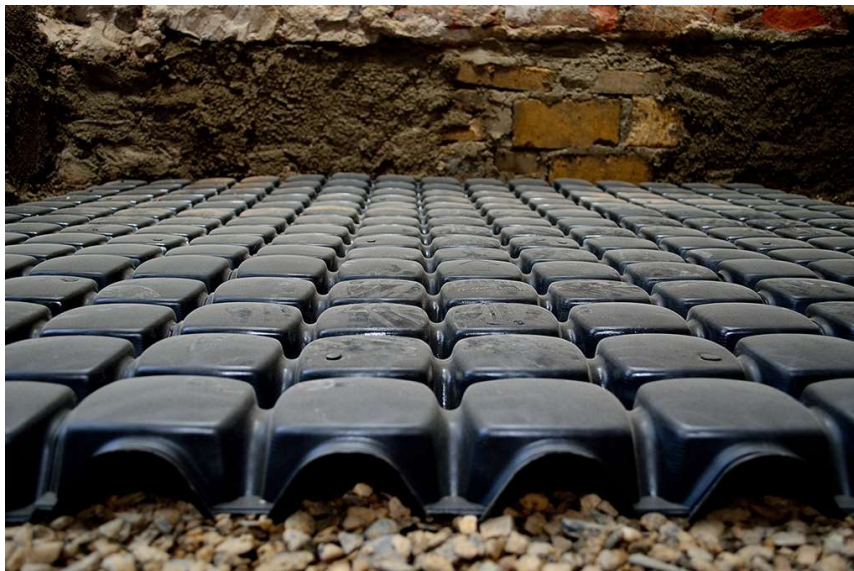
Obrázek 18: Ukázka ztraceného bednění iglů [19]
