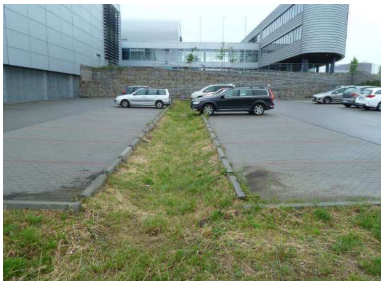
Obrázek 20: Vsakovací průleh v kombinaci c řešením odvodnění zpevněné plochy mezer mezi obrubníky (kampus Masarykovy univerzity v Brně) (35)
