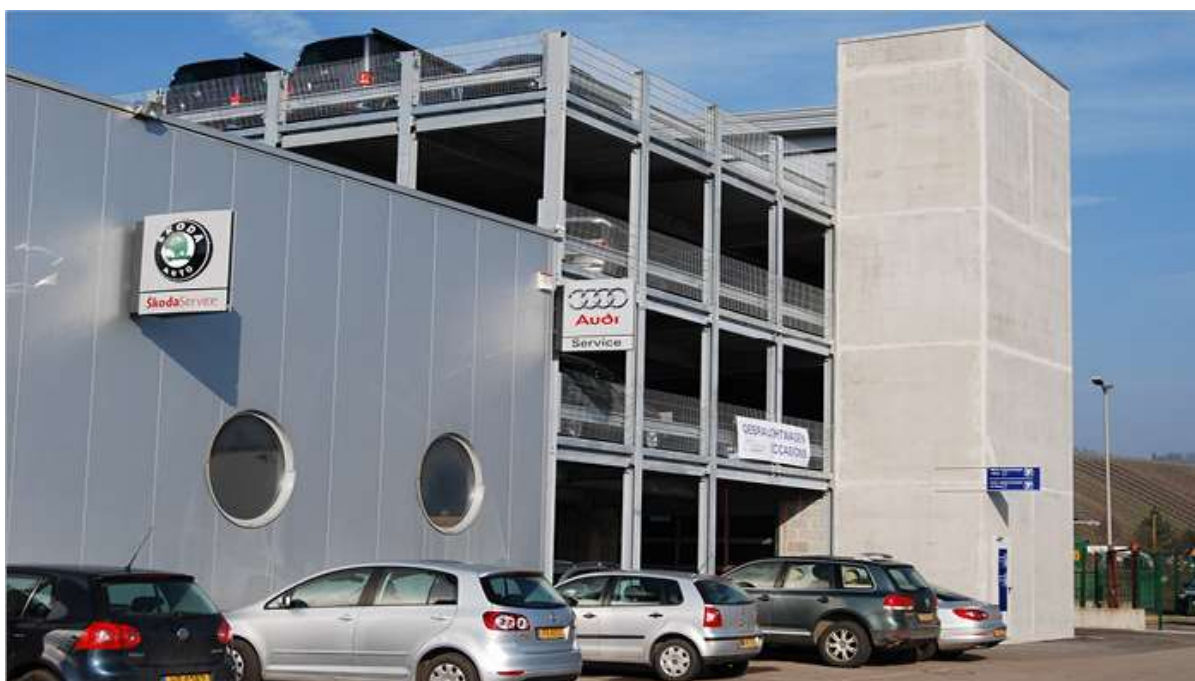
Tabulka 23: Ocelové nadzemní parkoviště (Lucembursko) (32)
