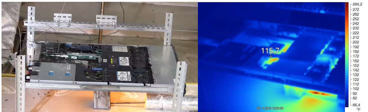
Obrázek 26 - 10:00 Zvýšení výkonu hořáku na 3 Kw
