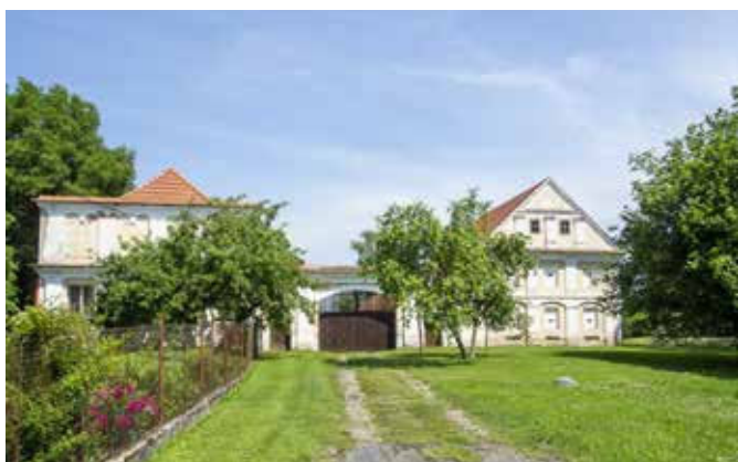
015 Předprostor domu [Česká republika, Bošile]
