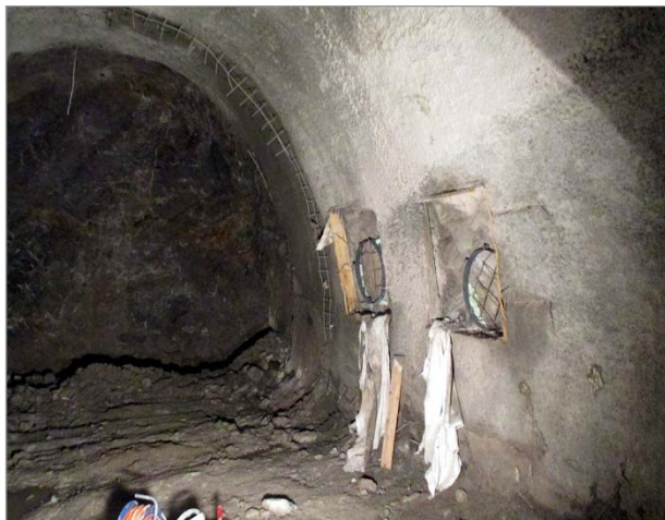
Obr. 12 a Obr. 13: Čtvercová okna v ostění štoly pro rozpěrné zatěžovací zkoušky před vyrovnáním stříkaným betonem
