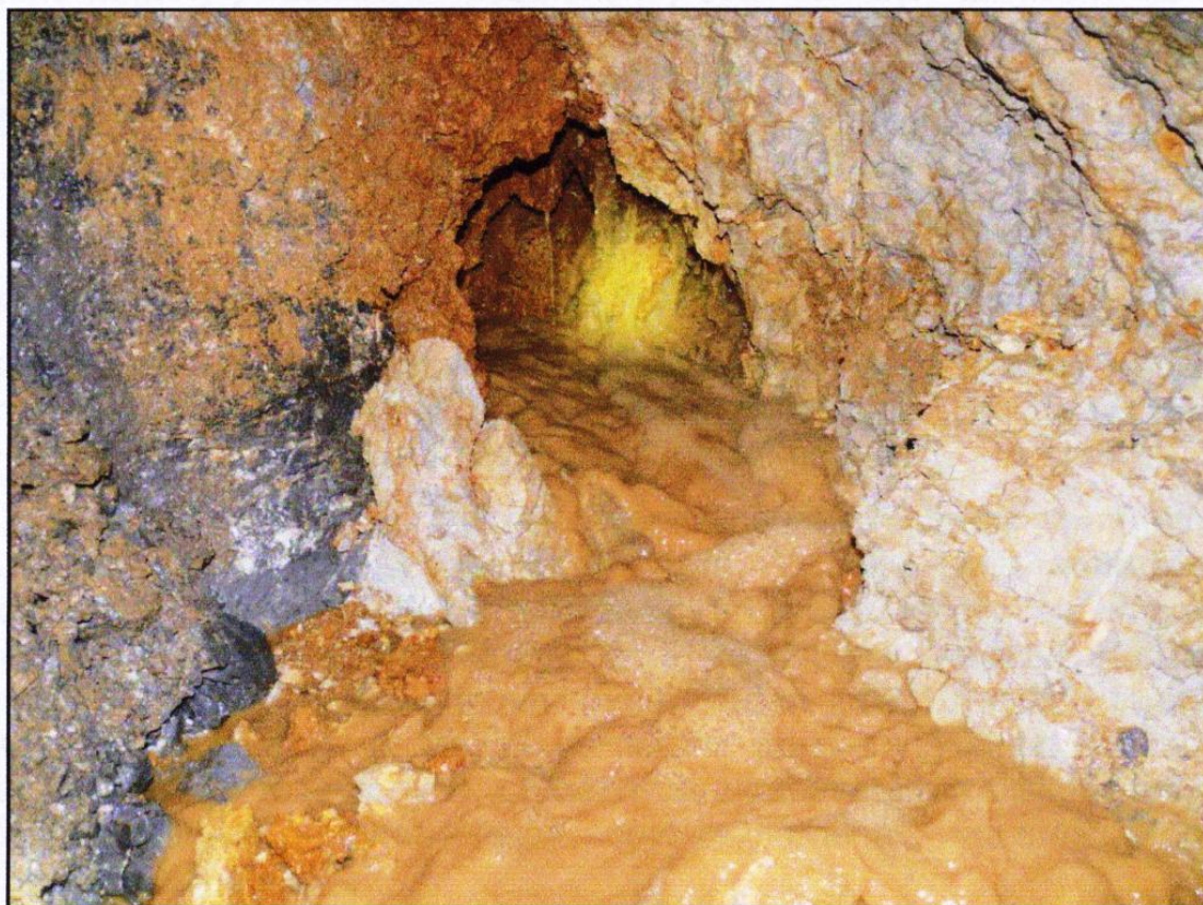
Obrázek 10: Zkrasovatělá porucha v km 0,517. [13]
