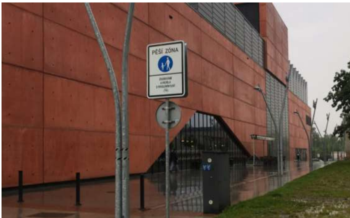
Obrázek 4 Lichoběžníkový otvor v obvodové stěně (foto autorka práce)
