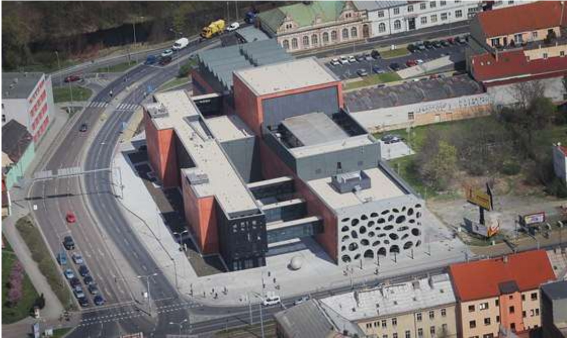
Obrázek 7 Pohled na střechu divadla [5]
