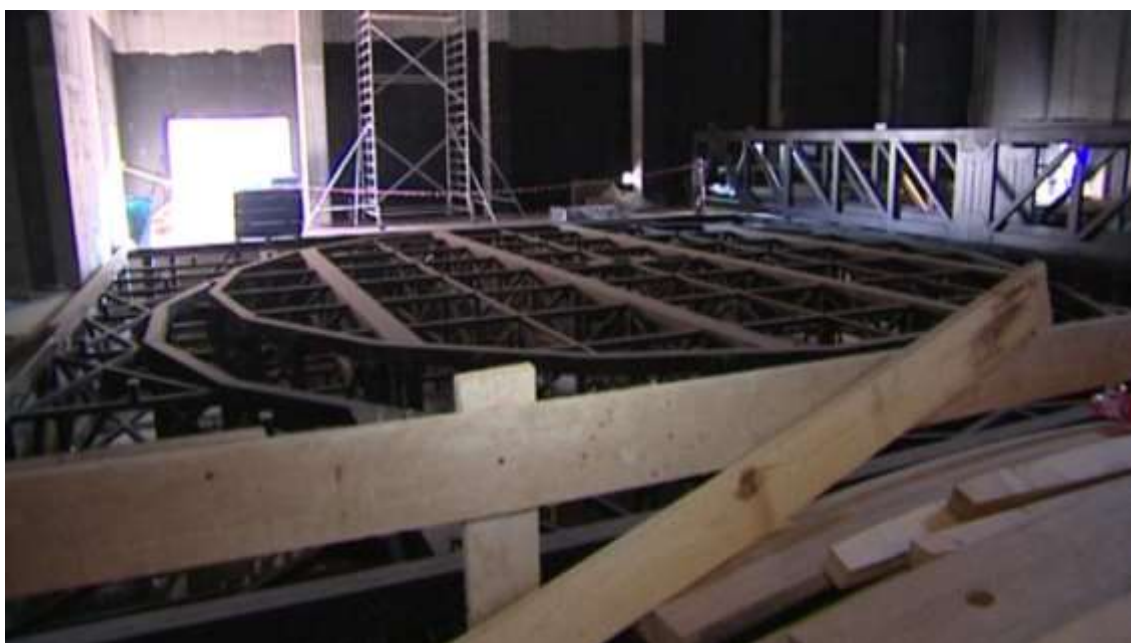
Obrázek 11 Jevištní technika - divadelní točna [8]
