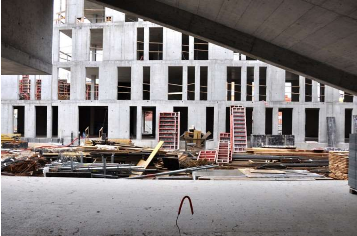
Obrázek 3 Stěna provozní budovy [3]
