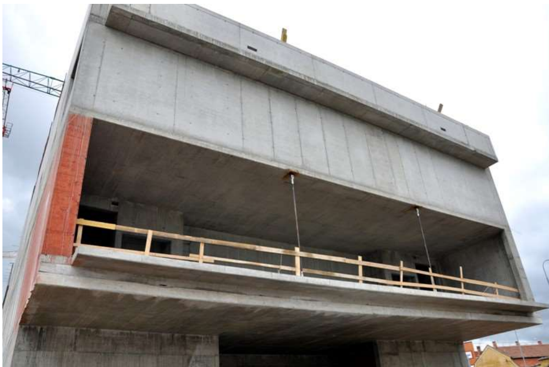
Obrázek 5 Stěnový nosník se dvěma táhly [3]
