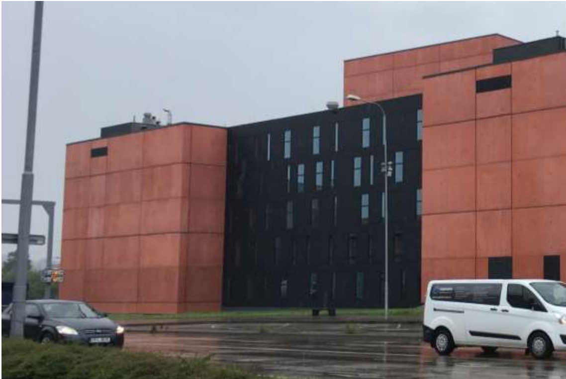
Obrázek 33 Stěna provozní budovy - západní fasáda
