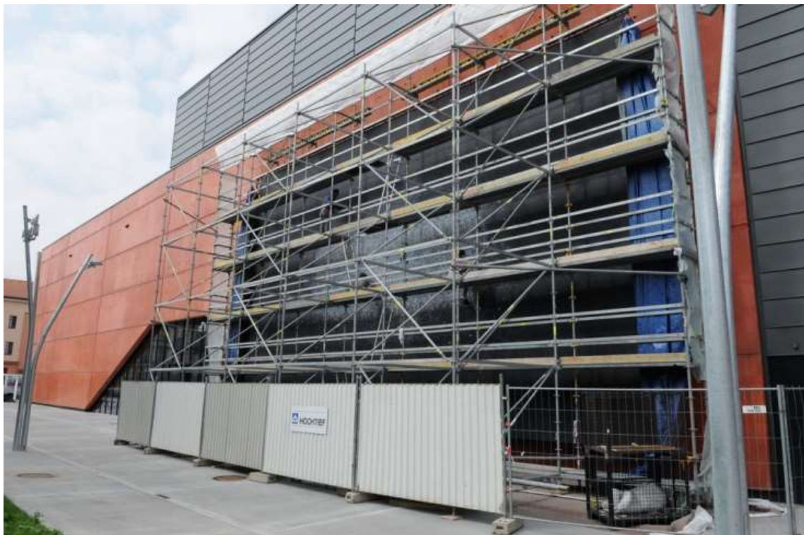
Obrázek 22 Pohled na východní fasádu objektu, v levé části stěna s lichoběžníkovým otvorem [2]
