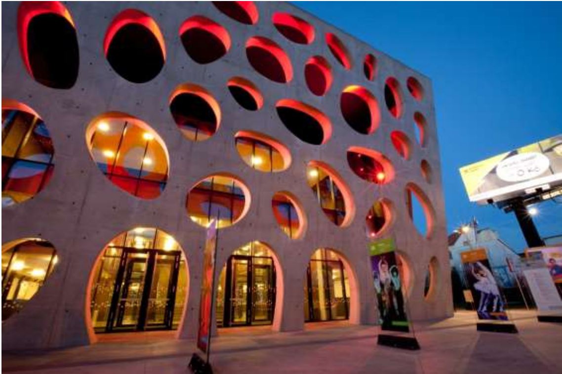
Obrázek 9 Perforovaná vstupní fasáda [6]
