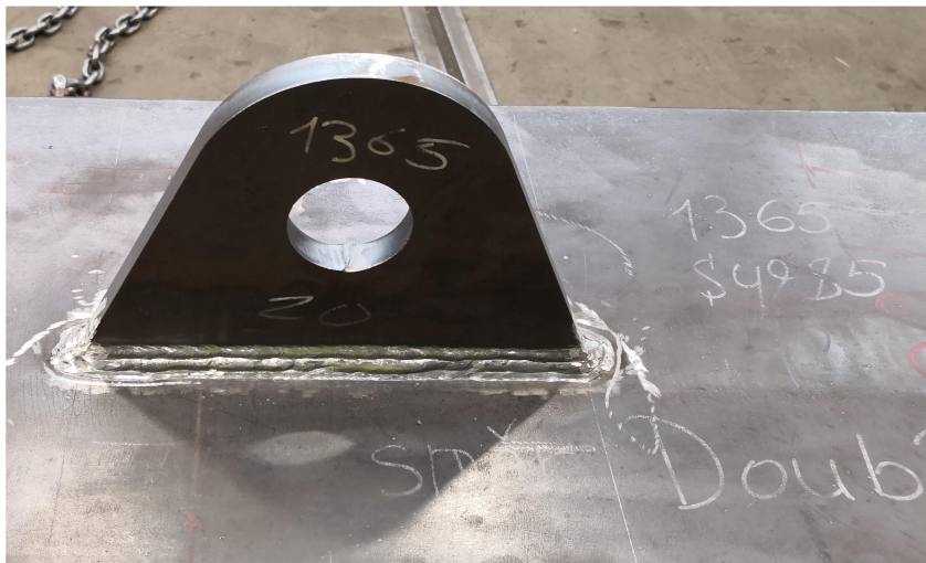
Obrázek 31: Přivaření 2 ks jeřábových ok
