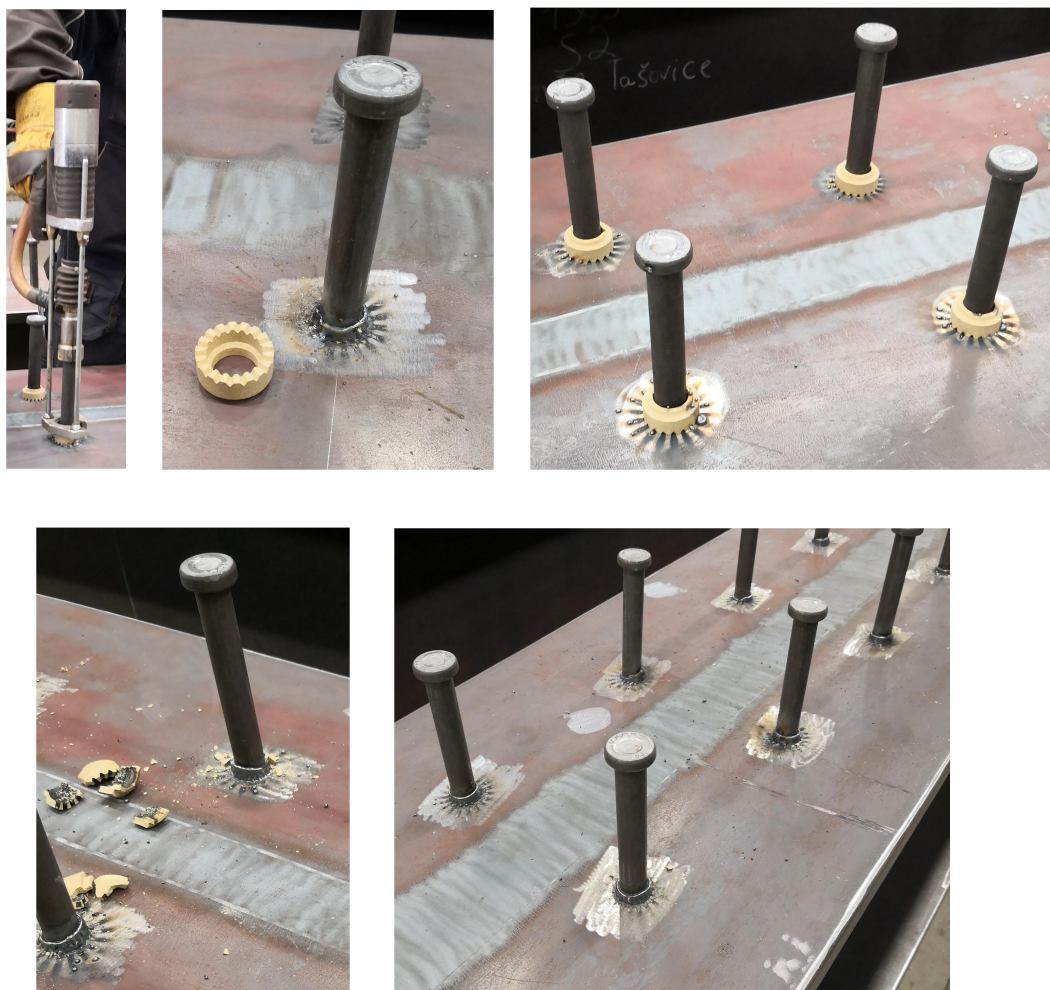
Obrázek 32: Přivaření trnu + odstranění keramických kroužku + zčištění svaru
