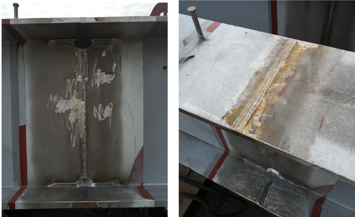
Obrázek 36: Svaření jednotlivých dílů nosníku
