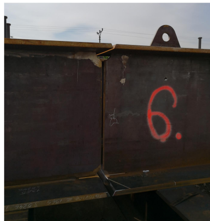
Obrázek 34: Uložení dílců na venkovní přípravek – spasování s respektováním mezery pro finální svar
