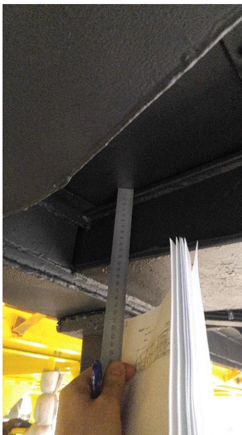
Obrázek 22. Měření rozměru nosníku rámu T3 během exkurze.
