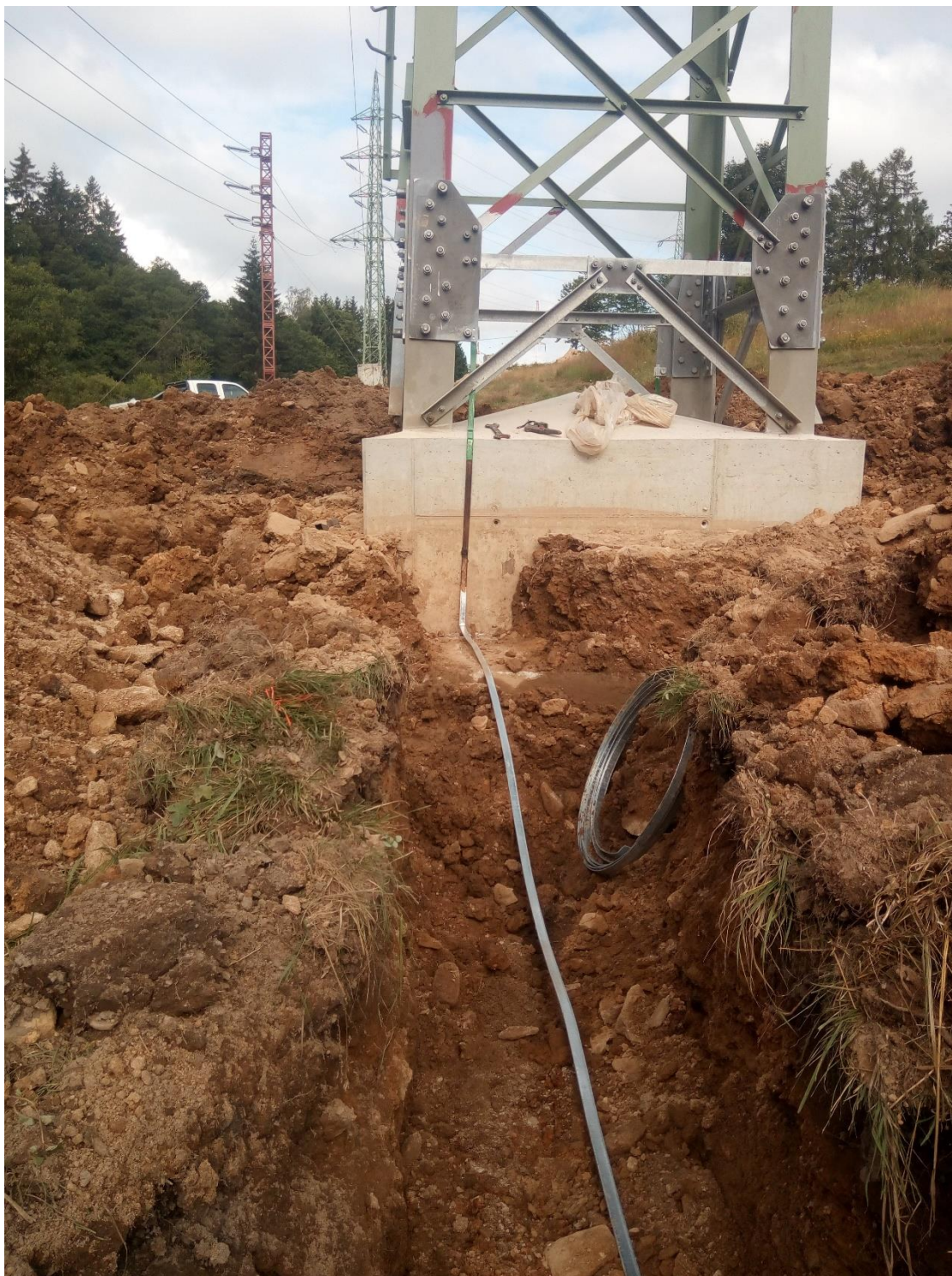
Snímek 10: Připojení zemnicího pásu ke stožárové konstrukci
