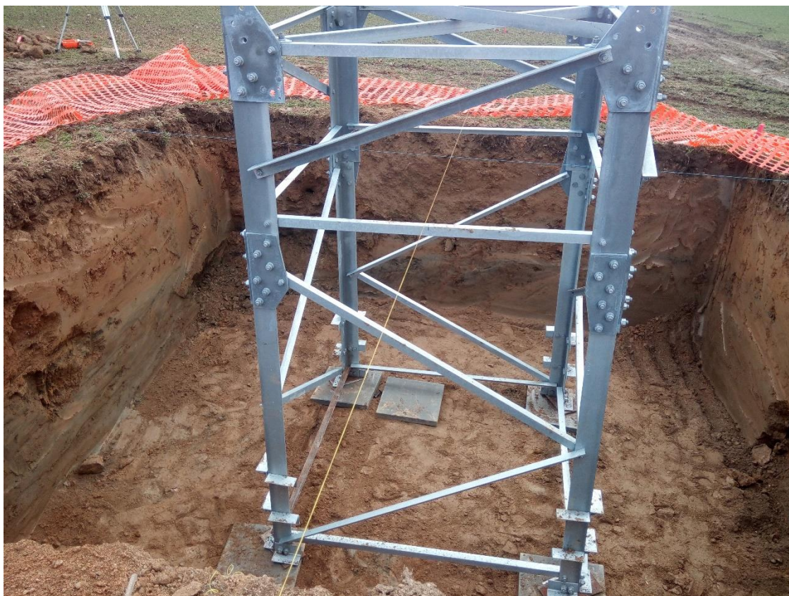
Snímek 1: Příhradový stožár vsazený do výkopu
