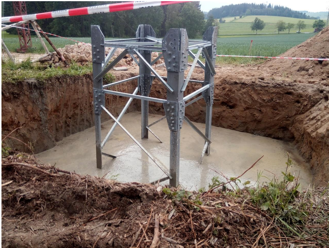
Snímek 2: Příhradový stožár po základní betonáži
