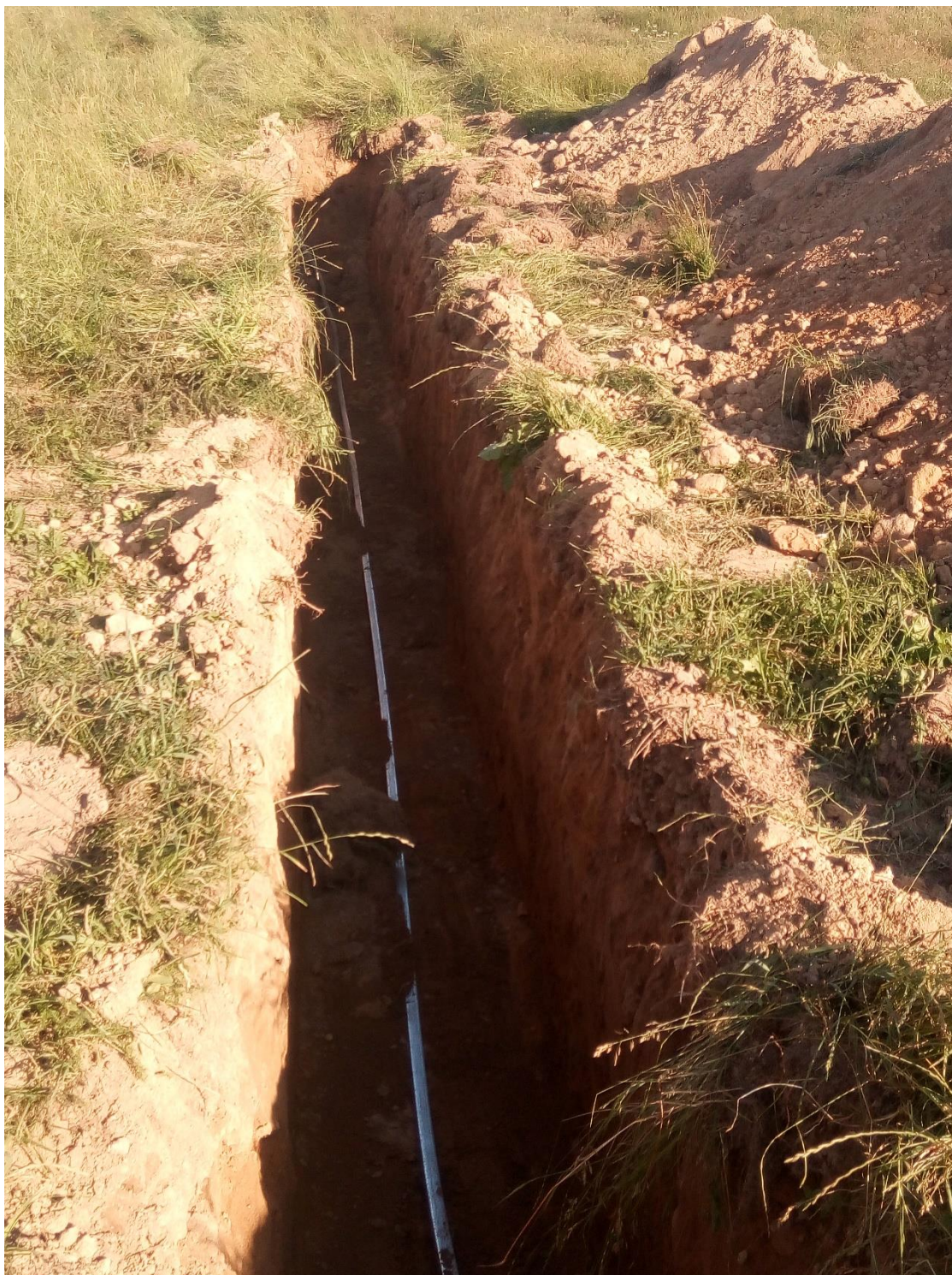
Snímek 7: Tažení paprskového uzemnění
