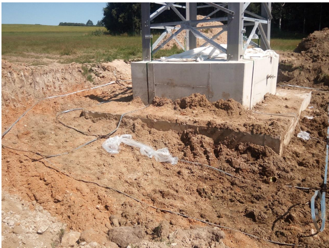
Snímek 5: Instalace uzemnění s ekvipotenciálními kruhy
