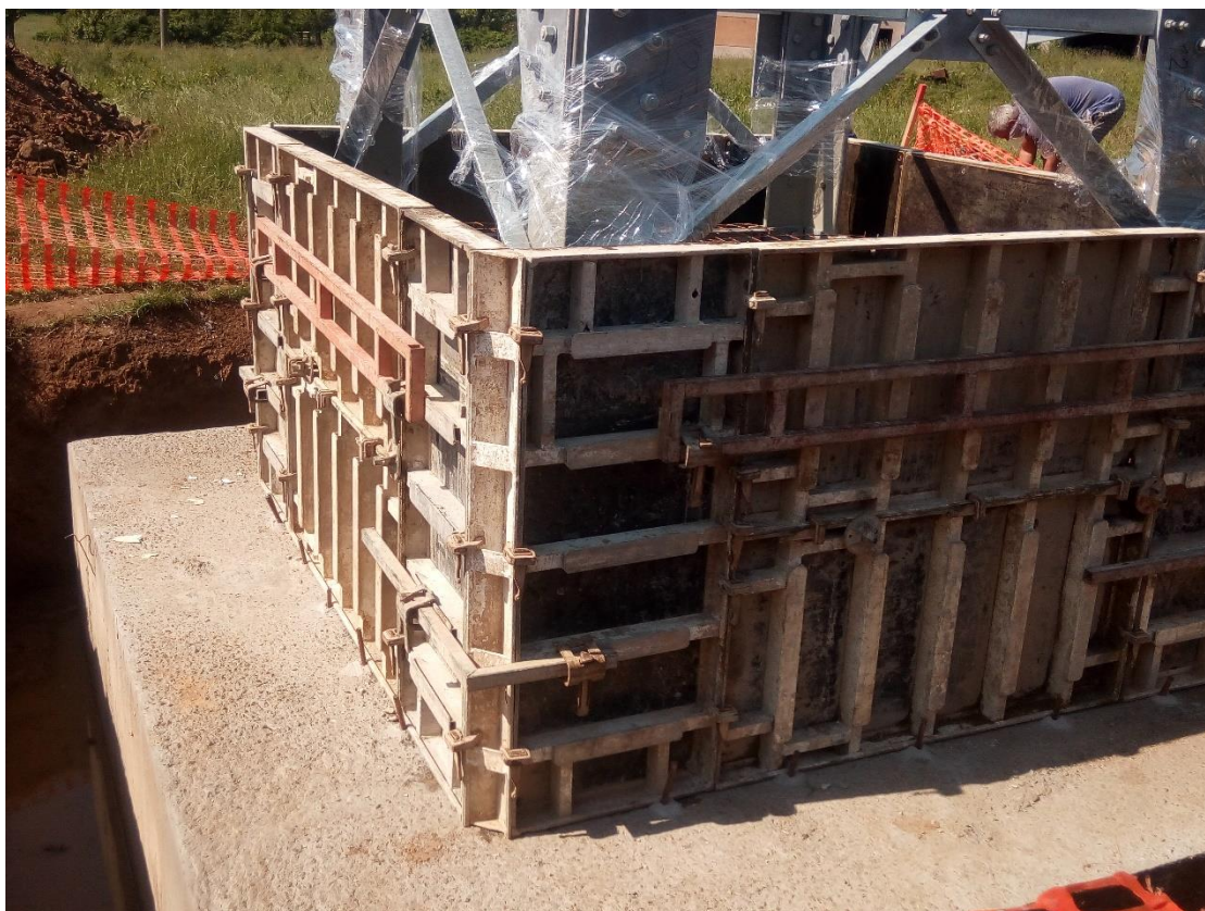
Snímek 3: Bednění pro vybudování betonového zhlaví stožáru
