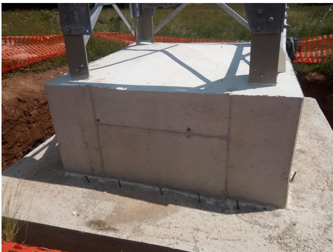
Snímek 4: Vybetonované zhlaví stožáru
