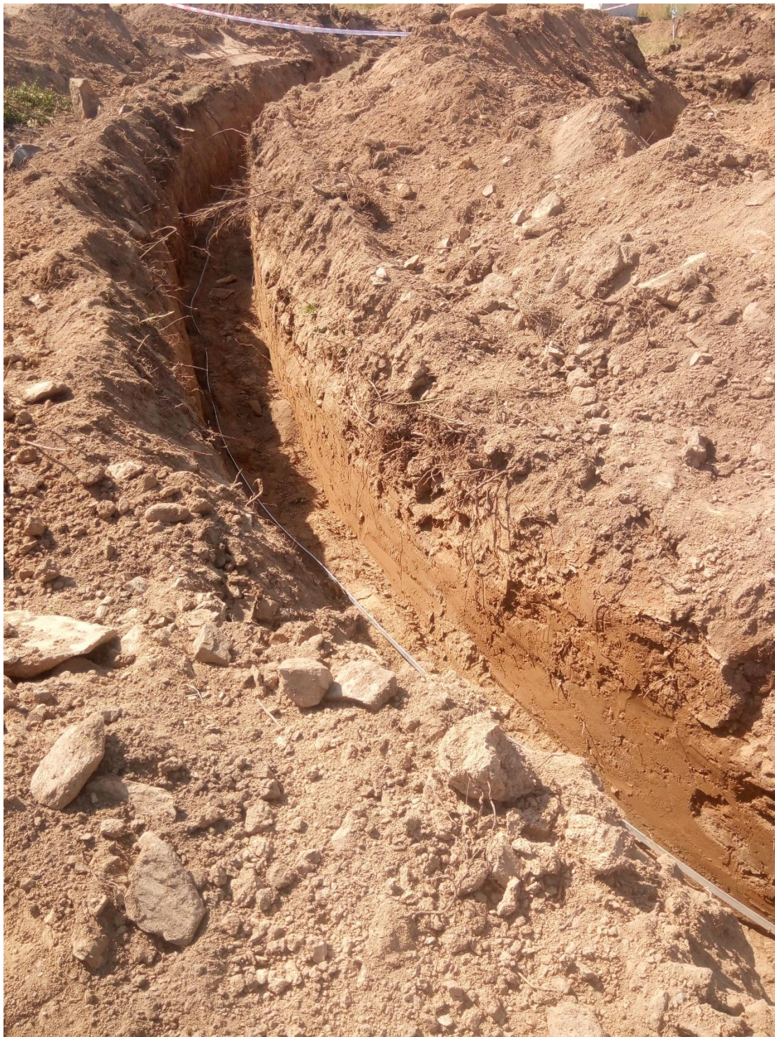
Snímek 9: Tažení pásku FeZn tvořícího vzdálený ekvipotenciální kruh
