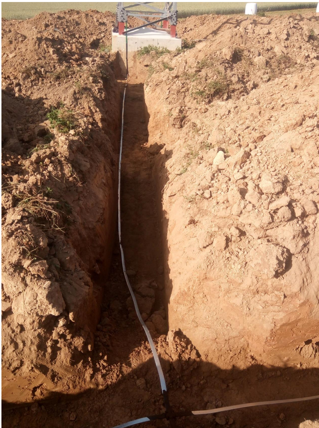
Snímek 8: Připojení ekvipotenciálního kruhu ke stožárové konstrukci
