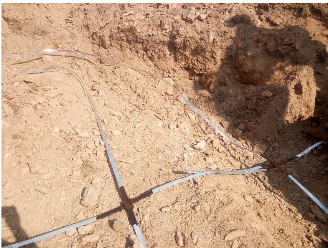
Snímek 6: Spojování pásků pomocí křížových svorek (opatřeno ochranným nátěrem)
