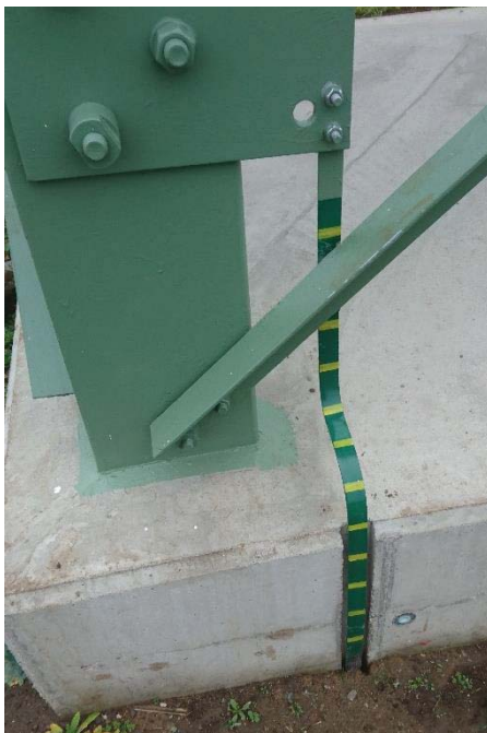
Obr. 6.2: Přívod uzemňovacího pásku
