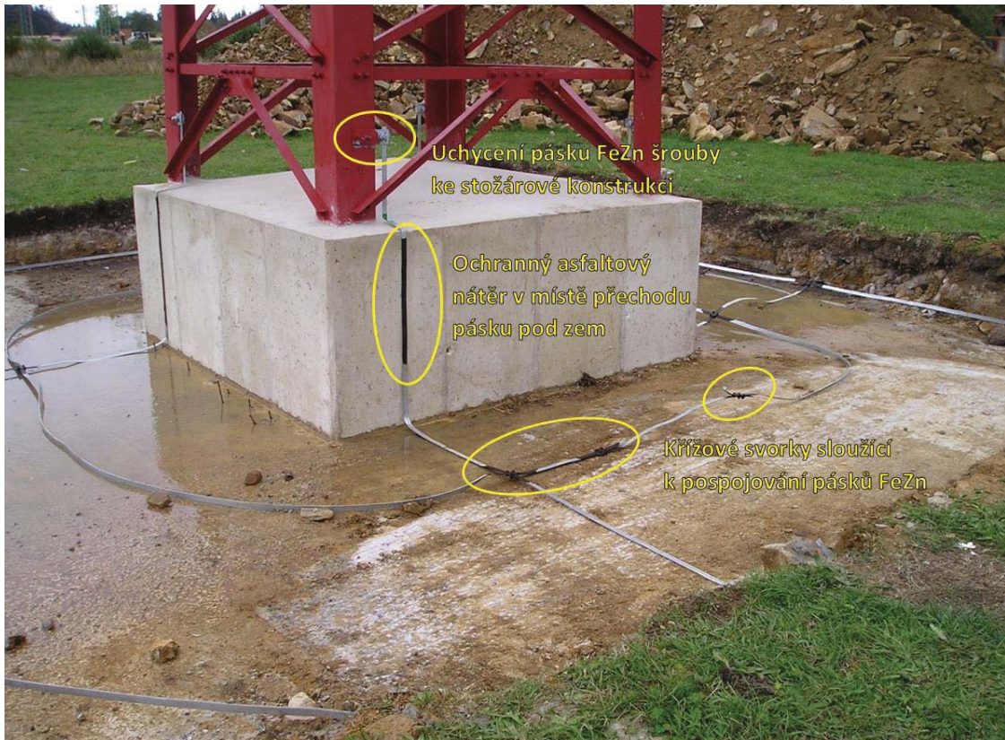
Obr. 6.1: Uzemnění stožáru FeZn páskem
