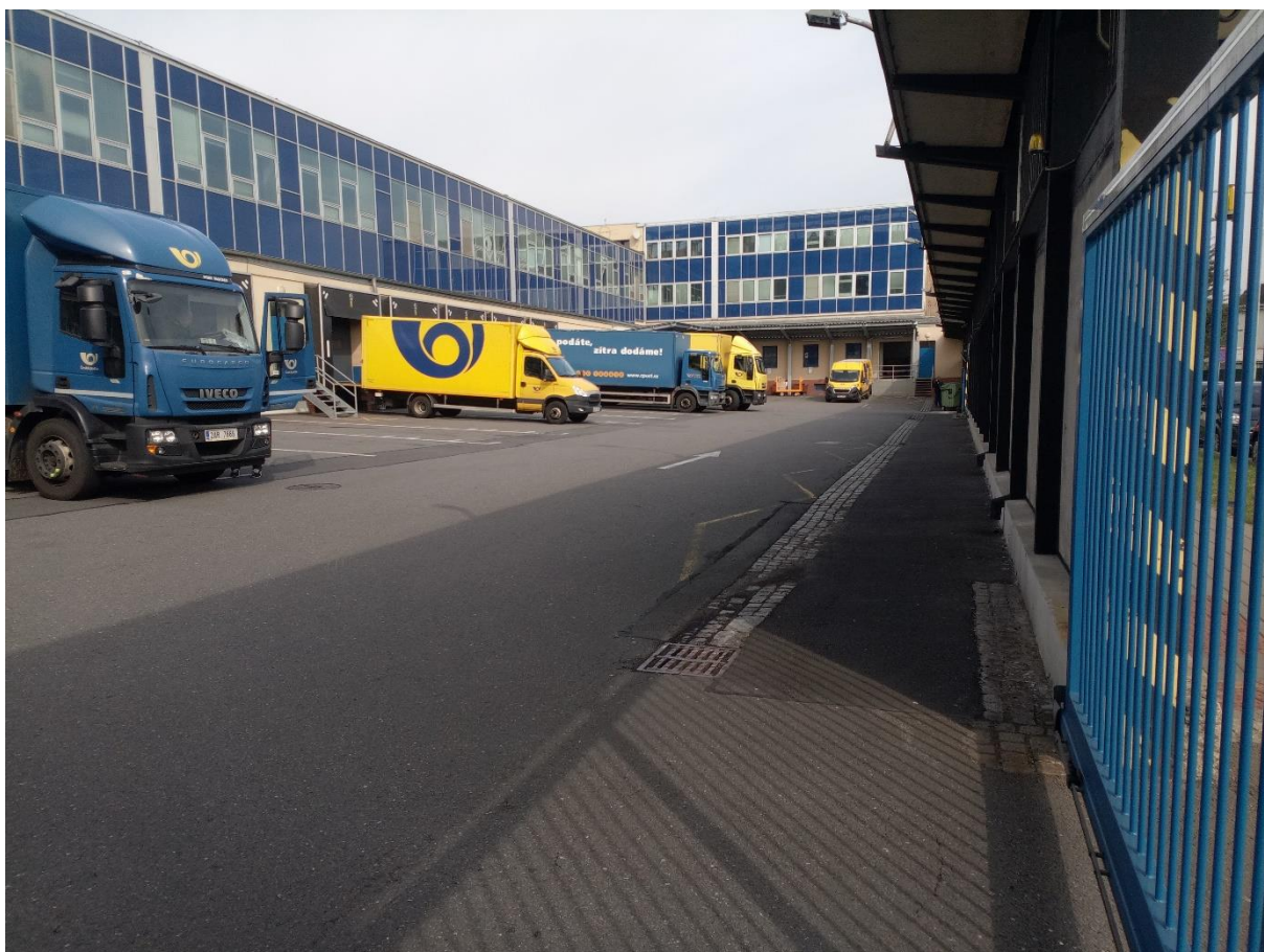
Obrázek č. 12: Nákladní prostor pro silniční vozidla v SPU Ostrava – detailní záběr
