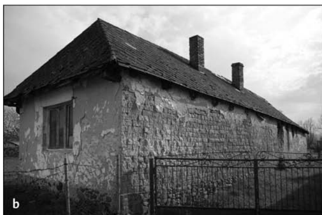
Obr. 9: Archetypálny blokový jednotraktový dom s valbovou strechou sa na zemplínskom vidieku udržal až do nástupu funkcionalistického tvaroslovia: a – Priekopa (okr. Sobrance) č. 9, podpivničený tehlový dom postavený v r. 1954 (foto M. Bohucký 1975, archív ÚEt SAV v Bratislave, č. neg. AN086957); b – Sečovská Polianka (okr. Vranov n/Topľou) č. 290, dom zo surovej tehly (foto autor 2016); c – Nacina Ves-Vybúchanec (okr. Michalovce) č. 31, kamenný dom z r. 1960 (foto autor 2013).
