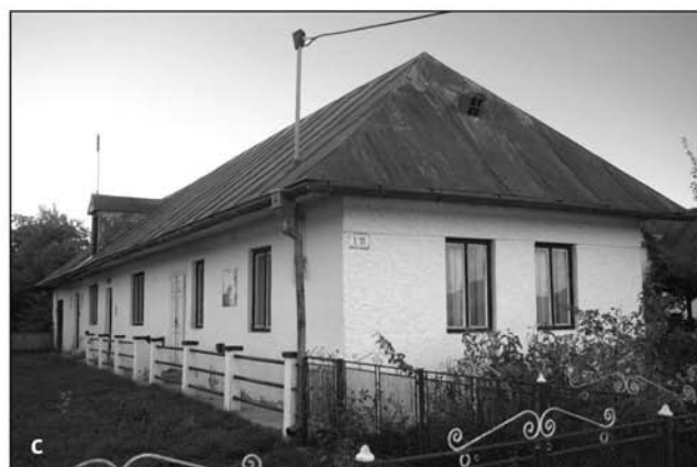
Obr. 9: Archetypálny blokový jednotraktový dom s valbovou strechou sa na zemplínskom vidieku udržal až do nástupu funkcionalistického tvaroslovia: a – Priekopa (okr. Sobrance) č. 9, podpivničený tehlový dom postavený v r. 1954 (foto M. Bohucký 1975, archív ÚEt SAV v Bratislave, č. neg. AN086957); b – Sečovská Polianka (okr. Vranov n/Topľou) č. 290, dom zo surovej tehly (foto autor 2016); c – Nacina Ves-Vybúchanec (okr. Michalovce) č. 31, kamenný dom z r. 1960 (foto autor 2013).
