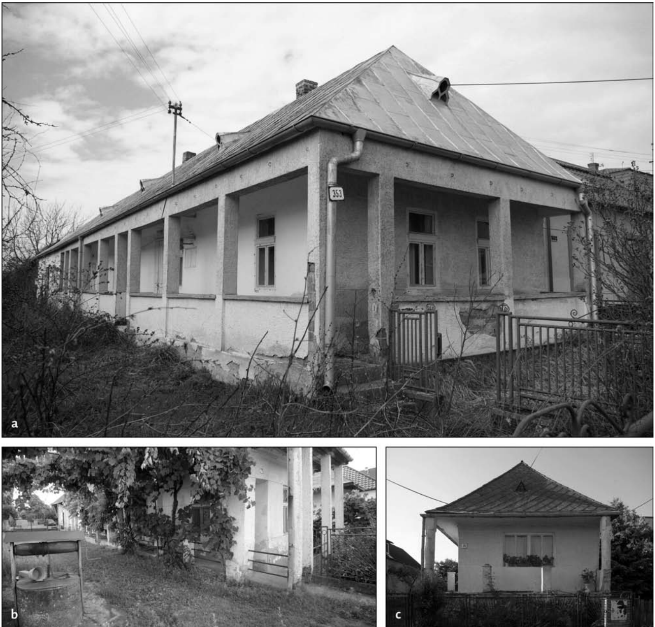
Obr. 12: Dvojamenný gánok obopínajúci dvorovú fasádu i priečelie domu: a – Bežovce (okr. Sobrance) č. 353 (foto autor 2016); b – Lúčky (okr. Michalovce) č. 39, gánok s modernistickým rúrkovým zábradlím (foto autor 2016); c – Poša (okr. Vranov n/Topľou) č. 25, gánok s piedestálmi na mieste medziľahlých stĺpov (foto autor 2018).
