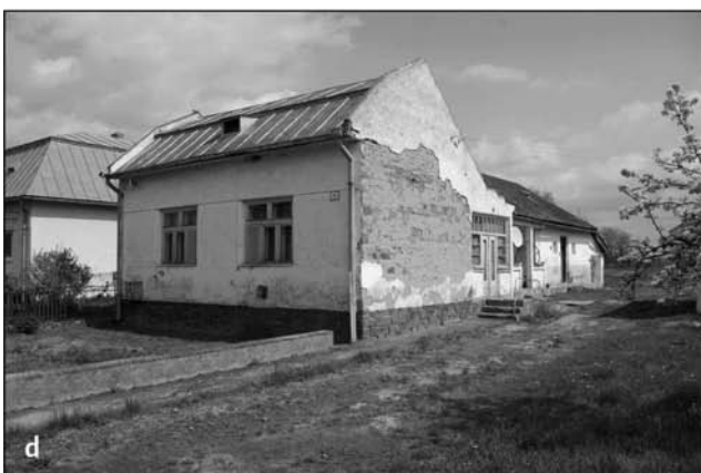
Obr. 14: Typ domu s uhlovým pôdorysom – „vinkel“, „vinkľovec“ – zo 40. a 50. rokov s variáciami tvaru strechy uličného krídla: a – „Plan na bivači dom pre Ludvika Staška z Vinne(ho)“ (okr. Michalovce), signoval Štefan Sozanský 25. 6. 1945, schválil Štátny stavebný úrad v Michalovciach 20. 12. 1946 (citácia v pozn. 2, škatuľa č. 1, i. č. 70, č. spisu 11803/46); b – Zalužice-Malé Zalužice (okr. Michalovce), prestavba staršieho domu (foto F. Šach 1954, archív Národného zemédělského muzea v Prahe, i. č. 27058/a.3.653); c – Nižné Nemecké (okr. Sobrance) č. 48 (foto autor 2016); d – Stretavka (okr. Michalovce) č. 17 (foto autor 2016); e – Pavlovce nad. Uhom (okr. Michalovce) č. 643 (foto autor 2016).
