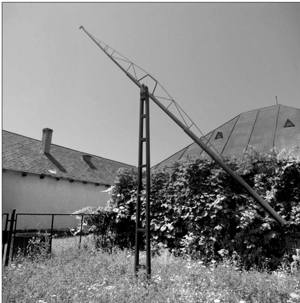
Obr. 20: Tašul'a (okr. Sobrance) č. 46, vahadlová studňa s betónovou skružou a zváraným „žuravom“ v predzáhradke vinkľového domu (foto autor 2017).
