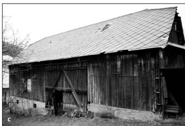
Obr. 18: Povojnové stodoly: a, b – nákras a rozpočet stodoly pre Jána Gelatiča v Lúčkach (okr. Michalovce), signoval Juraj Kavka, tesár tamže, chválil Štátny stavebný úrad v Michalovciach 11. 4. 1947 (citácia v pozn. 2, škatuľa č. 2, i. č. 41, č. spisu 1436-III/47); c, d – Jasenov (okr. Humenné) č. 115, mohutná priečne prejazdová stodola na betónových základoch, s podpivničeným zácínom a posuvným otváraním brány na ocelevej konzole (foto J. Hrabovský 2017).
