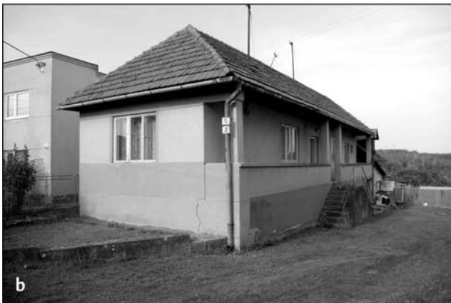
Obr. 10: Jednotraktový dom s gánkom so stĺpovou kolonádou: a – Čierne n/Topľou (okr. Vranov n/Topľou) č. 71, dom s modernistickým rúrkovým zábradlím gánku (foto P. Stano 1959, archív ÚEt SAV v Bratislave, č. neg. AN042727); b – Dargov (okr. Trebišov) č. 75, dom zo škarobetonových tvárnic, stavaný okolo r. 1950 (foto autor 2016); c – Kaluža (okr. Michalovce) č. 75, parapet gánku z opracovaných kameňov a cementových tehál a so stĺpmi z oceľových rúr na dome obývanom od r. 1950 (foto autor 2016).
