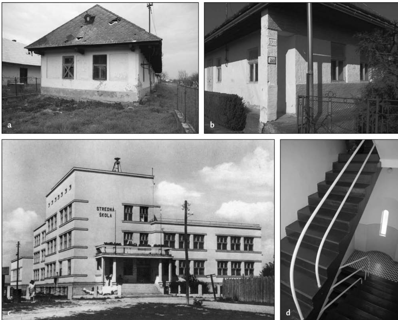
Obr. 2: Funkčnosť a funkcionalizmus: a – Bežovce (okr. Sobrance) č. 111, štandardný medzivojnový vidiecky dom z nepálenej tehly, s nehorľavou krytinou, priznanou konštrukciou stropu a jednoducho členenou fasádou (foto autor 2016); b – Ložín (okr. Michalovce) č. 265, moderná fasáda domu datovaného r. 1940 (foto autor 2018); c – Trebišov, ul. J. A. Komenského č. 32, Gymnázium, pôv. Štátna ľudová škola stavaná v r. 1936–1941, architekt Rudolf Brebta, projekčný ateliér Košice (pohľadnica z r. 1954 v archíve Ing. S. Štefana); d – Michalovce, ul. S. Chalupku č. 12, schodisko domu z 30. rokov (foto autor 2016).
