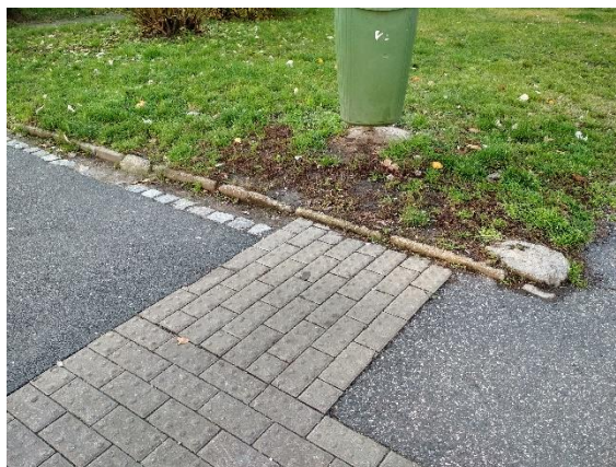
Obr. 22 – Koncová strana přechodu P1 – napojení signálního pásu na vodící linii
