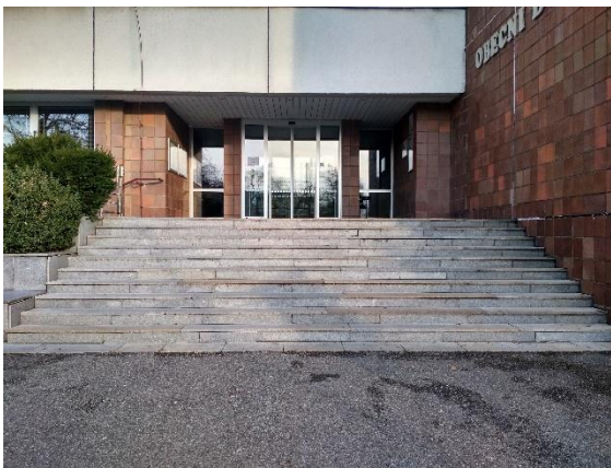
Obr. 40 – Schodiště S3.3 u Obecního domu
