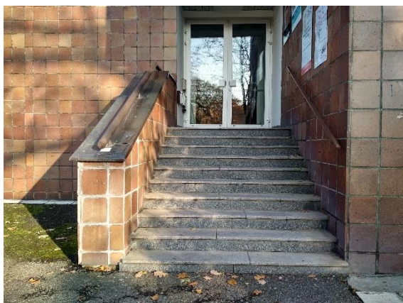
Obr. 38 – Schodiště S3.1 u předního vchodu Obecního domu
