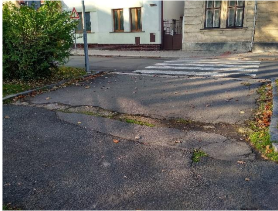
Obr. 28 – Spára na krátkém úseku k přechodu P9 (K1.9)
