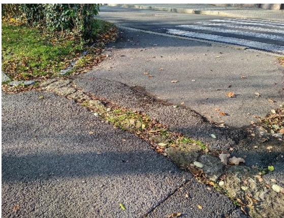
Obr. 30 – Spára na krátkém úseku k přechodu P13 (K1.10)
