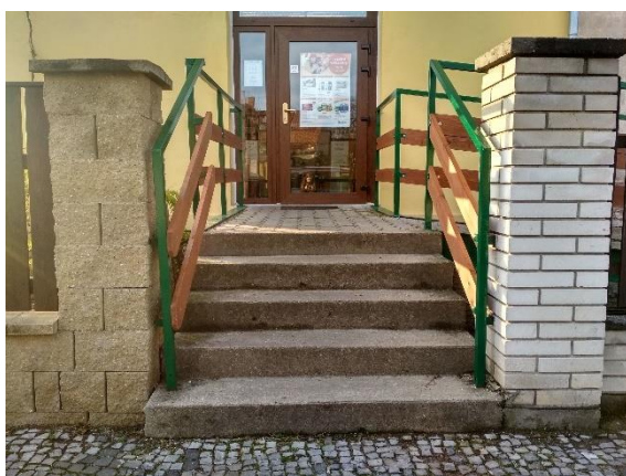
Obr. 35 – Schodiště S2 před Lékárnou 2. května
