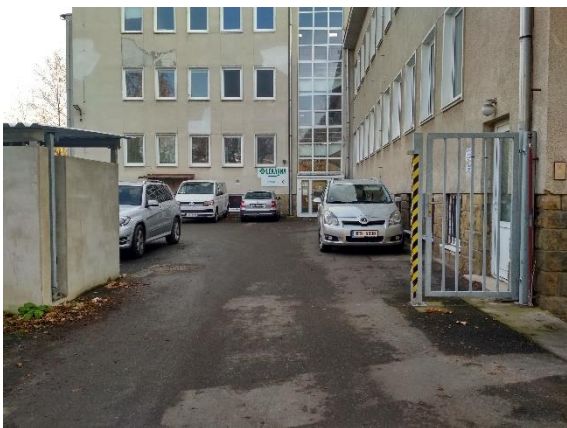
Obr. 32 – Parkující vozidlo těsně u stěny budovy Polikliniky AGEL
