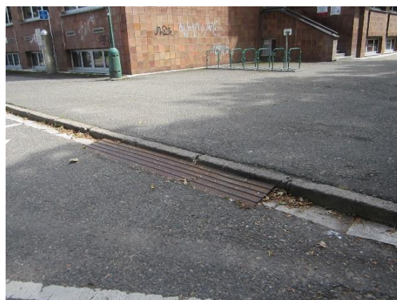
Obr. 52 – Přístup z parkoviště severně od Obecního domu přes malou železnou rampu
