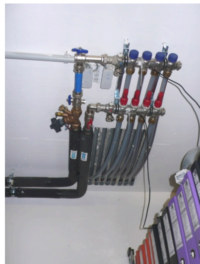
Foto 8: wasserdurchflossenes Rohrsystem in der Betondecke, Verteiler Betonkernaktivierung an der Decke
