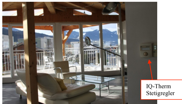
Foto 1: Büro mit hohem Glasanteil und IQTherm Stetigregler
