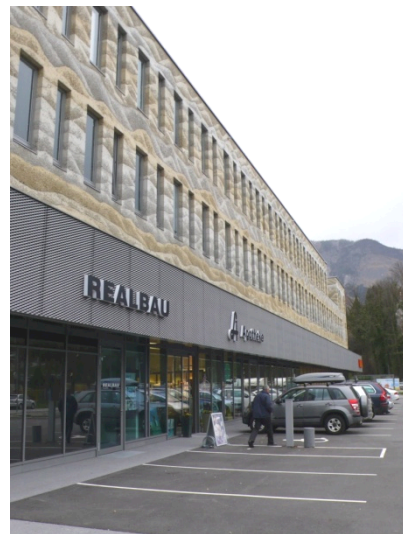
Foto 6: Betonfassade mit gering dimensionierten Fensterflächen
