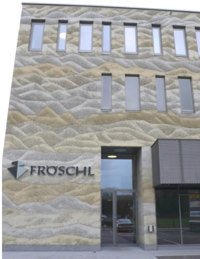
Foto 5: Betonfassade mit gering dimensionierten Fensterflächen
