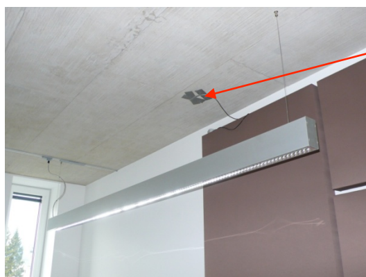
Foto 9: Fühler Oberflächentemperatur Betondecke, Sichtbetondecke Büro
