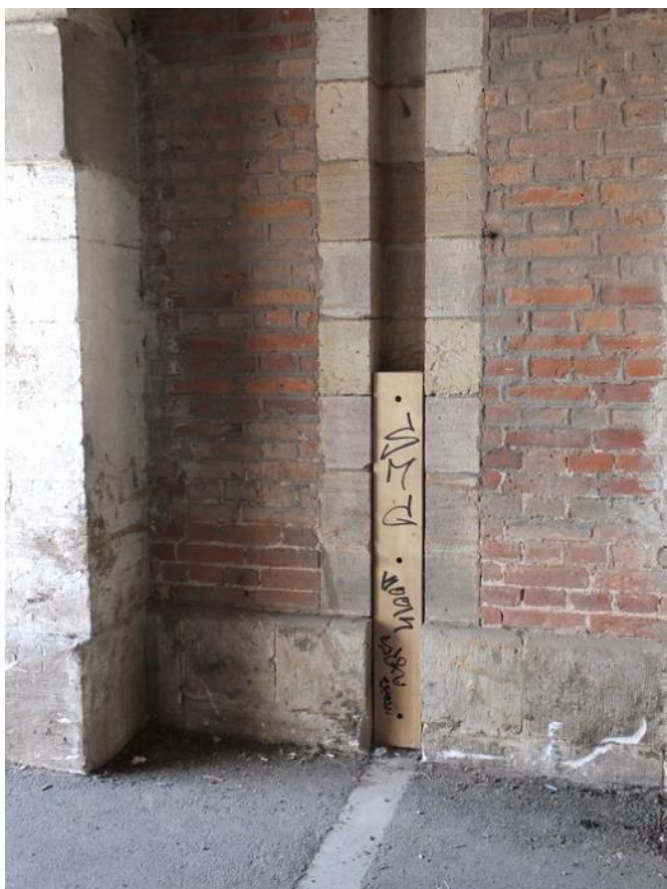
Foto 9 - Příprava pro mobilní hrazení. Foto: A. Dráb.
