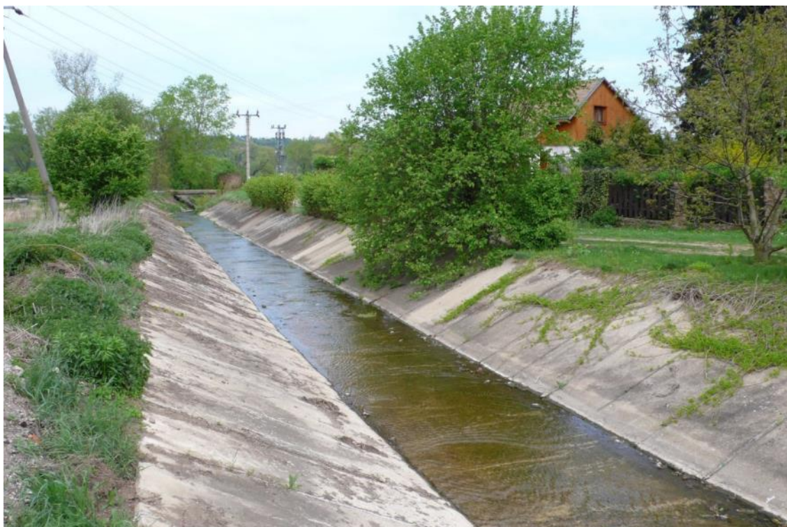
Foto 9 - Koryto vyložené betonovými deskami. Všenory u Černošic, 2008. Zdroj: Přírodě blízké úpravy vodních toků v intravilánech a jejich význam v ochraně před povodněmi
