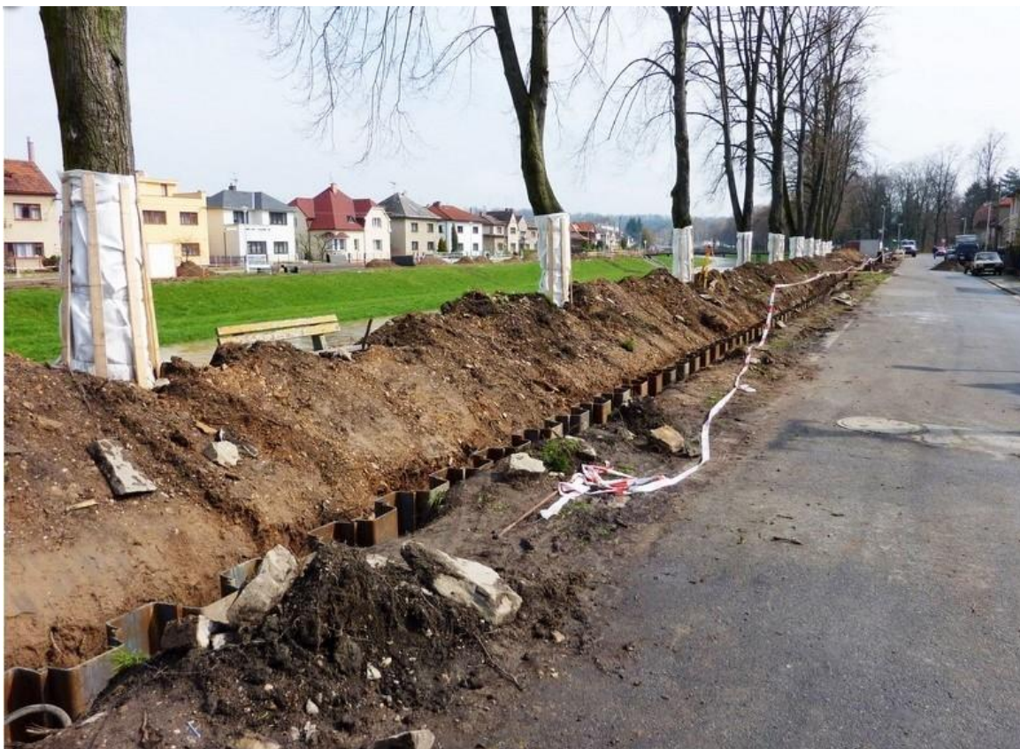
Foto 1 - Výstavba štetových stěn v těsné blízkosti stromů. Zdroj: http://www.vodohospodarske-stavby.cz/clanek/protipovodnova-ochrana-mesta-chocne/
