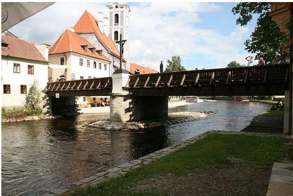
Foto 9 - Nově vymodelovaný ostrov. Český Krumlov 2010. Zdroj: http://obcan.ckrumlov.info/docs/cz/20090406085323_Vltava_protipovodnova_opatreni.xml
