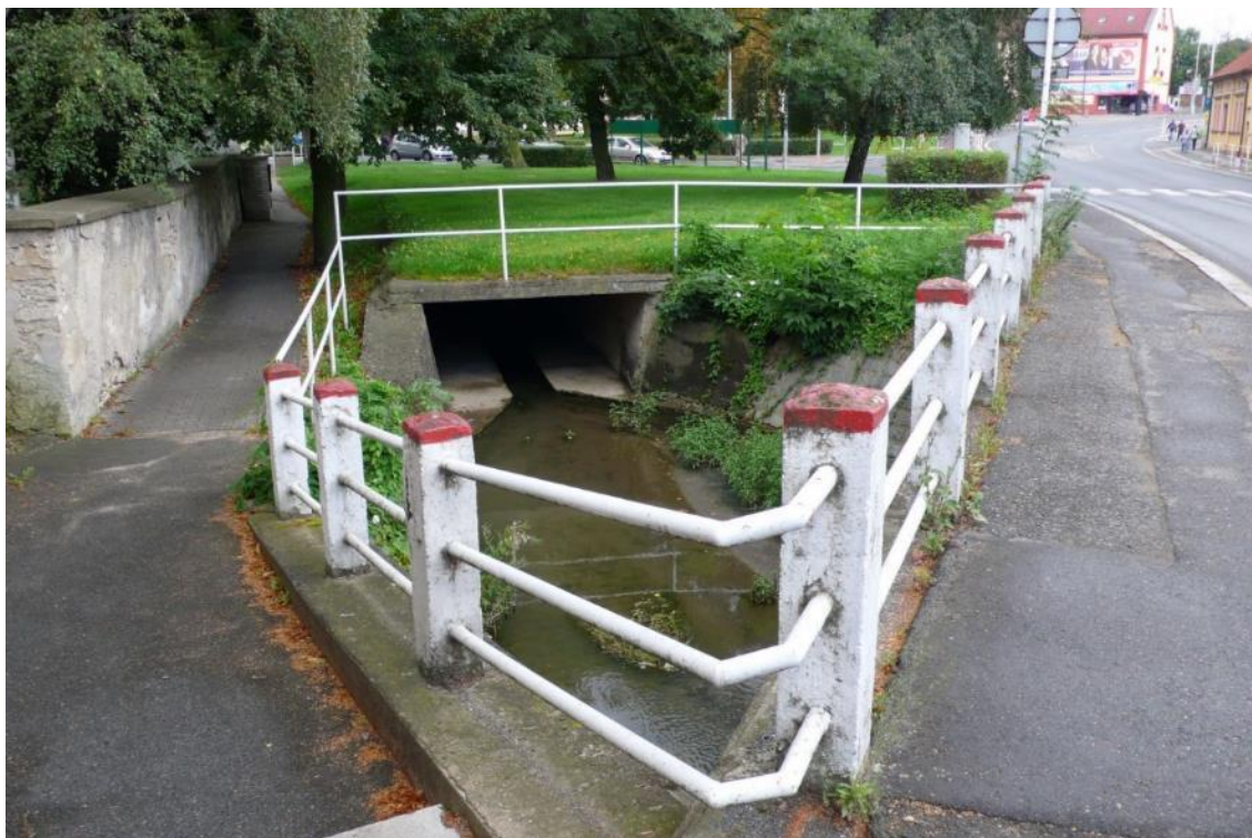
Foto 10 - Zatrubnění. Jenečský potok v Hostivici, Praha – Západ, 2010. Zdroj: Přírodě blízké úpravy vodních toků v intravilánech a jejich význam v ochraně před povodněmi
