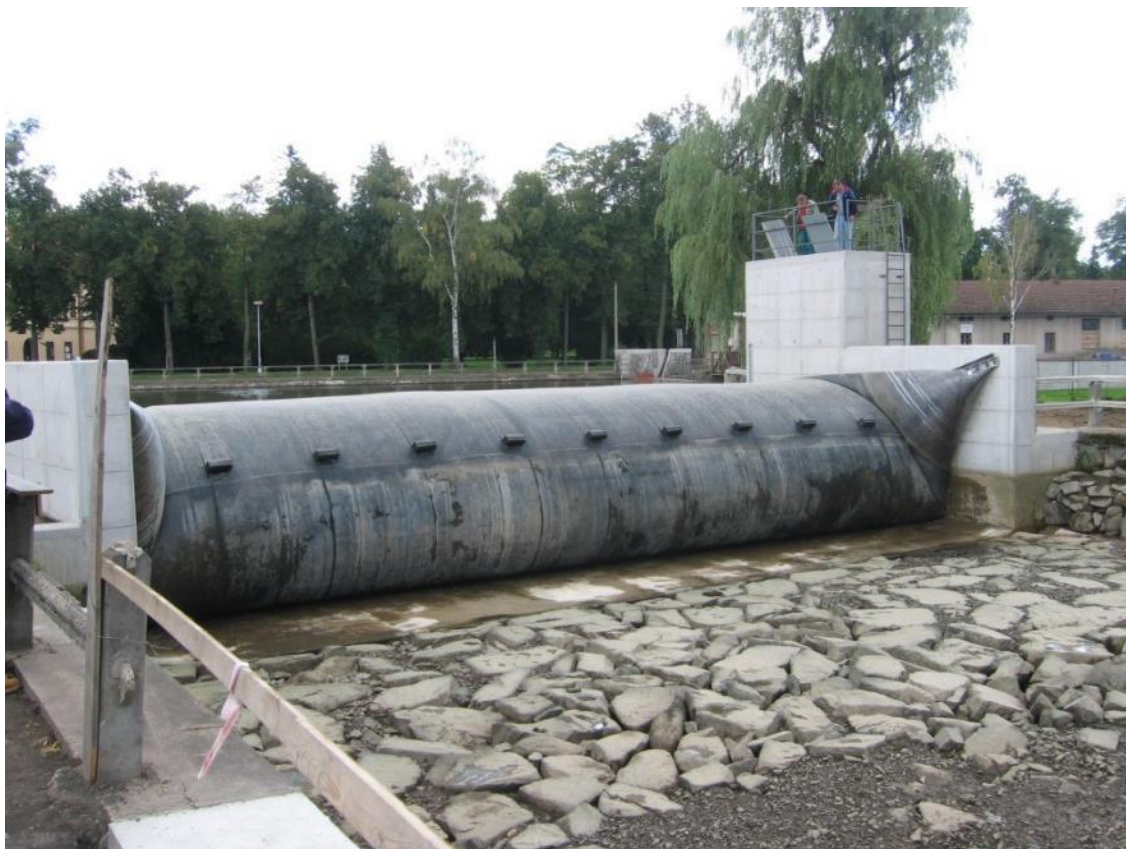
Foto 4 - Vakový uzávěr. Zdroj: https://www.kvis.cz/vodni-stavby/zvyseni-ochrany-mesta-rekonstrukci-koryta-hrazemi-chocen-ticha-orlice/
