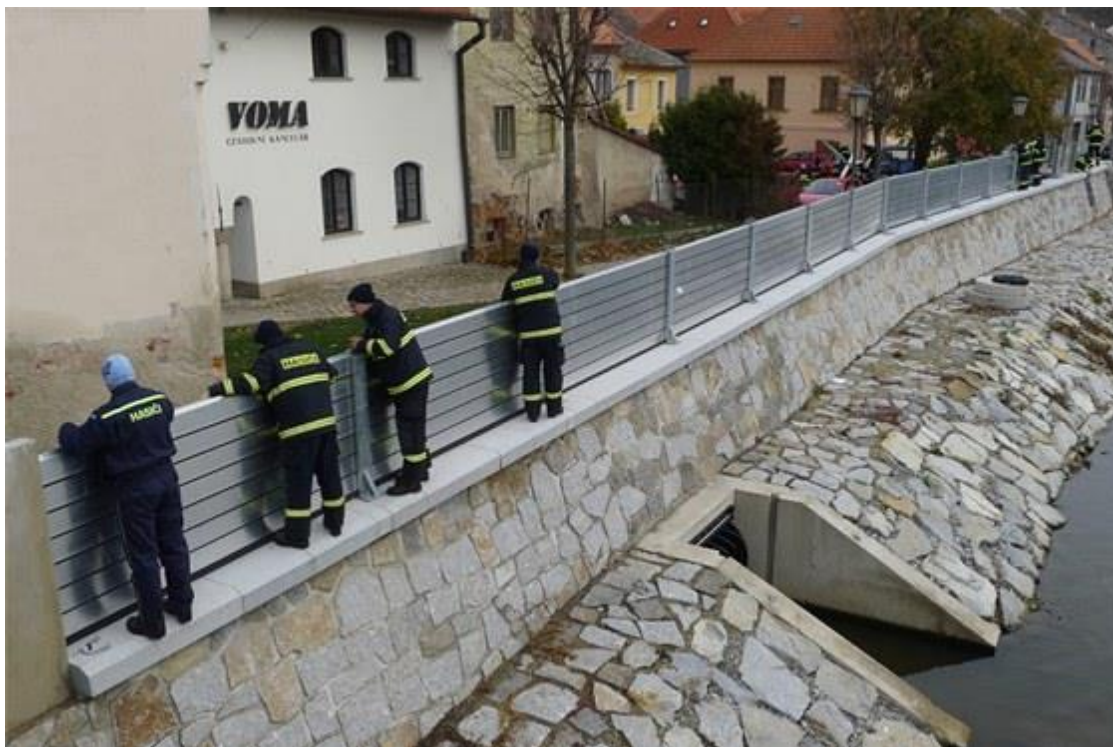
Foto 21 - Instalace mobilních zábran v Třebíči. Zdroj: https://www.idnes.cz/jihlava/zpravy/povoden-voda-reka-trebic-zabrana-zaplavy-projekt-vysocina.A180329_392441_jihlava-zpravy_mv
