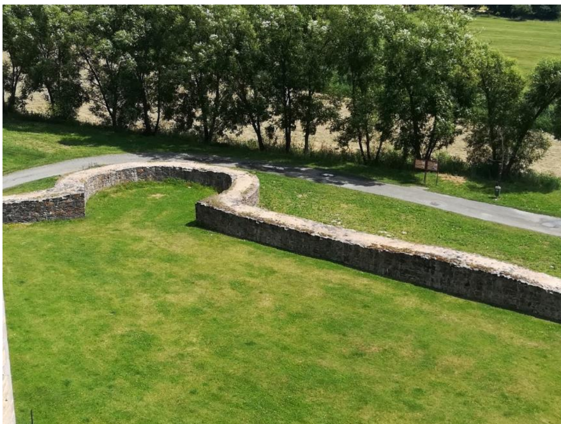
Foto 22 - Intergrace protipovodňové zdi do původního opevnění hradu Švihov. Foto: autor.
