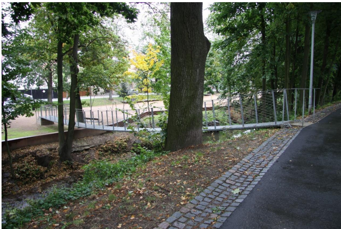
Foto 15 - Nová lávka v rámci řešení revitalizace prostoru a PPO. Litomyšl, 2019. Foto: autor.
