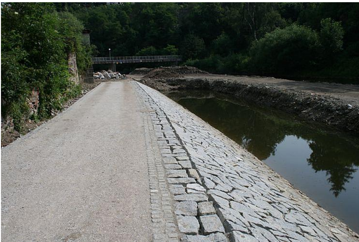
Foto 18 - Detail opevnění břehu těsně po dokončení. Český Krumlov 2010 Zdroj: http://obcan.ckrumlov.info/docs/cz/20090406085323_Vltava_protipovodnova_opatreni.xml
