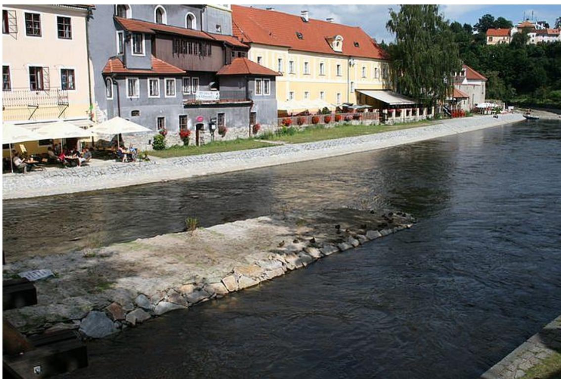
Foto 7 - Nově vymodelovaný ostrov a opevněné břehy. Český Krumlov 2010 (zdroj: http://obcan.ckrumlov.info/docs/cz/20090406085323_Vltava_protipovodnova_opatreni.xml )
