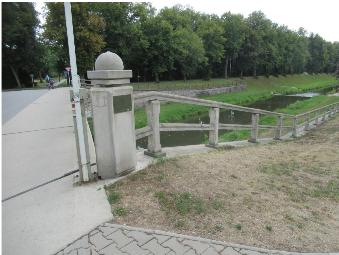
Foto10 - Detail propojení „choceňského zábradlí a nového zábradlí mostu. Choceň, 2019. Foto: autor.
