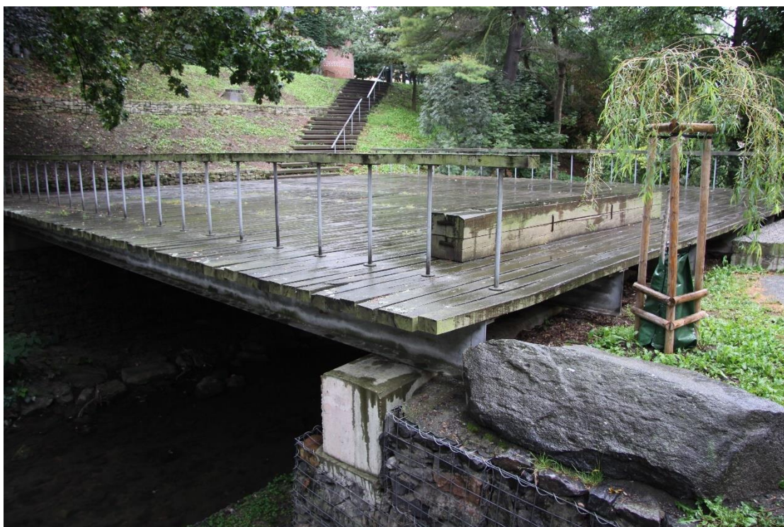
Foto 16 - Nová lávka v rámci řešení revitalizace prostoru a PPO. Litomyšl, 2019. Foto: autor.
