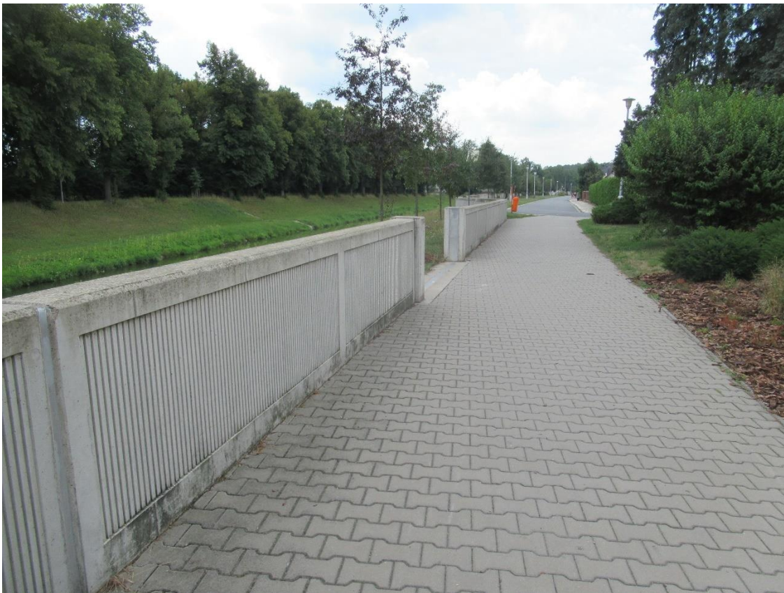
Foto 12 - Profilovaná protipovodňová zeď s přístupem pro přístup k řece. Choceň, 2019. Foto: autor.
