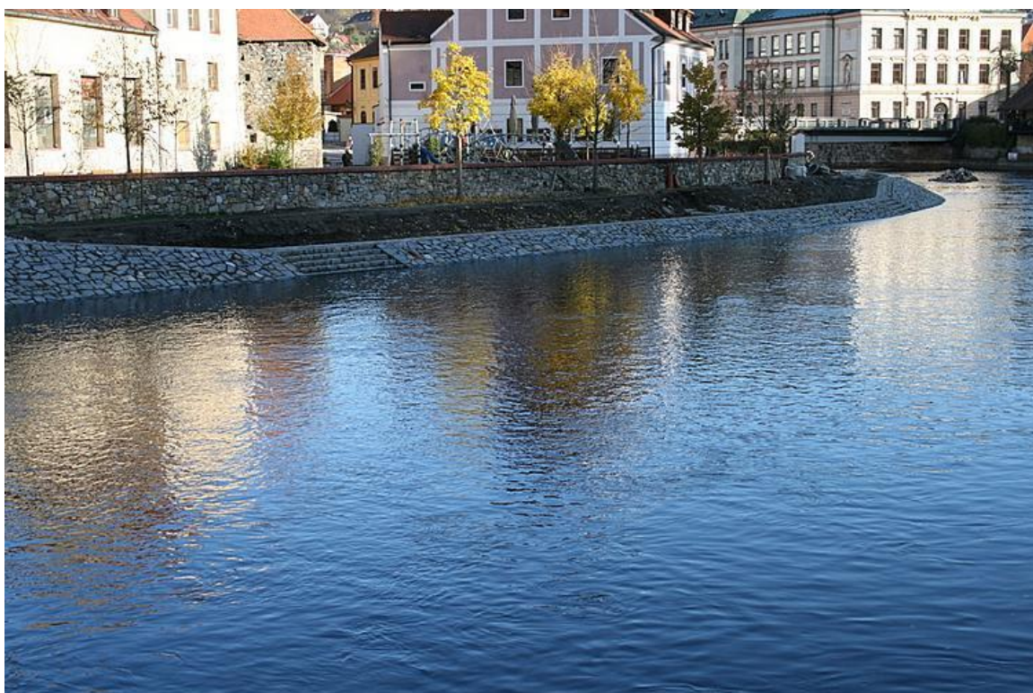
Foto 13 - Koryto po prohrábce, opevnění břehu. Český Krumlov 2010. Zdroj: http://obcan.ckrumlov.info/docs/cz/20090406085323_Vltava_protipovodnova_opatreni.xml
