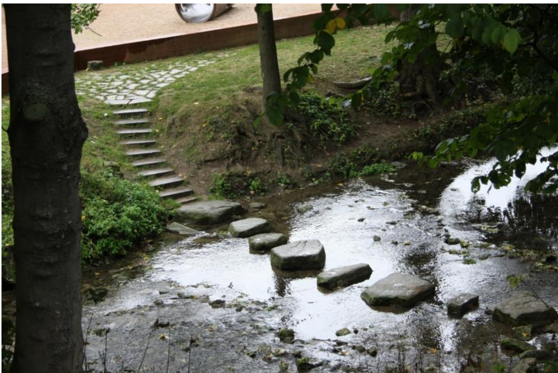
Foto 17 - Přístup k řece a protipovodňová zeď v rámci řešení revitalizace prostoru a PPO. Litomyšl, 2019. Foto: autor.
