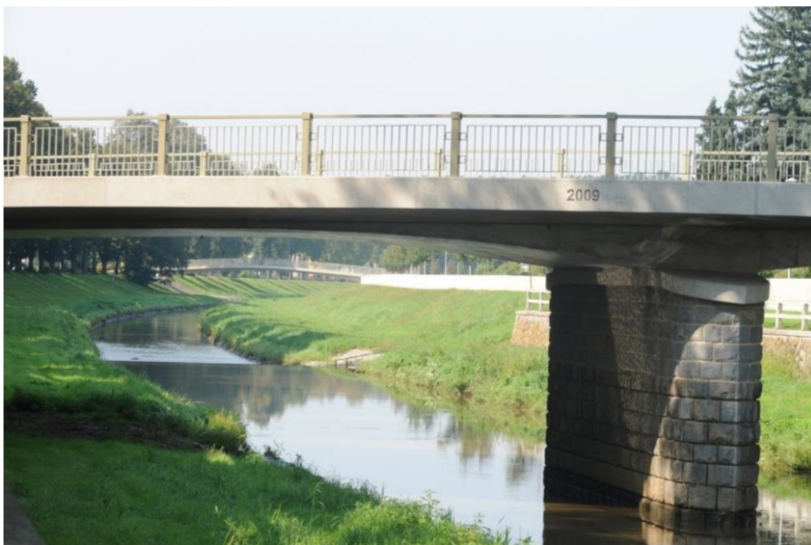
Foto 9 - Nový most u Obchodní akademie. Je vidět navýšení původního pilíře a detail zábradlí. V pozadí nová lávka pro pěší. Zdroj: archiv obce.
