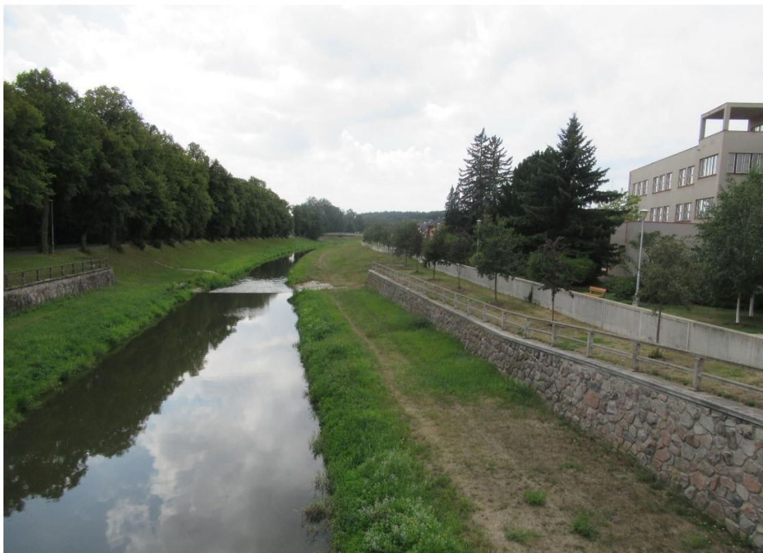
Foto 11 - Složený profil koryta toku a protipovodňová zeď. Choceň, 2019. Foto: autor.
