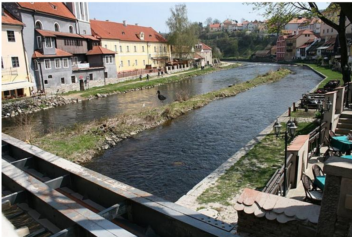
Foto 6 - Původní naplaveninový ostrůvek po vykácení stromů před prohrábkou a nezpevněná náplavka. Český Krumlov 2009. Zdroj: http://obcan.ckrumlov.info/docs/cz/20090406085323_Vltava_protipovodnova_opatreni.xml
