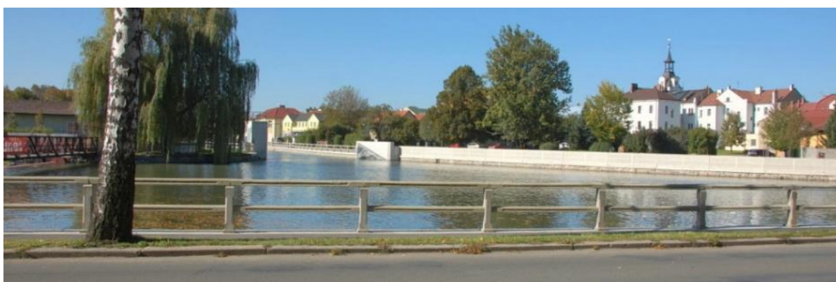
Foto 5 - Protipovodňové zdi do výše zábradlí. Zdroj: https://www.kvis.cz/vodni-stavby/zvyseni-ochrany-mesta-rekonstrukci-koryta-hrazemi-chocen-ticha-orlice/
