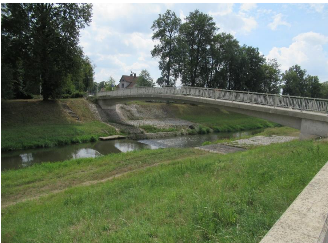
Foto 13 - Nová lávka pro pěší navazující na ulici Jiráskova s přístupem k řece. Choceň, 2019. Foto: autor.
