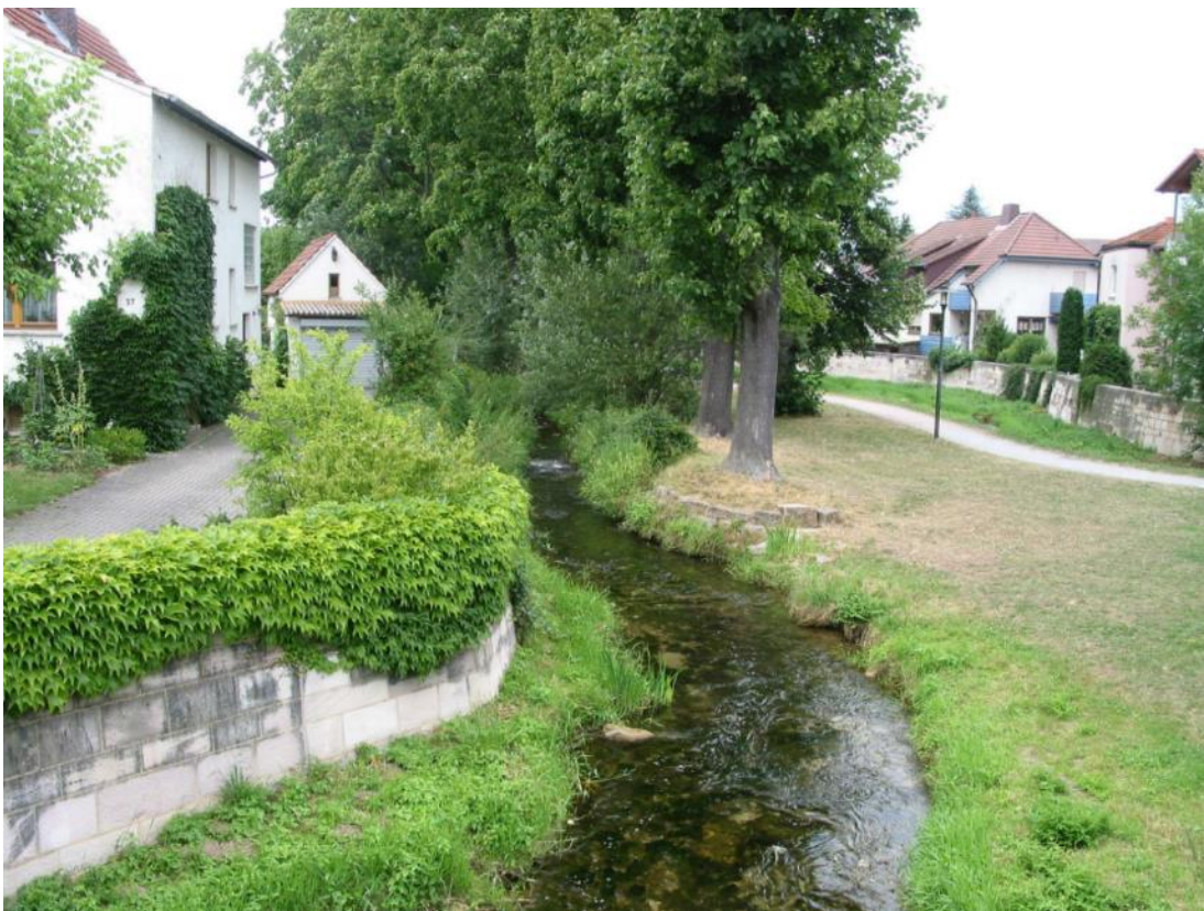
Foto 4 - Potok Lauterbach v Bad Staffelstein v Bavorsku. Protipovodňové zdi jsou odsazeny od koryta a v zátopové oblasti se nachází cesta pro pěší a zeleň s parkovou úpravou. Koryto pro běžné průtoky má přirozený tvar. (Zdroj: Přírodě blízké úpravy vodních toků v intravilánech a jejich význam v ochraně před povodněmi.)
