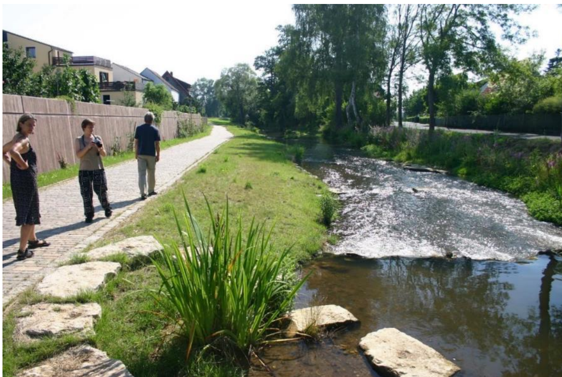
Foto 8 - Drosendorf, Bavorsko, 2008. Revitalizačnímu řešení kynety, rozšíření povodňového průtočného průřezu a povodňová stěna na rozhraní soukromého a veřejného pozemku. Zdroj: Přírodě blízké úpravy vodních toků v intravilánech a jejich význam v ochraně před povodněmi.
