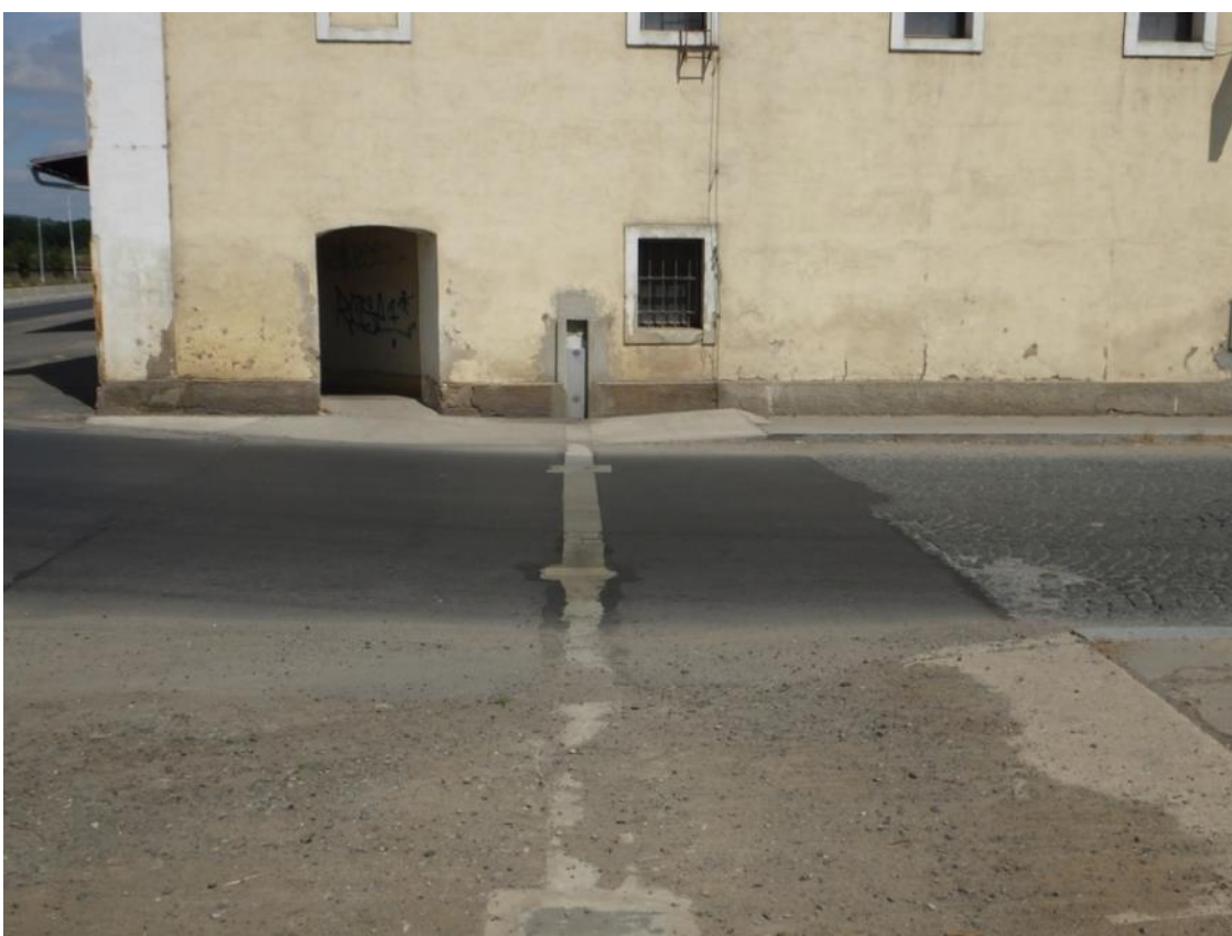
Foto 7 - Příprava pro mobilní hrazení. Foto: A. Dráb.
