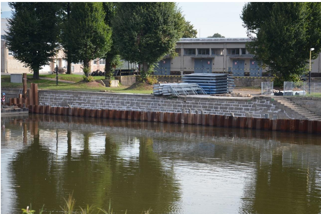
Foto 2 - Oprava nábrežních zdí, 2013. Fotoj: autor.
