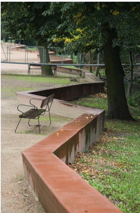
Foto 14 - Protipovodňová zeď, řešení v rámci řešení revitalizace prostoru a PPO. Litomyšl, 2019. Foto: autor.
