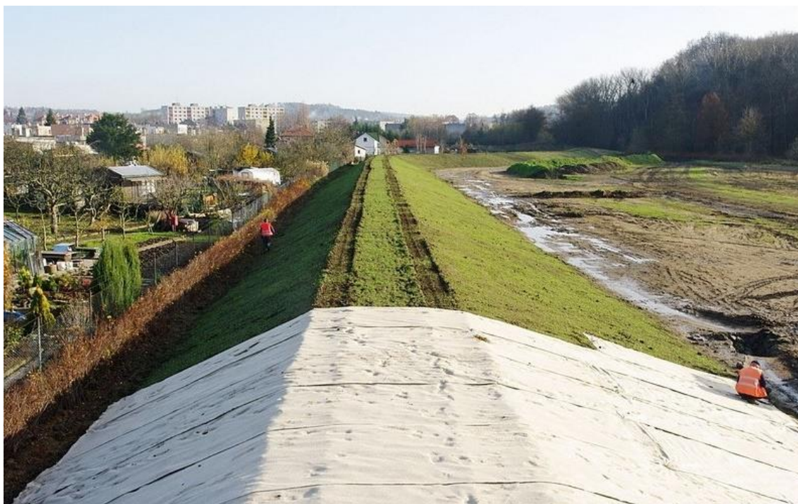
Foto 3 - Povodňová zemní hráz u zahrádkářské kolonie. Zdroj: http://www.vodohospodarske-stavby.cz/clanek/protipovodnova-ochrana-mesta-chocne/
