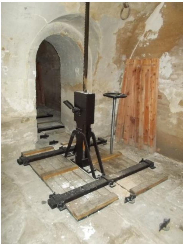
Foto 6 - Historické stavidlo. Foto: A. Dráb.
