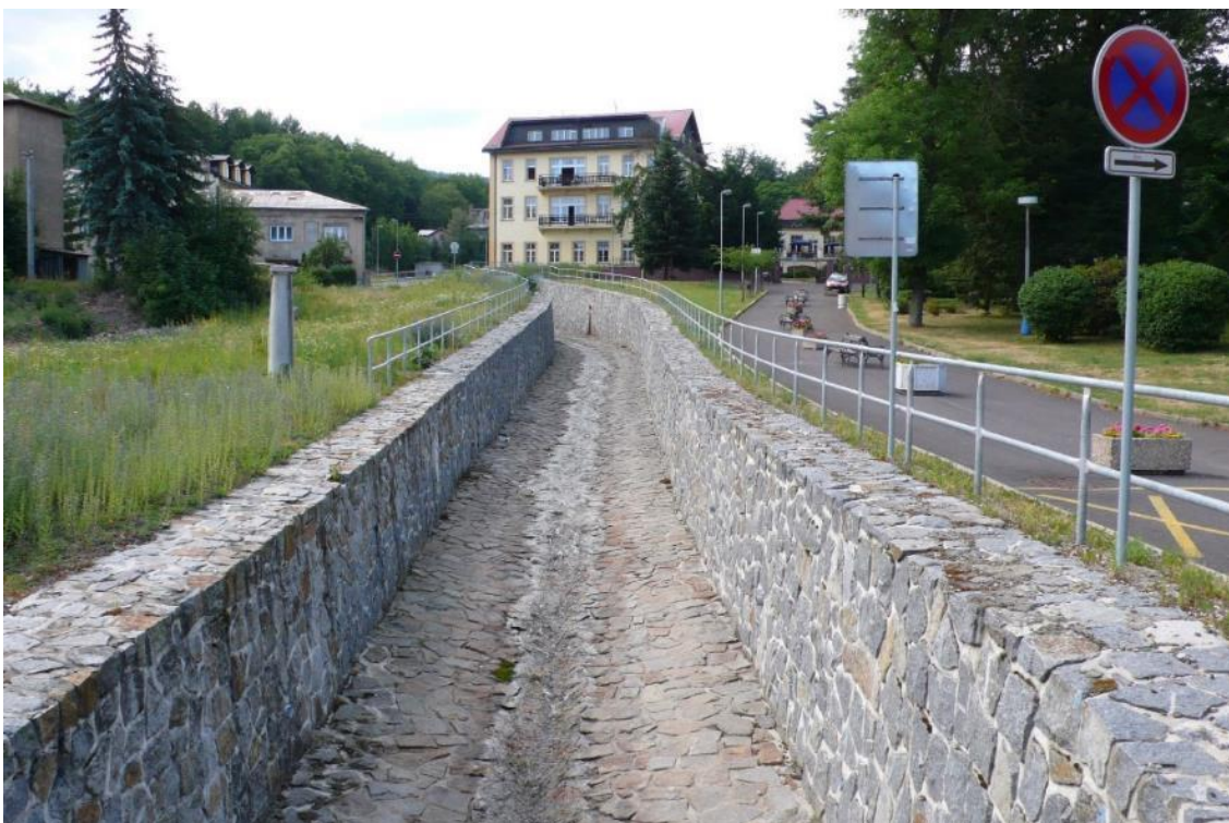
Foto 6 - Úprava Bystřice v Dubí u Teplic, provedená po povodni roku 2002. Nevhodné sevření potoka do opevněného koryta, nevyužití okolního prostoru k volnému rozlivu. Zdroj: Přírodě blízké úpravy vodních toků v intravilánech a jejich význam v ochraně před povodněmi.
