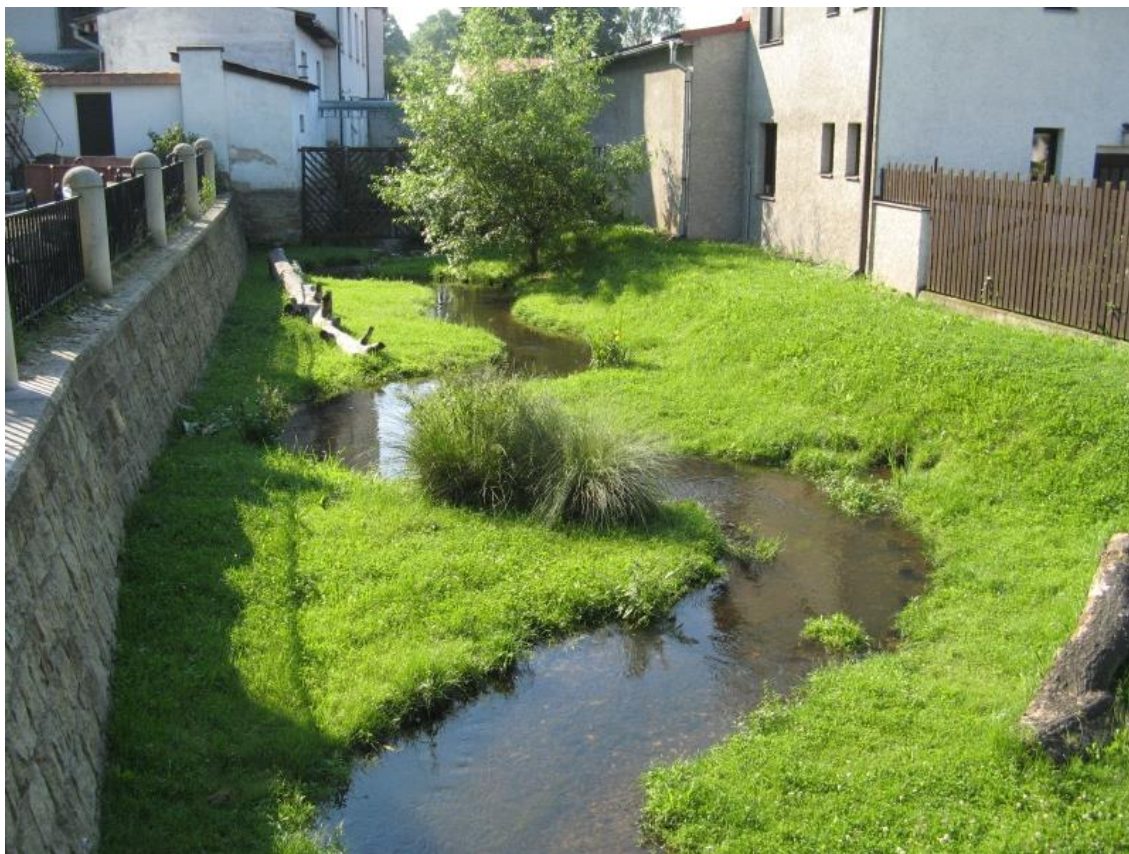
Foto 7 - Revitalizace strouhy. Chrudim 2010. Přírodě blízká úprava kynety vodního toku. Zdroj: http://sindlar.cz/nahon-chrudim/
