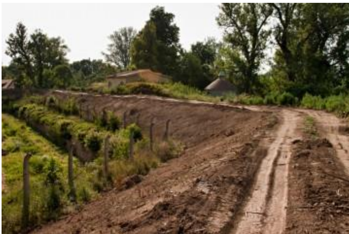
Foto 11 - Navršení zemní hráze. Zdroj: : http://fort-terezin.cz/zaplavy-v-roce-2013/velka-voda-2013-1-cast.html
