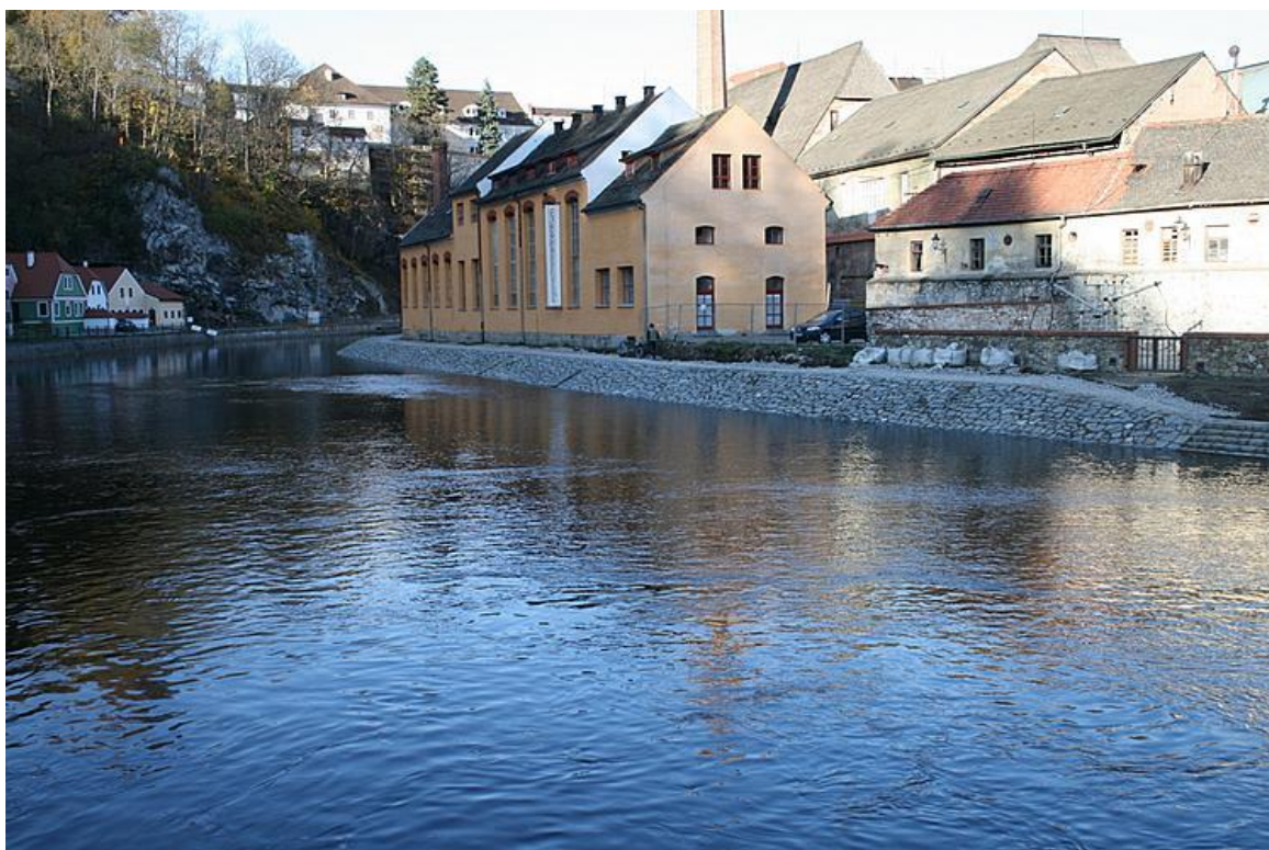
Foto 17 - Koryto po prohrábce, zúžení a opevnění břehu. Český Krumlov 2010. Zdroj: http://obcan.ckrumlov.info/docs/cz/20090406085323_Vltava_protipovodnova_opatreni.xml
