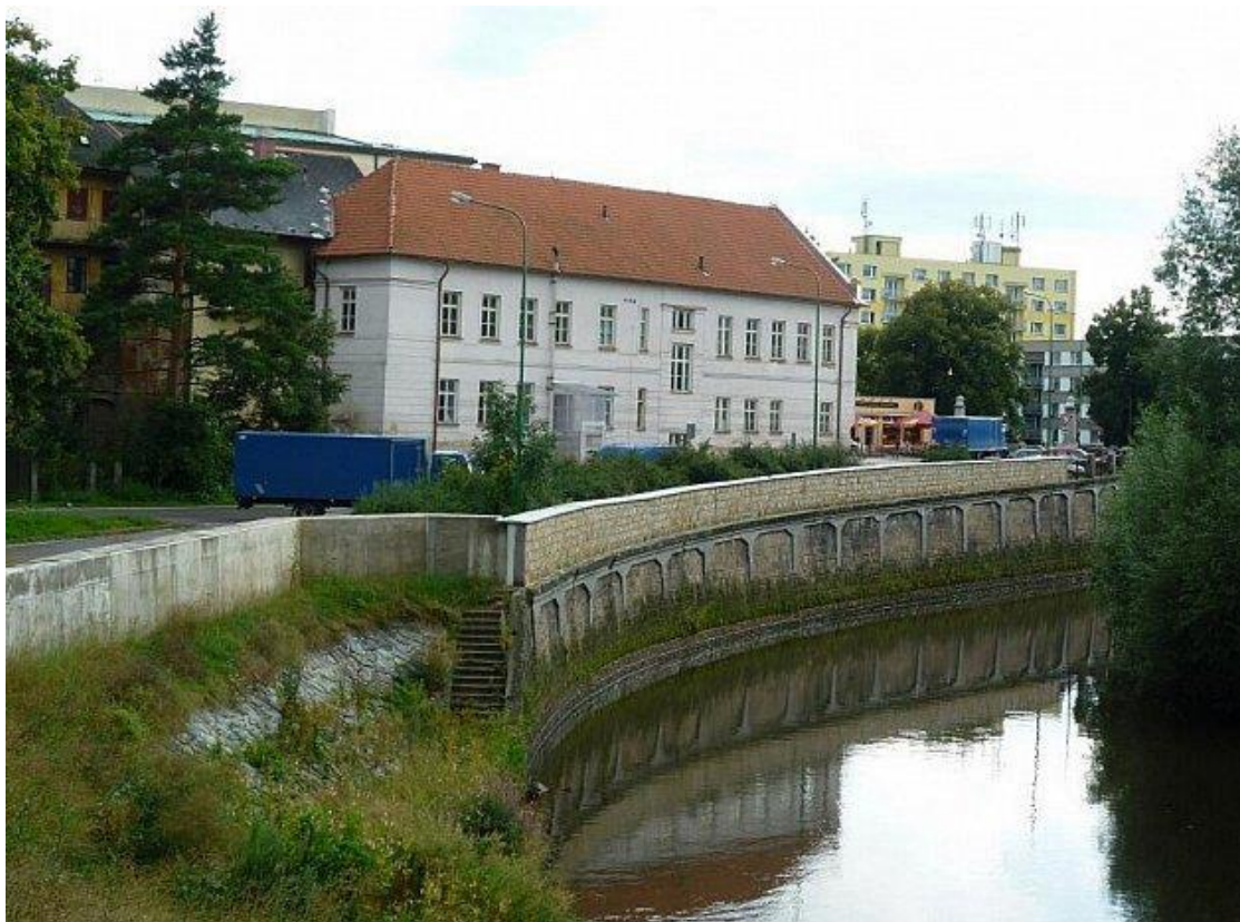
Foto 19 - Protipovodňová zeď v Jaroměři. Přístup k řece byl zcela uzavřen. Zdroj: https://nachodsky.denik.cz/zpravy_region/protipovodnove-zabrany-jaromeri-otevrelly-nove-moznosti-20180913.html
