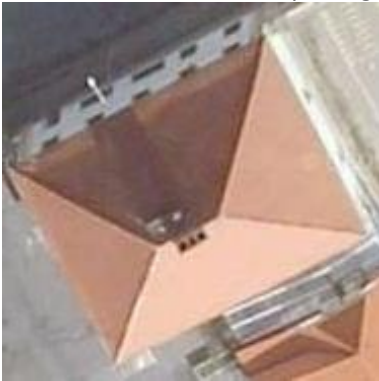
Obr. 17. LMS budovy s valbovou střechou [1]
