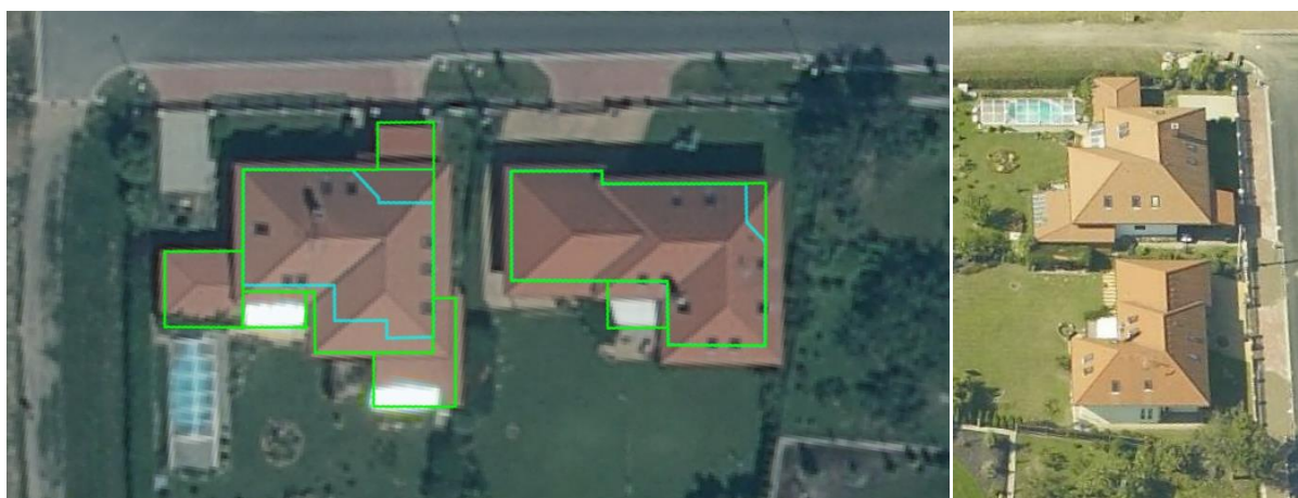
Obr. 152. Ortofoto se dvěma budovami s přesahem střechy (zelená linie) přes obvodové zdivo (azurová linie, vlevo), šikmý snímek stejných budov z východu (vpravo) [88]
