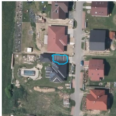
Obr. 110. Ortofoto z roku 2015 a indikace nového přístřešku
