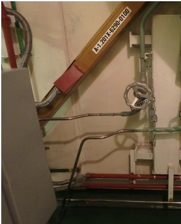
Obr. 7. Předpokládané připojovací místo hadice odluhu do trasy VF60Z90.
