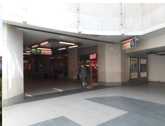
Obr. 24 Osvětlení vestibulu metra Bořislavka, int.
