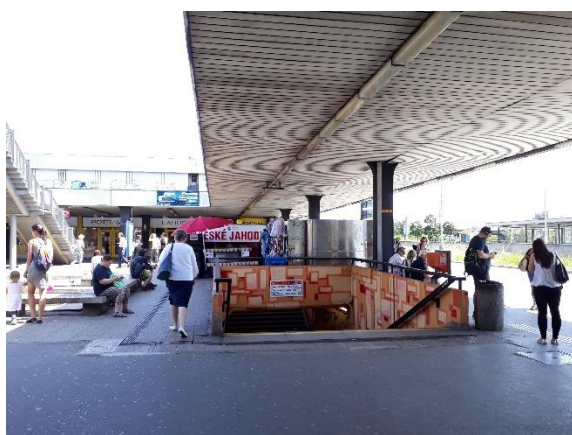
Obr. 71 Podchod u stanice metra Roztyly
