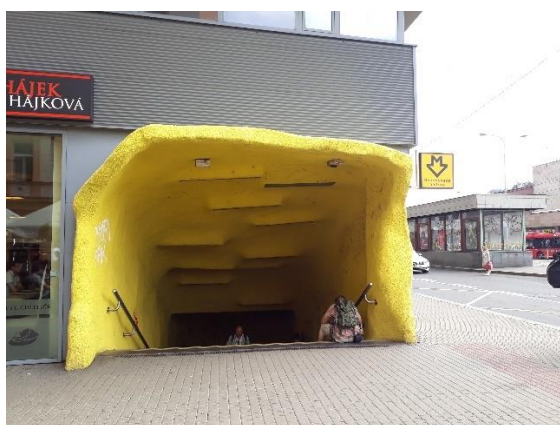
Obr. 11 Vstup, Smíchovské nádraží
