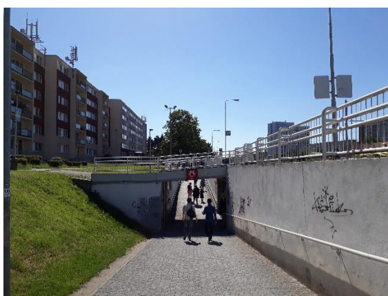
Obr. 65 Podchod u stanice metra Ládví
