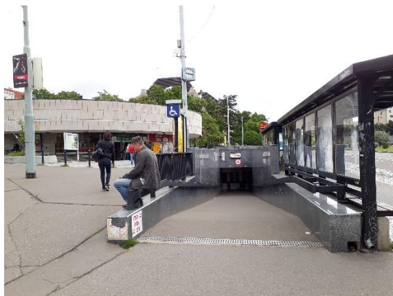
Obr. 67 Podchod u stanice metra Strašnická
