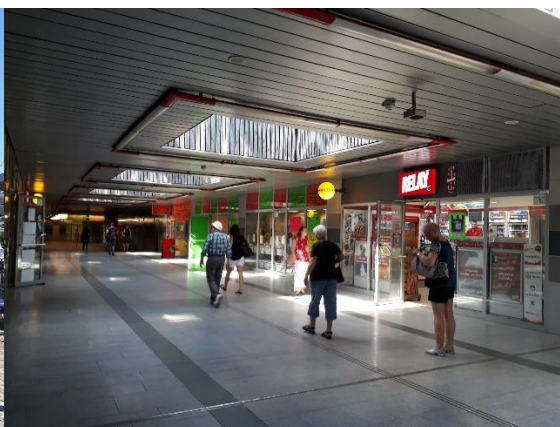
Obr. 20 Osvětlení vestibulu metra Prosek, int.
