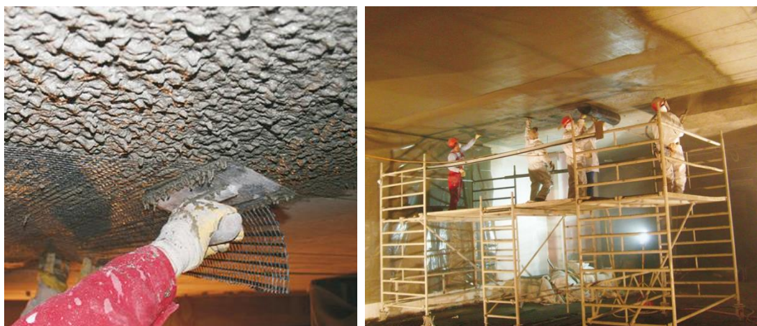
Obr. 26 Zesílení nevyhovující stropní konstrukce v budově v Praze pomocí uhlíkové textilní výztuže [109]
