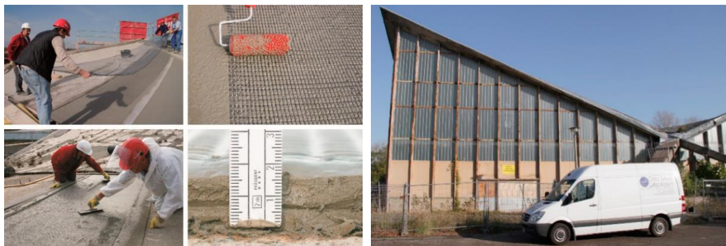
Obr. 25 Oprava ŽB střešní konstrukce pomocí vrstvy TRC [108]
