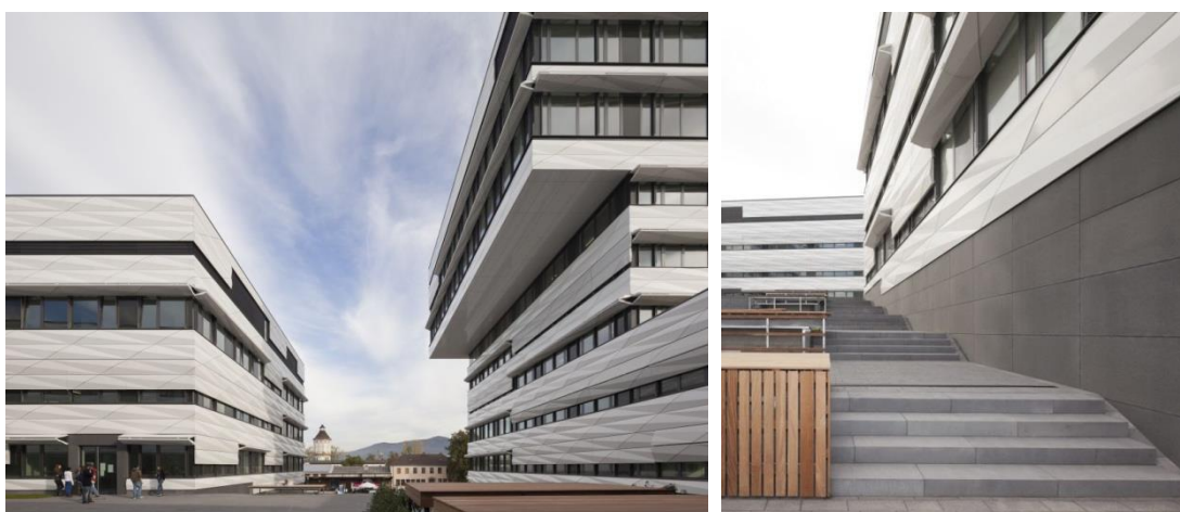
Obr. 21 Fasádní panely z TRC od firmy Hering na budově Skylab, budově laboratoře v oblasti Bahnstadt, nové městské čtvrti Heidelbergu [96]
