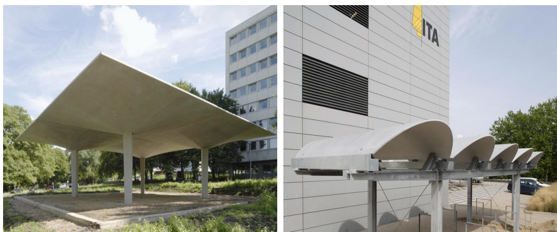
Obr. 24 Zastřešení skořepinovou konstrukcí v RWTH Aachen [92, 104]
