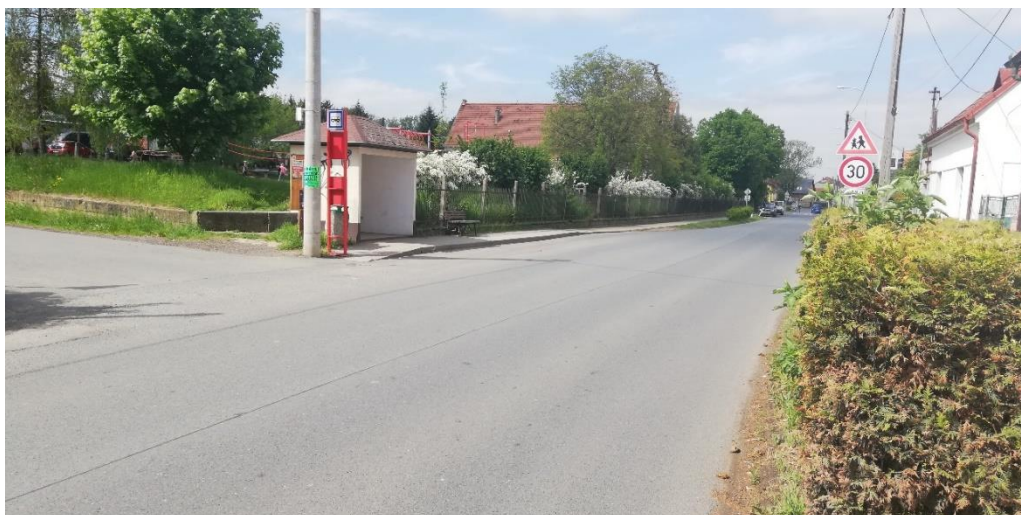
Obr. č. 19 – Úsek ulice Průběžná před místní sokolovnou, pohled ze zastávky Zdiby, Veltěž, Pošta (autor)
