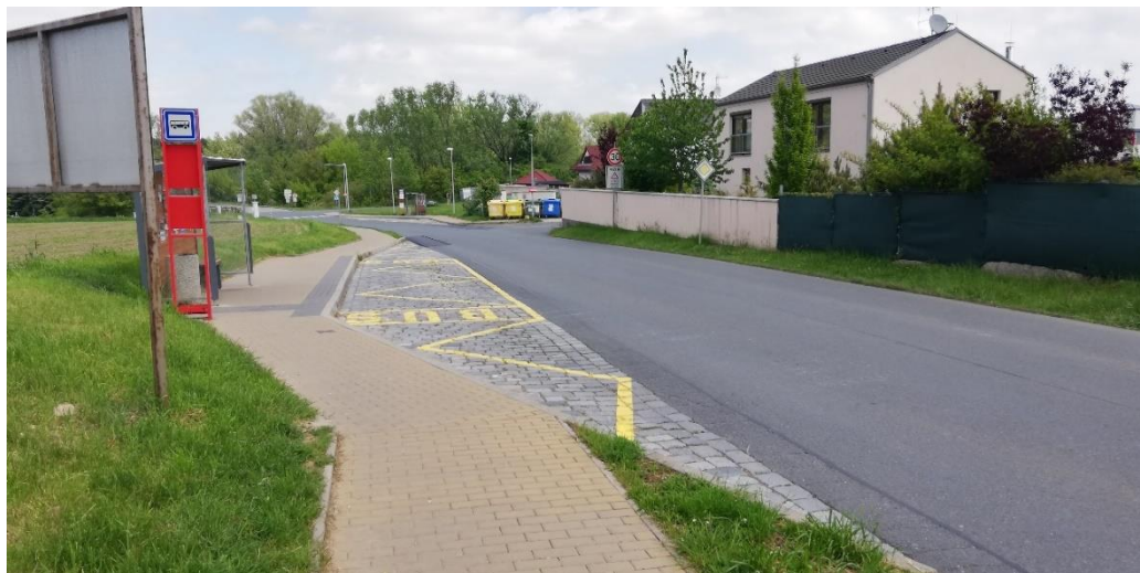
Obr. č. 39 – Autobusová zastávka Zdiby, Přemyšlení, V Remízkách s přílehlou křižovatkou ulic (autor)
