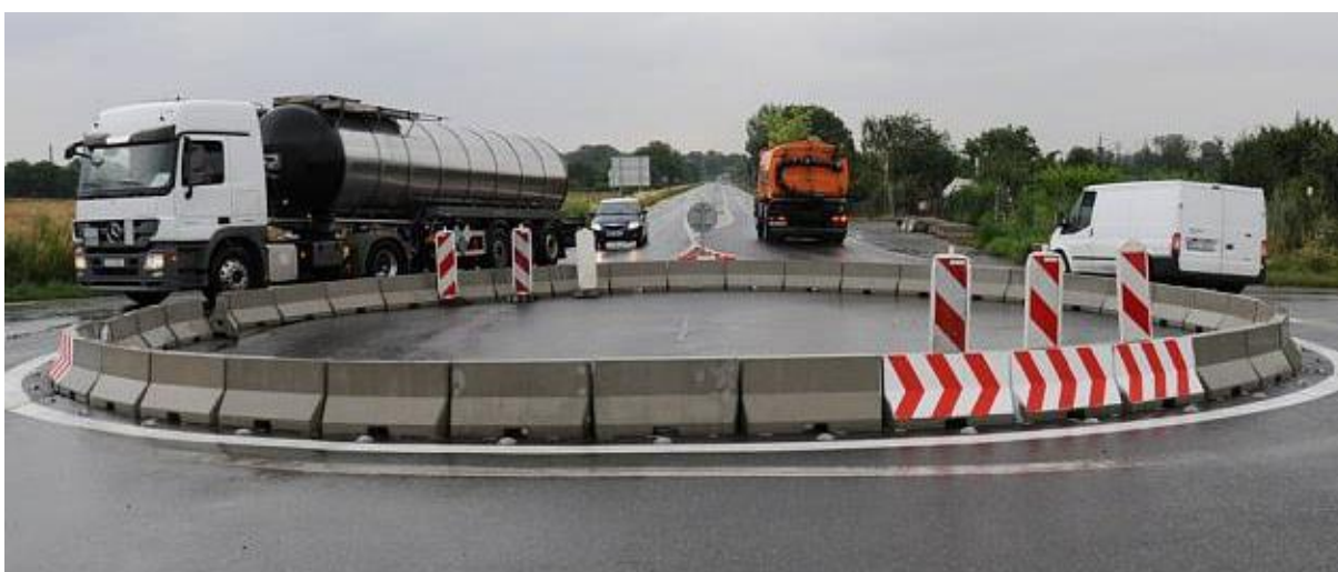
Obrázek 7: Provizorní okružní křižovatka "U Kapličky" před úpravou v dubnu 2016. [16]
