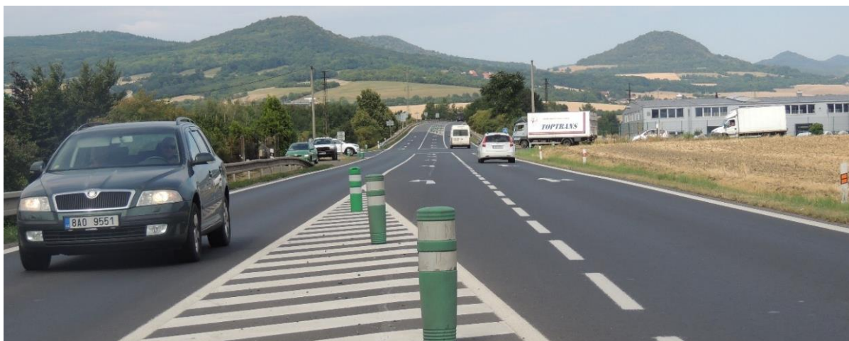
Obrázek 4: Pohled na křižovatku „U Kapličky“ z východní komunikace [12]
