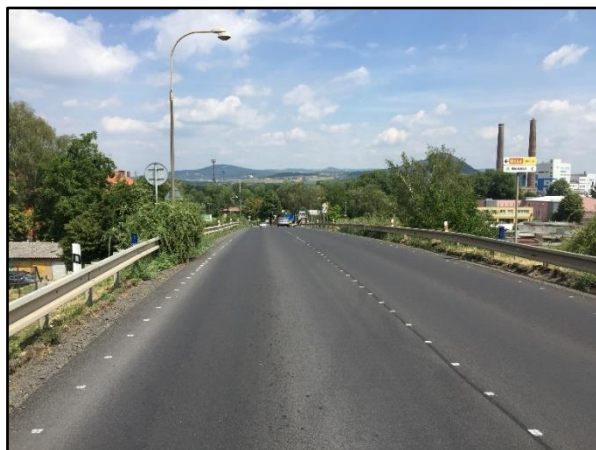
Obr. č. 18 – Zhoršené sklonové poměry (ze směru I/15 Třebenice)
