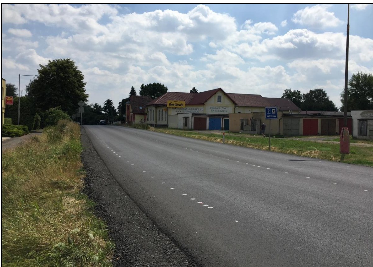
Obr. č. 13 – Pohled na západní rameno křižovatky směr I/15 Terežín
