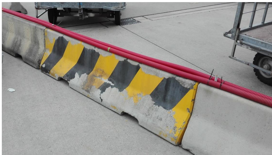
Obrázek 9 - svodidla typu New Jersey [zdroj: vlastní]
