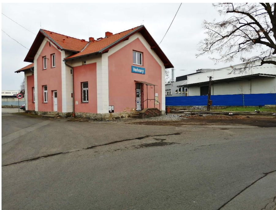
Obrázek 11 - Prostor před výpravní budovou žst. Velvary; Zdroj: autor
