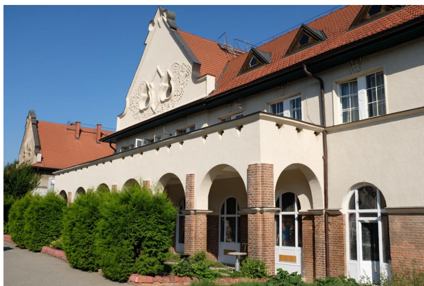
Obrázek č. 7.6, Budova bistra, vlastní zpracování
