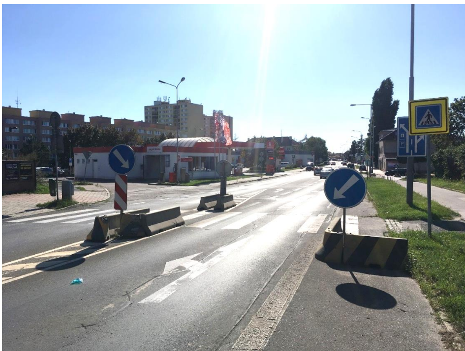
Obrázek 2-4 dopravní značení východního paprsku ulice Náchodská (foto Hochman 2019)
