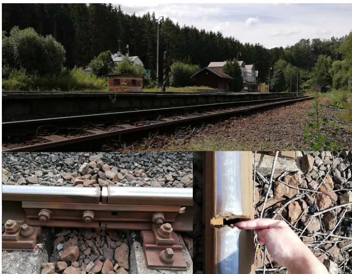
Obr. 4.13: Špatný stav kolejnicových styků v žst. Leděčko
