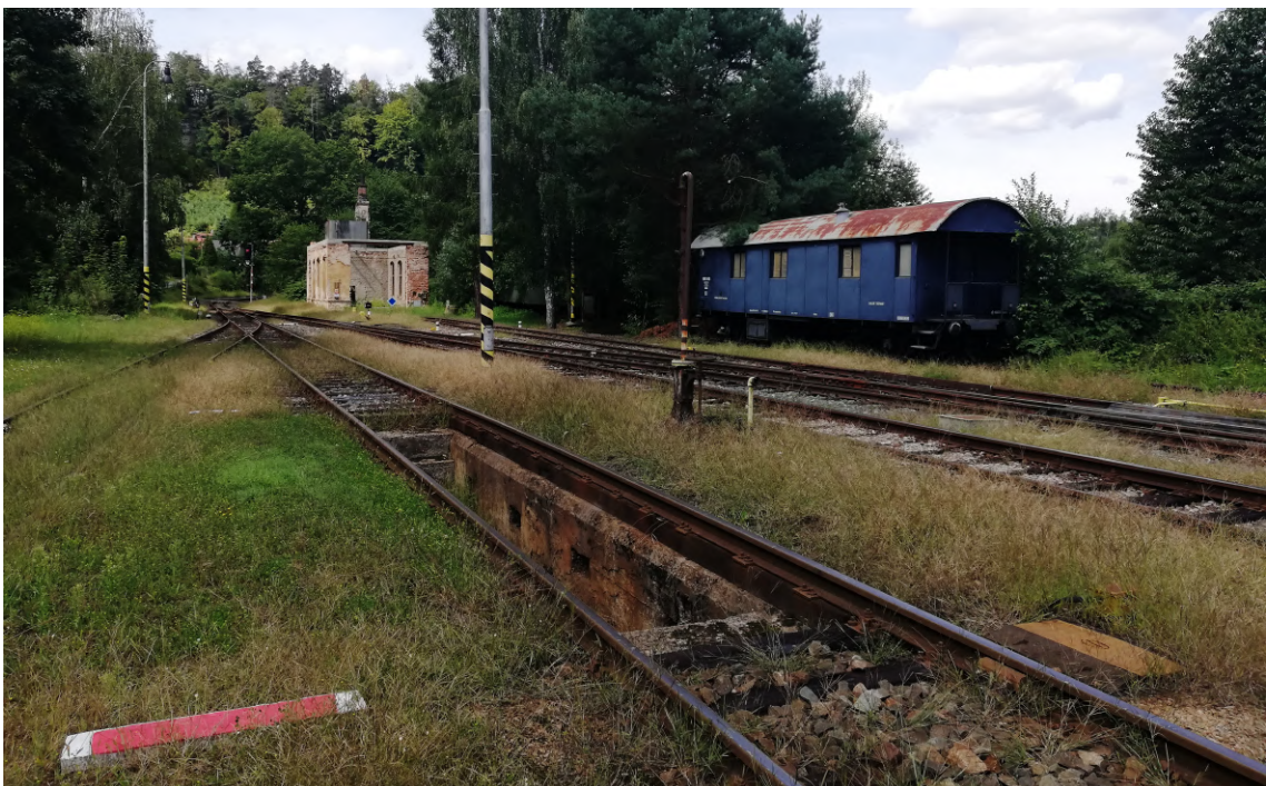
Obr. 4.7: Zařízení pro parní provoz a výtopna a ubytovací vozy v Leděčku
