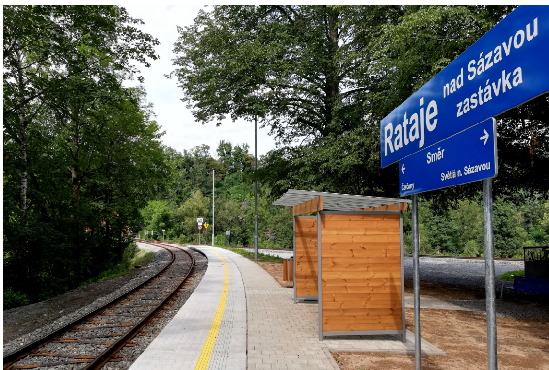
Obr. 4.16: Zastávka Rataje nad Sázavou zastávka po opravě
