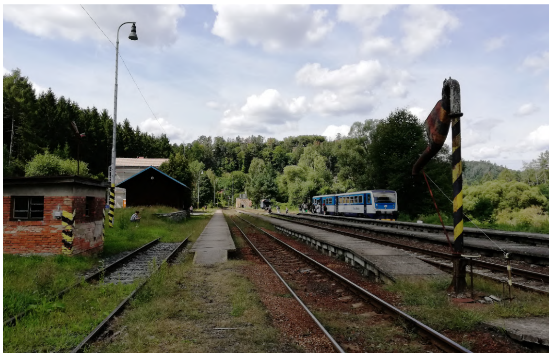
Obr. 4.11: Kolejíště před výpravní budovou (vlevo: manipulační kolej s boční rampou a skladištěm, osvětlovací stožáry, kolejová váha; vpravo: příjezd Os od Kolína, vodní jeřáb)
