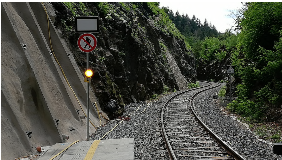
Obr. 4.17: Sanace skály v zářezu za zastávkou Rataje („průkop na Viklavě“)
