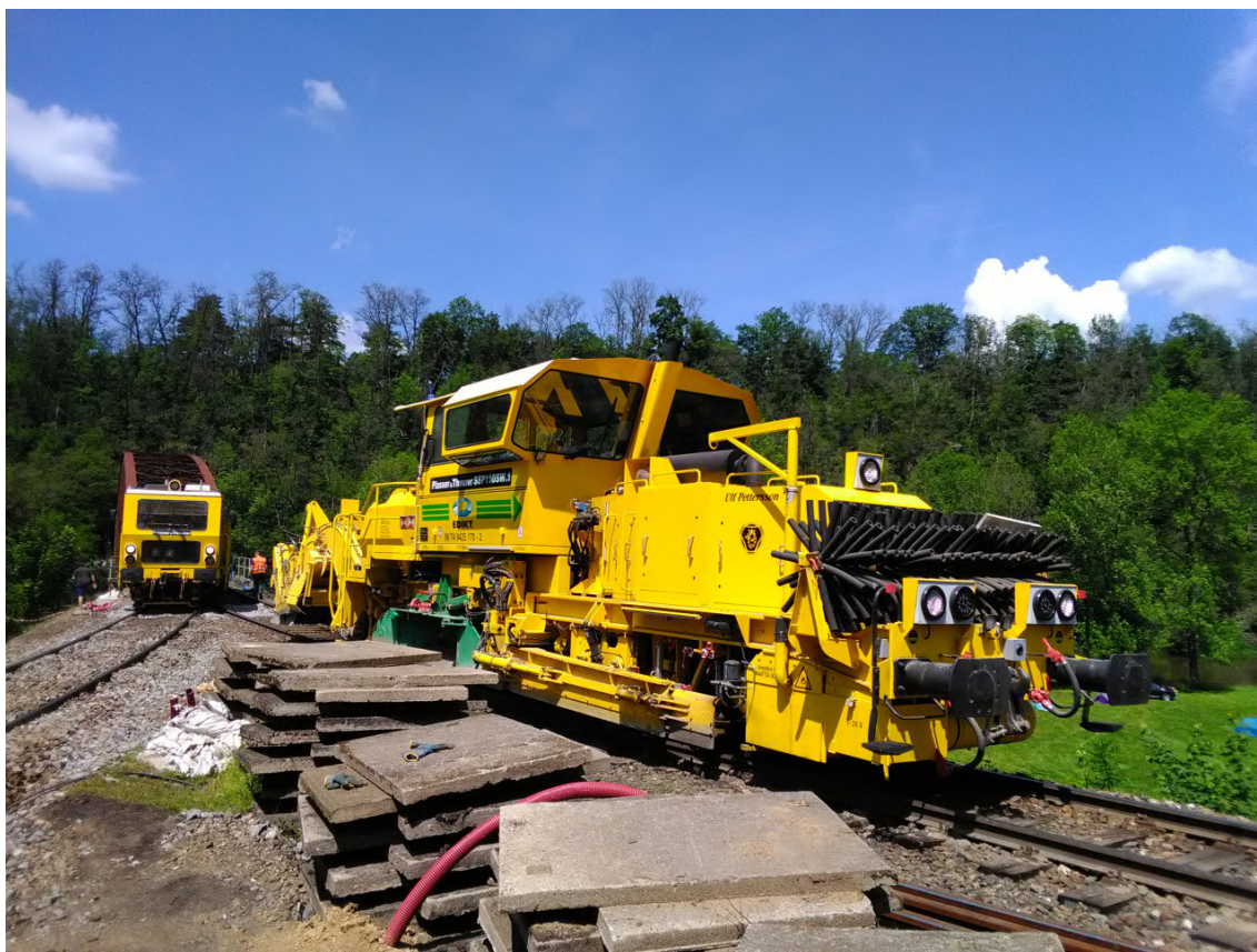
Obr. 4.15: Stroje na čištění kolejového lože a úpravu GPK v Ratajích [38]
