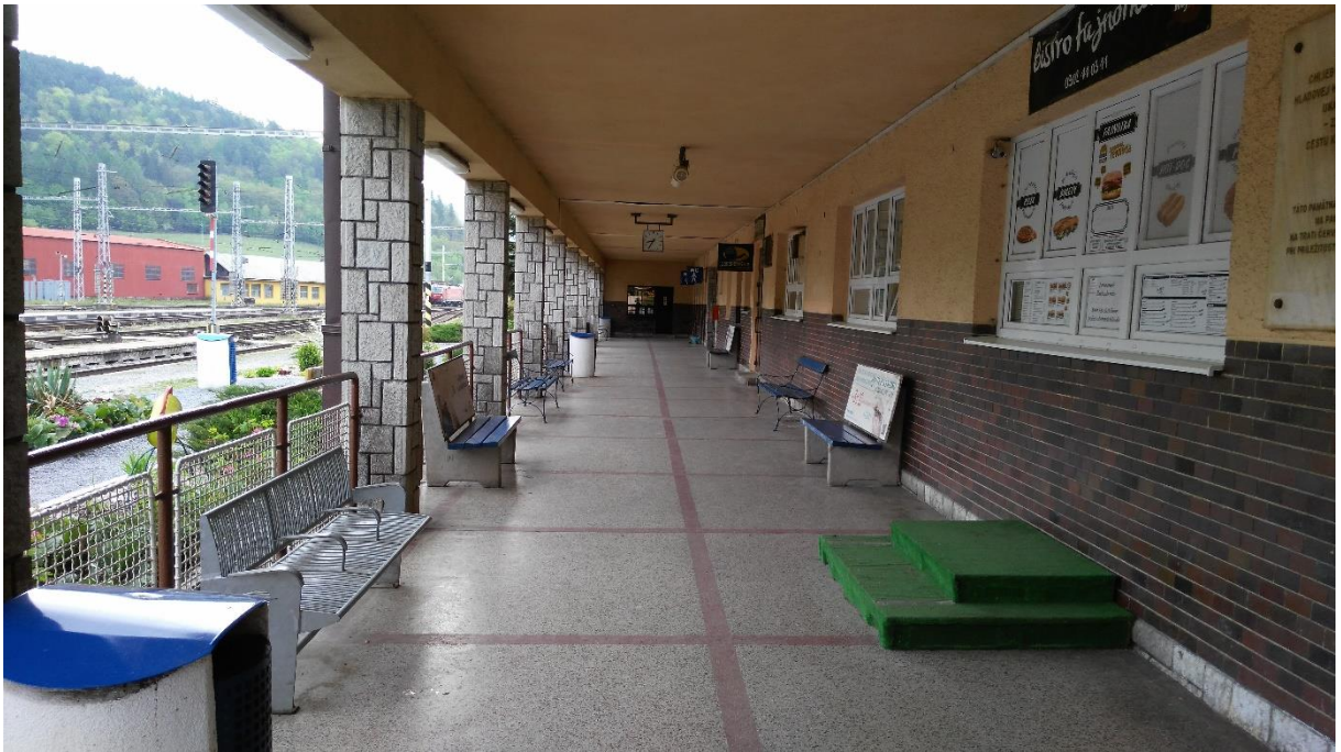
Žst. Margecany, vnější terasa na straně kolejiště
