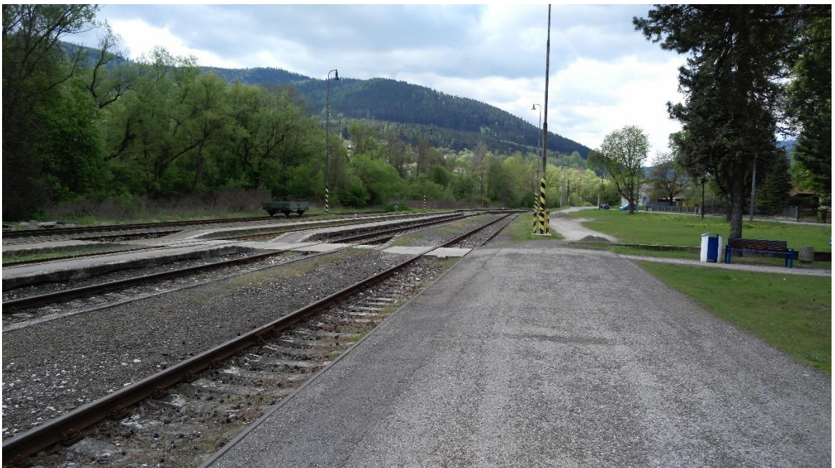
Žst. Gelnica, pohled na kolejiště z prostoru před výpravní budovou
