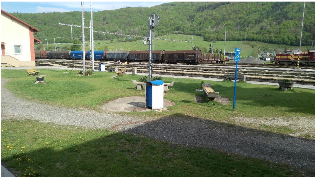
Žst. Margecany, venkovní plocha u nástupiště č.1 využívaná cestujícími
