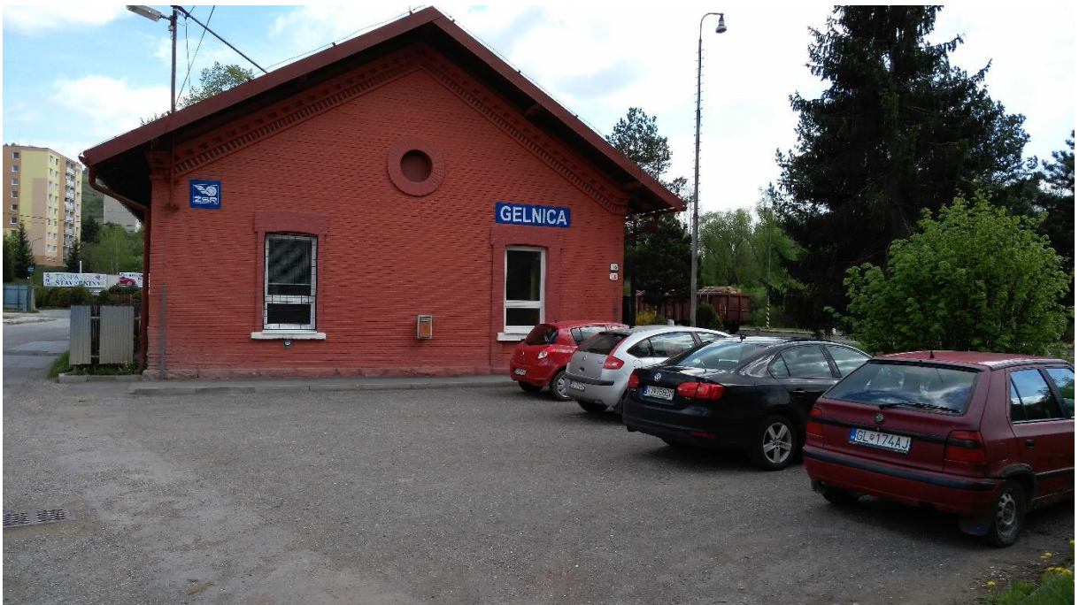
Žst. Gelnica, pohled na výpravní budovu a parkoviště od ulice
