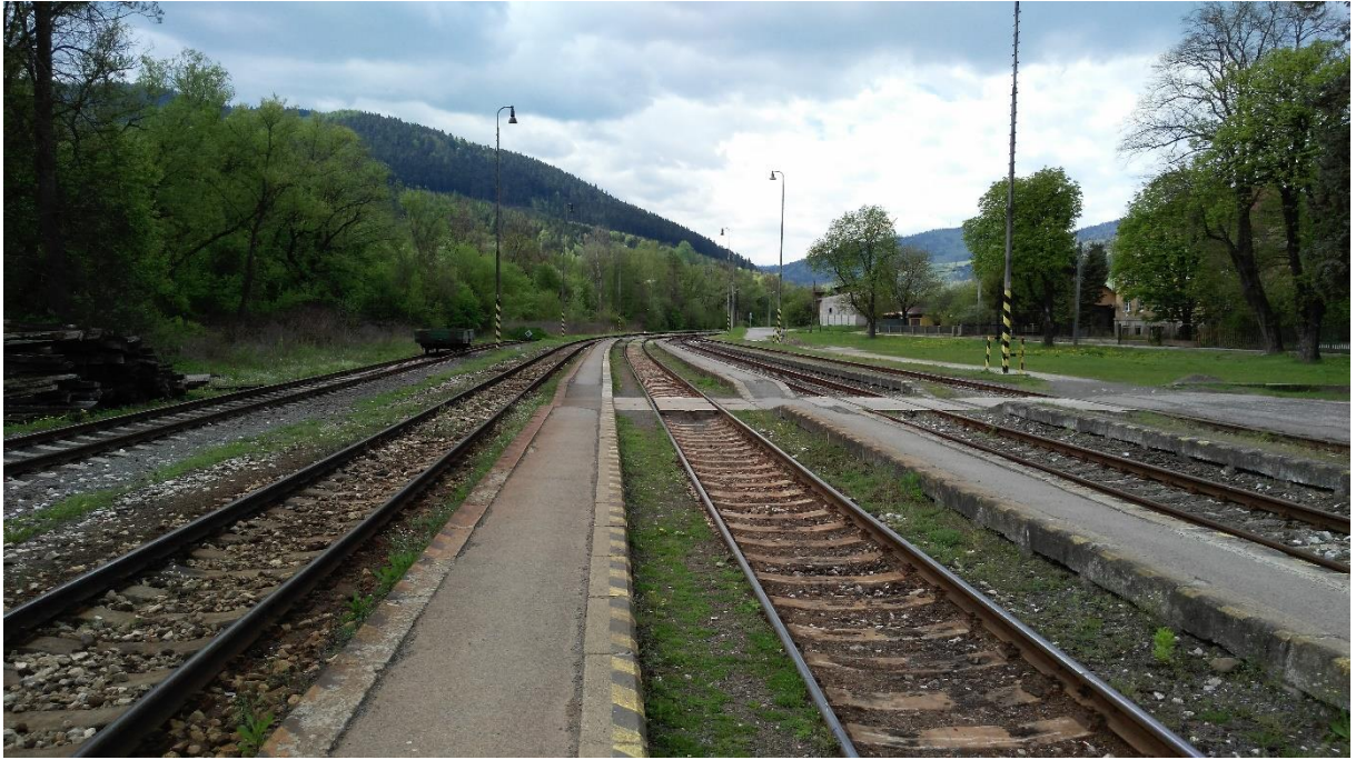
Žst. Gelnica, pohled na kolejiště z nástupiště č.3
