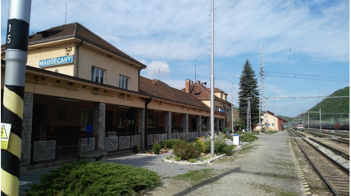
Žst. Margecany, výpravní budova ze strany kolejiště
