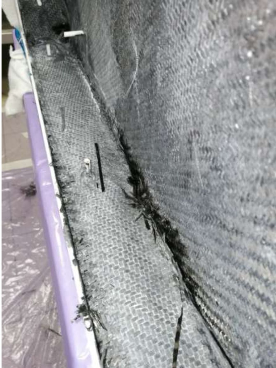
Obr. 40.: Delaminace vrstvy uhlíku na formách
