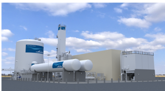
(a) Zařízení na separaci vzduchu (Adele, USA) ( https://www.linde-engineering.com/en/images/s_20180704_119319_8928_tcm19-482244.png )
