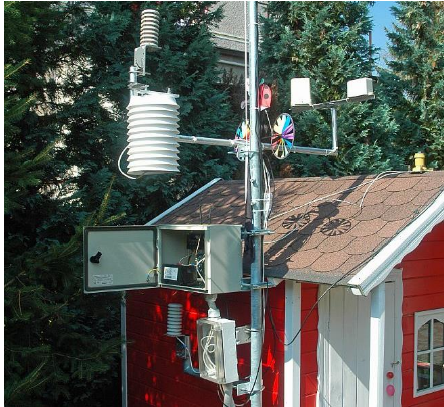
Obr. 8.1 - Meteorologická stanice, Brandýs nad Labem [6]
