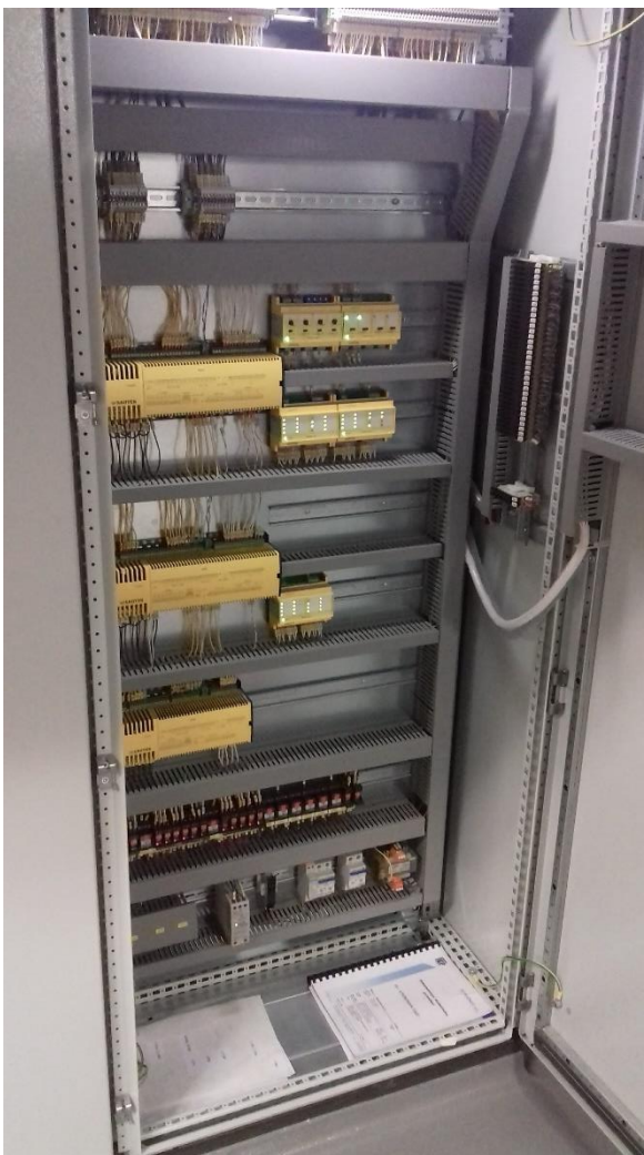
Obr. 6.4 - AS modu225, tři kusy stanic v levé části rozvaděče, doplněno v pravé části o rozšiřovací moduly
