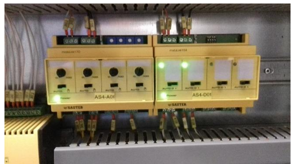
Obr. 6.3 - Rozšiřovací moduly zleva moduLink170 a moduLink164
