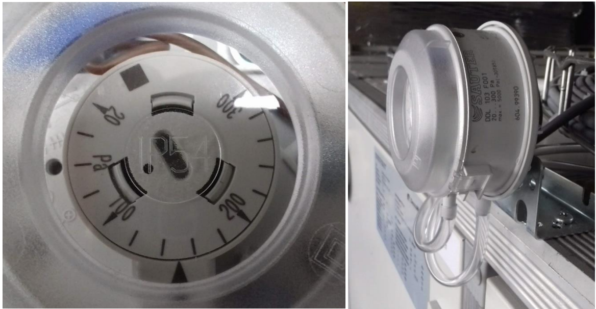
Obr. 4.3 - Regulátor tlakové diference Sauter DDL 103 F001, nastaven na hodnotu 150 Pa
