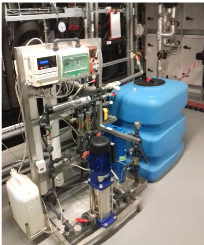
Obr. 4.6 - Jednotka úpravny vody Carel
