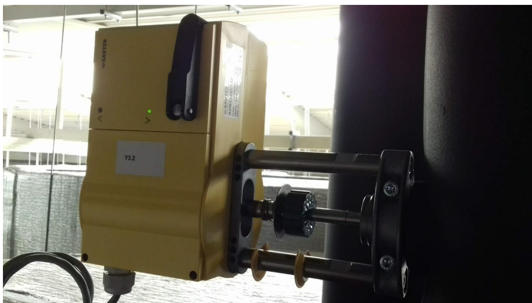
Obr. 4.7 - Regulátor polohy AVM 234S F132
