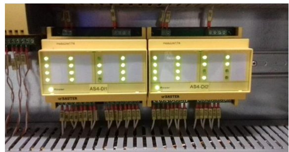
Obr. 6.2 - Rozšiřovací moduly 2x moduLink174
