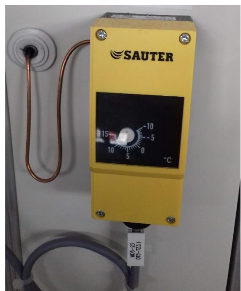
Obr. 4.4 - Termostat s kapilárovým čidlem
