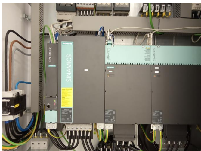
Obrázek 99: Zapojení stroje Weldprint
