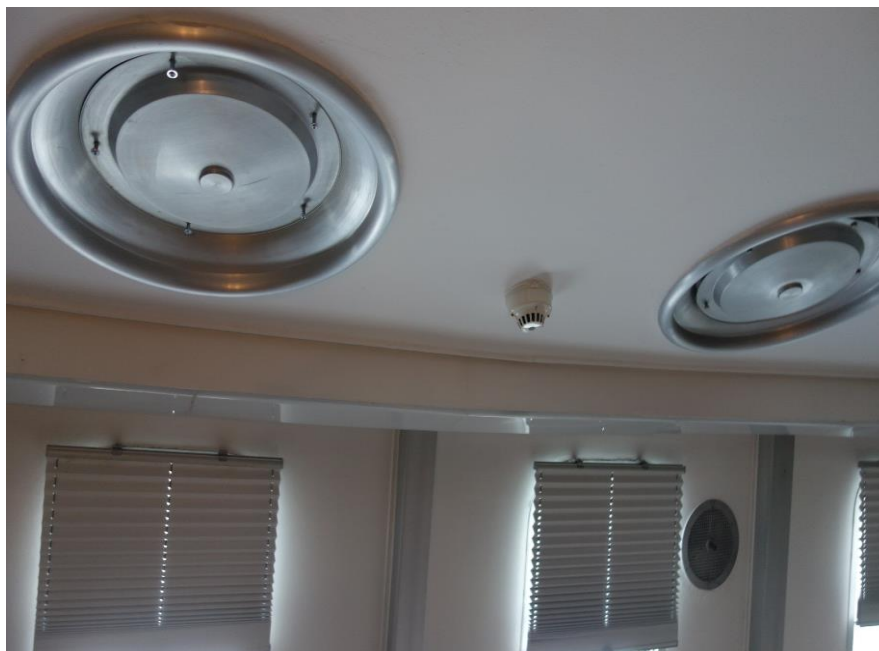
Obr. 3.5 Talířové stropní ventily
