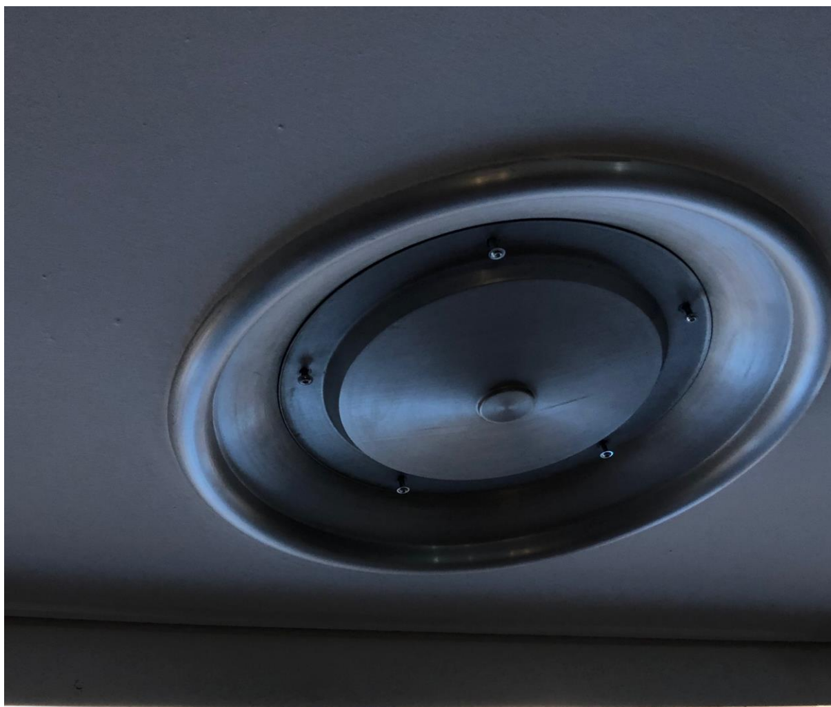
Obr. 7 - 1 Původní talířový ventil
