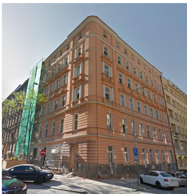
Obr. 1-1 Fotografie bytového domu Mánesova 983/36
