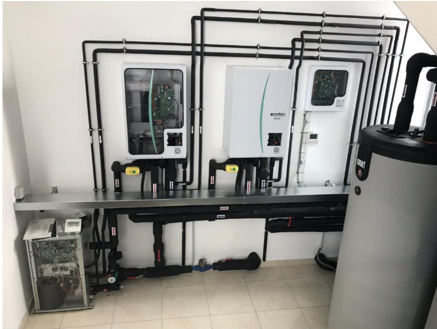
Obrázek 8: Vnitřní jednotka tepelného čerpadla Ecodan
