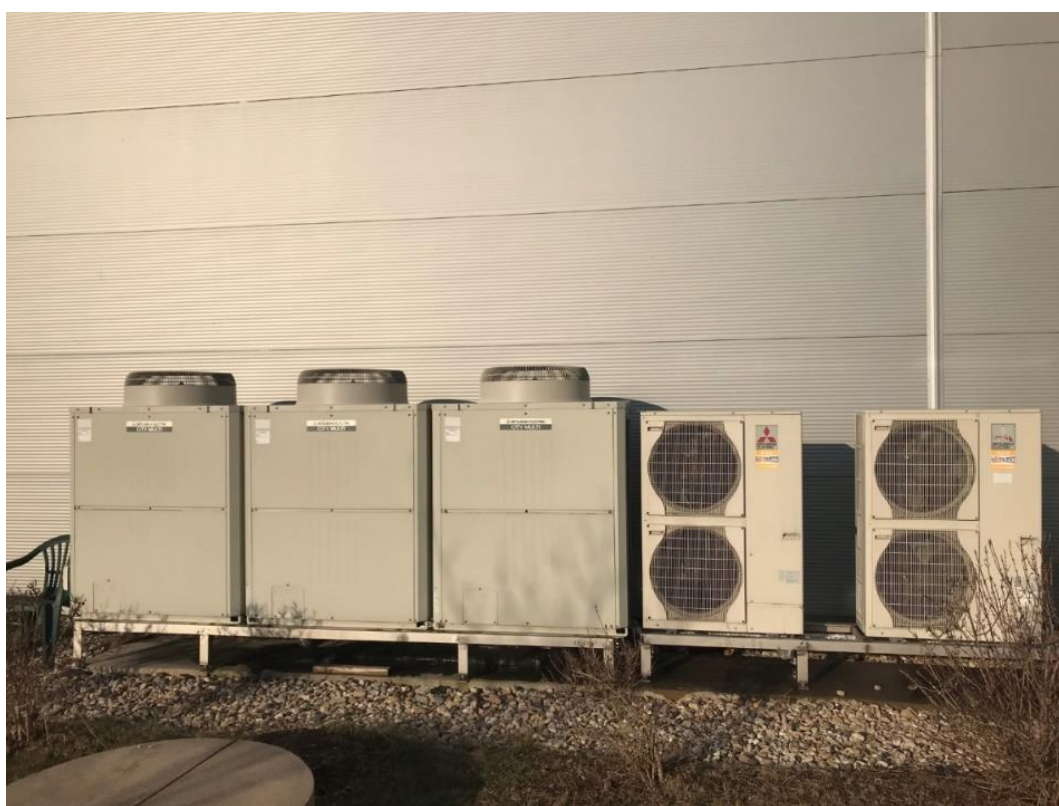
Obrázek 4: Venkovní klimatizační jednotky a tepelná čerpadla Zubadan
