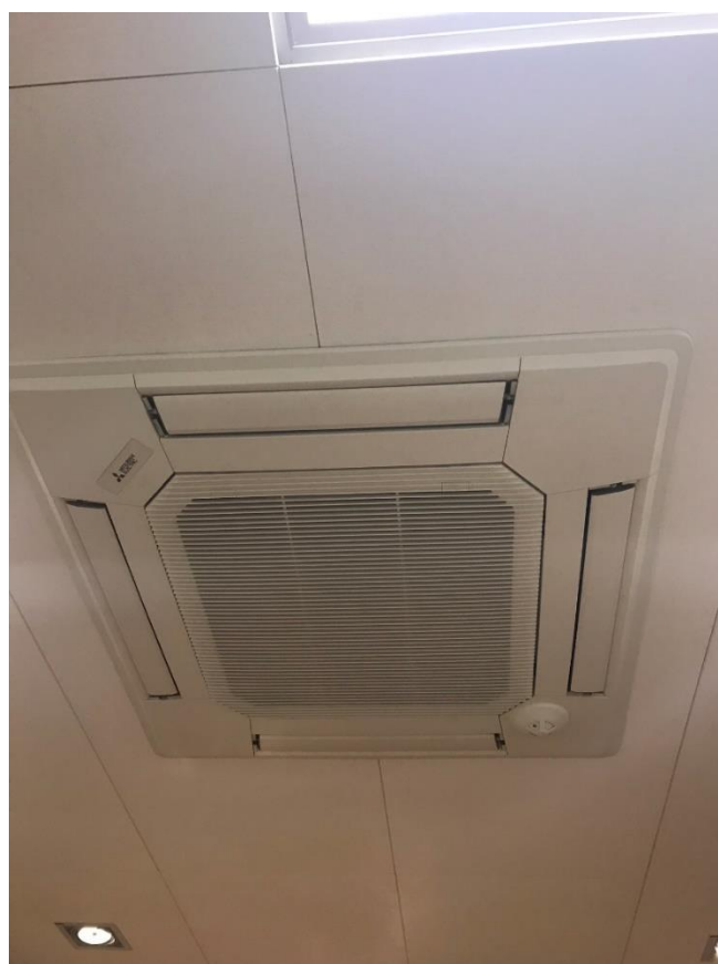
Obrázek 6: Vnitřní čtyřcestná kazetová jednotka
