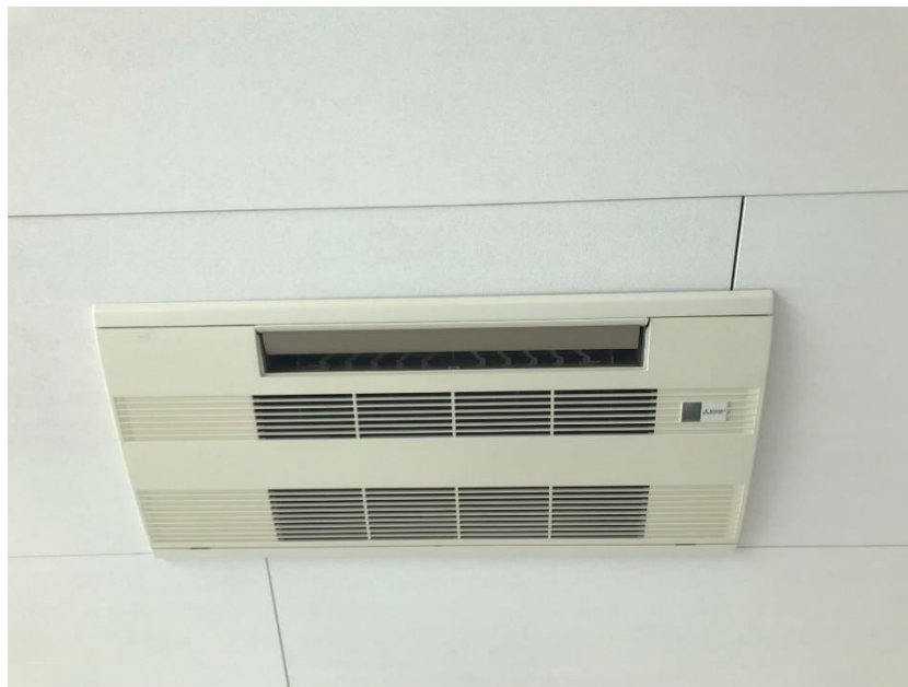
Obrázek 7: Vnitřní jednocestná kazetová jednotka[3]
