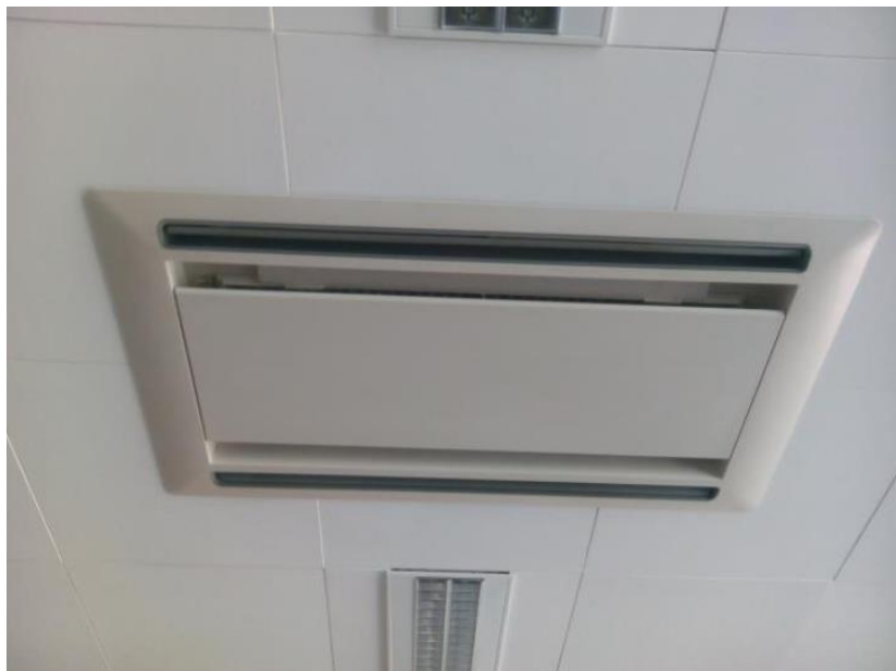
Obrázek 5: Vnitřní dvoucestná kazetová jednotka
