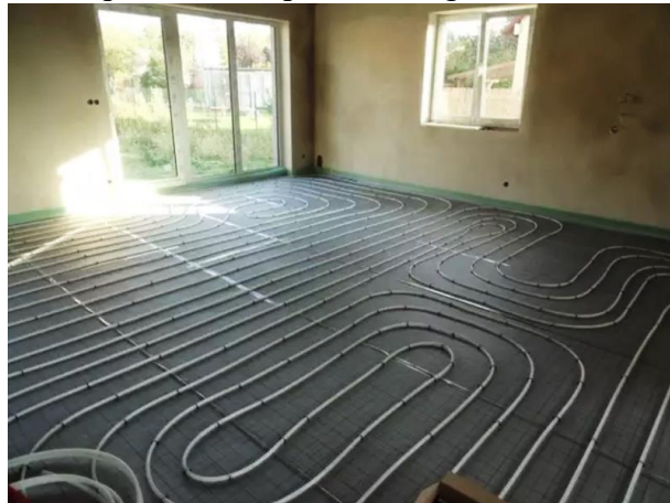
Obr. 38 Použití FV Therm systémové role v rodinném domě [15]
