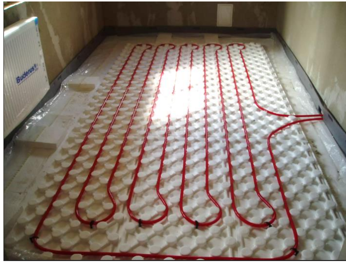
Obr. 13 Tvarování otopného hadu tvar meandru (uchycení do systémové desky) [12]
