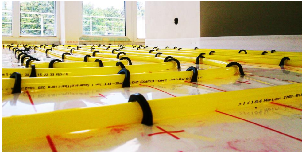
Obr. 28 Fixování plastovými příchytkami do izolační desky [10]
