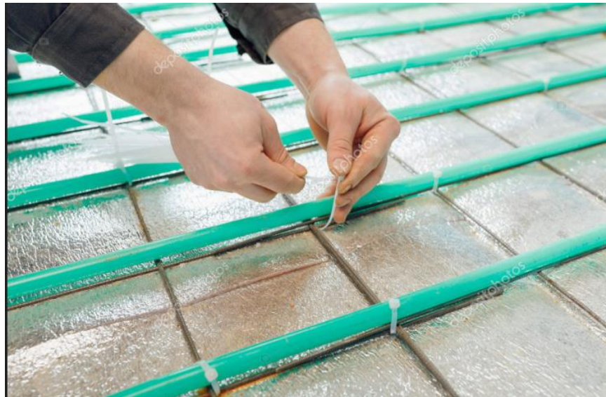
Obr. 25 Přivazování na ocelovou síť [8]
