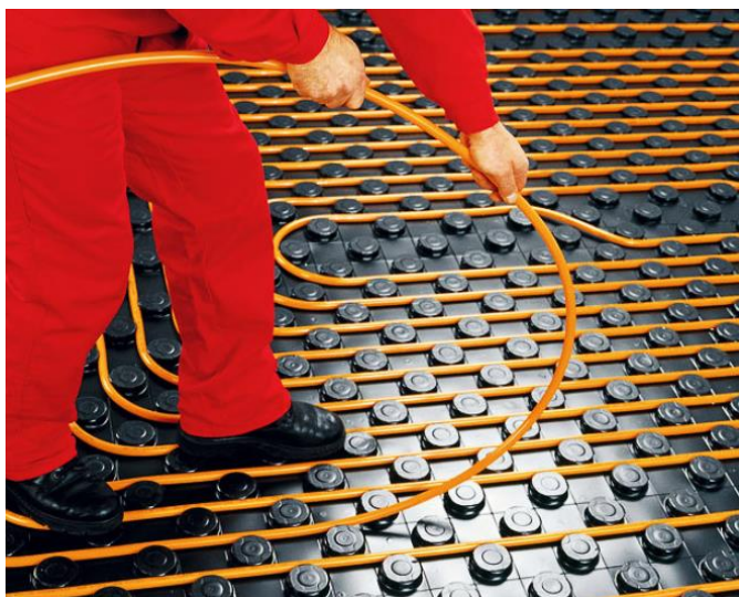
Obr. 30 Zatlačení trubek do systémové desky [11]
