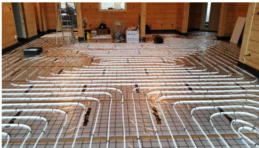
Obr. 14 Tvarování otopného hadu do tvaru plošné spirály (uchycení trubek plastovými příchýtkami) [13]
