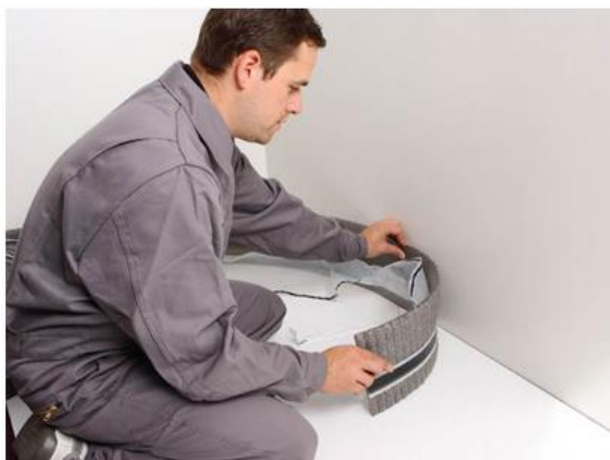
Obr. 22 Montáž dilatačního pásu REHAU [7]
